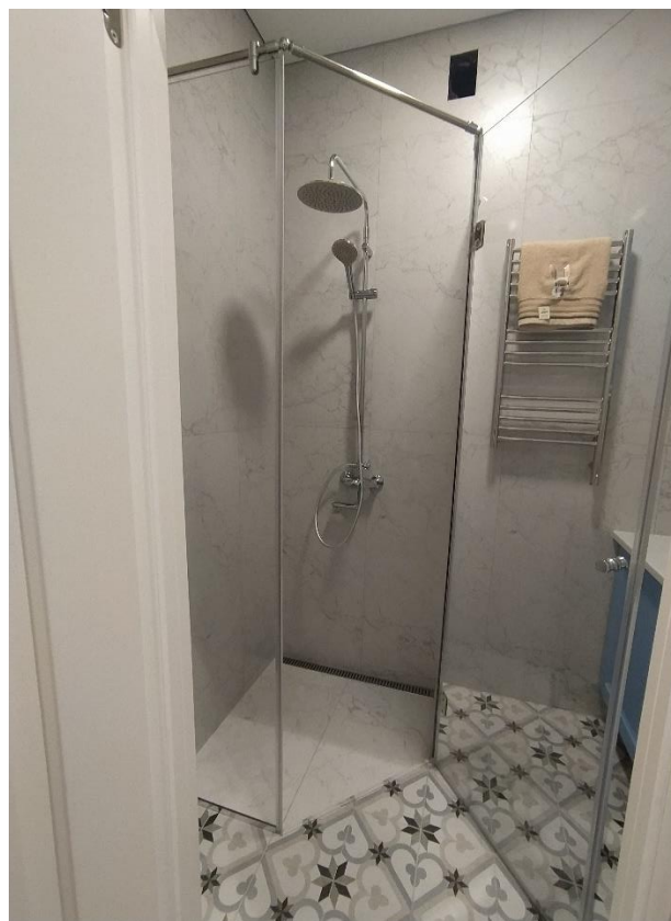
Фото 13. Вид на пом. душевой (пом. 3)
