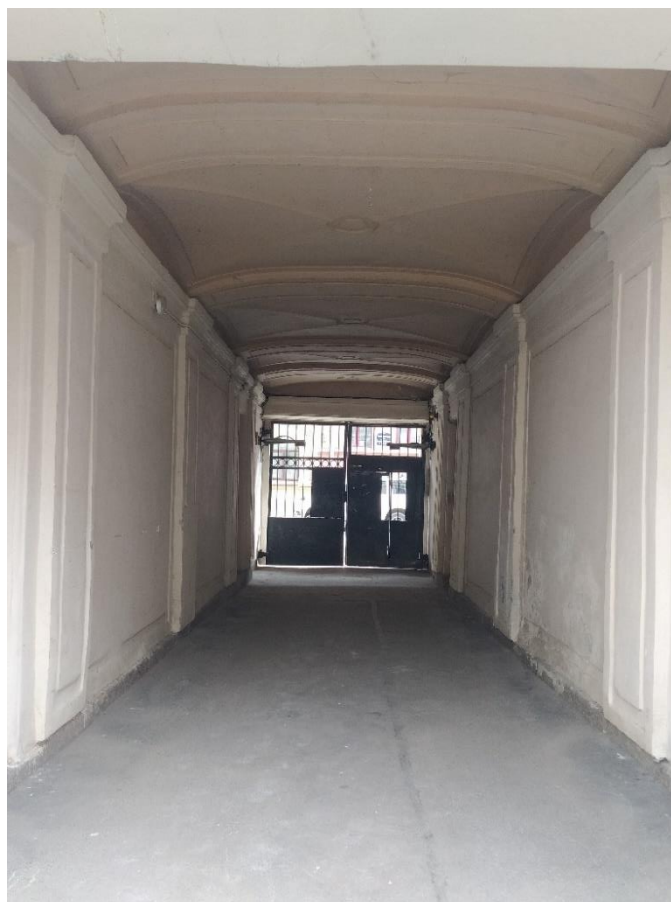
Фото 2. Воротный проезд. Вид со стороны двора.
