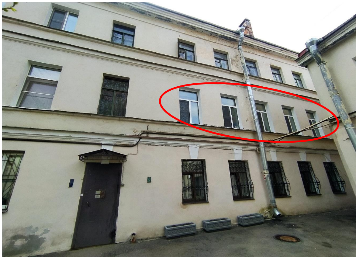
Фото 11. Вид на окна квартиры № 63 на фасаде трёхэтажного западного дворового корпуса здания.
