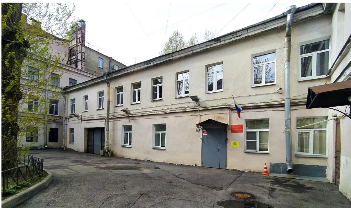
Фото 7. Вид на юго-западный фасад двухэтажного поперечного корпуса здания. Вид в западном направлении.
