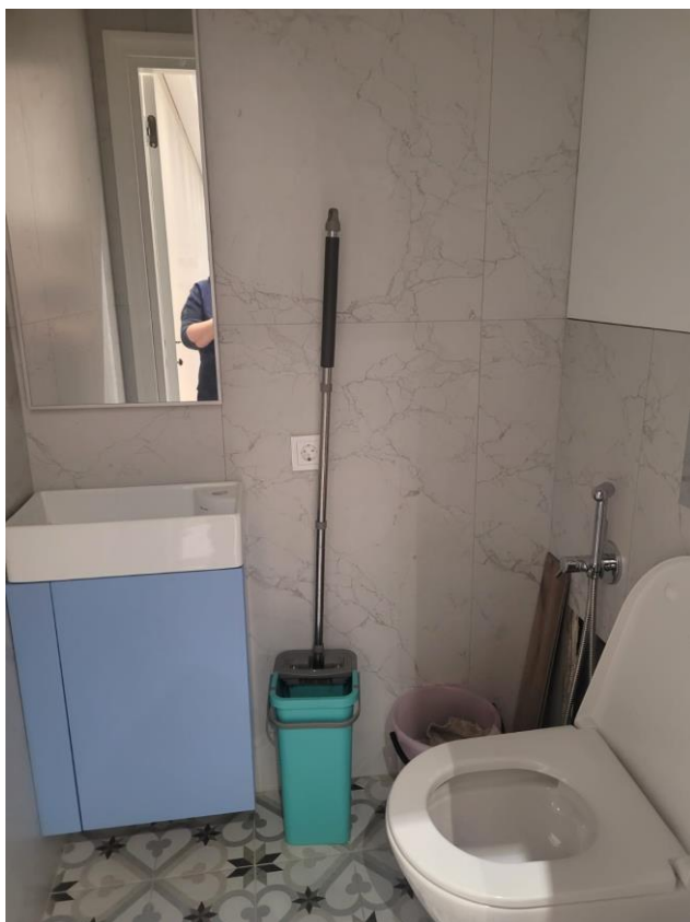
Фото 12. Вид на помещение туалета (пом. 2)
