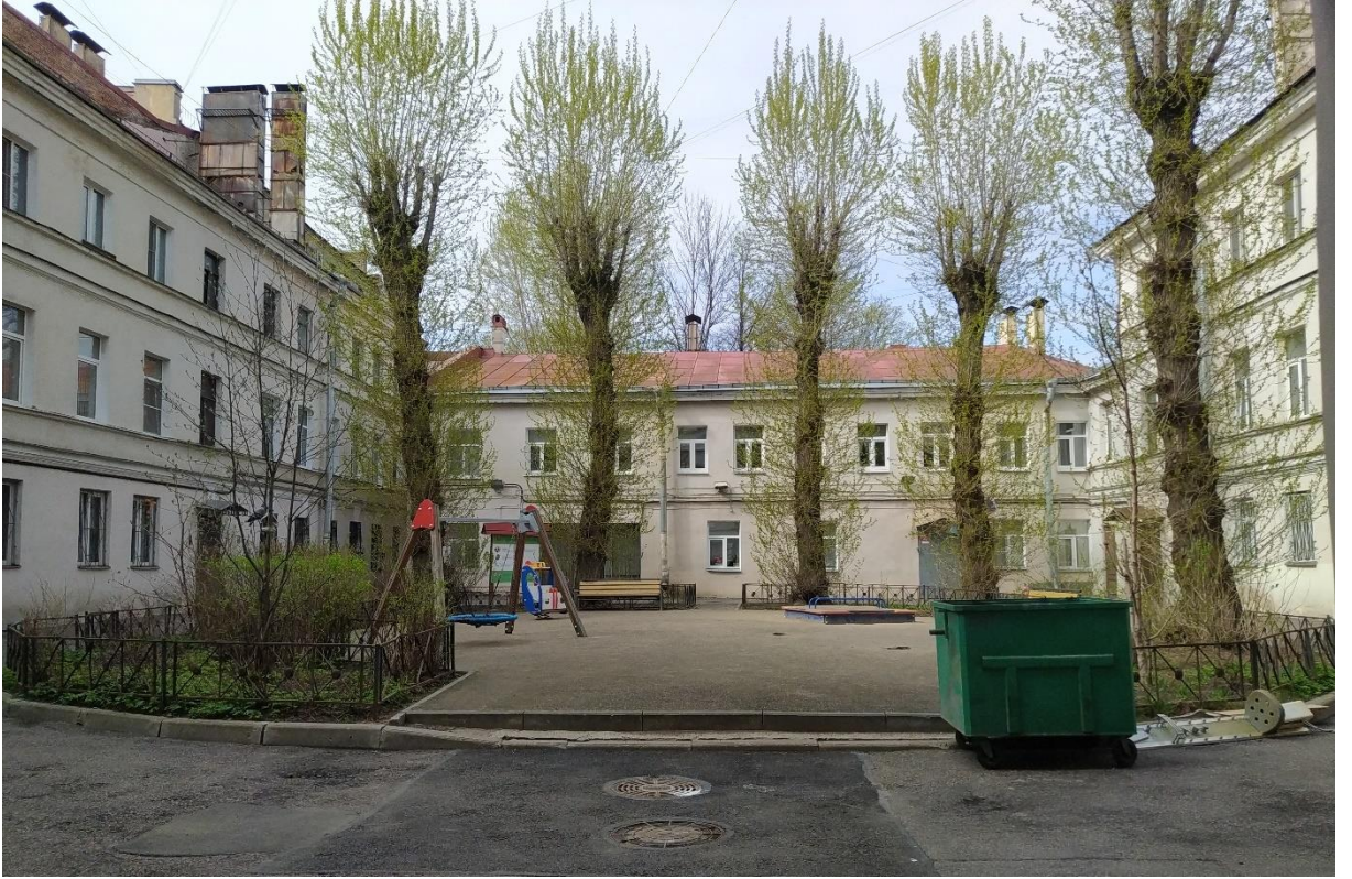
Фото 3. Объект культурного наследия регионального значения «Жилой дом». Вид на дворовые фасады в северо-западном направлении.
