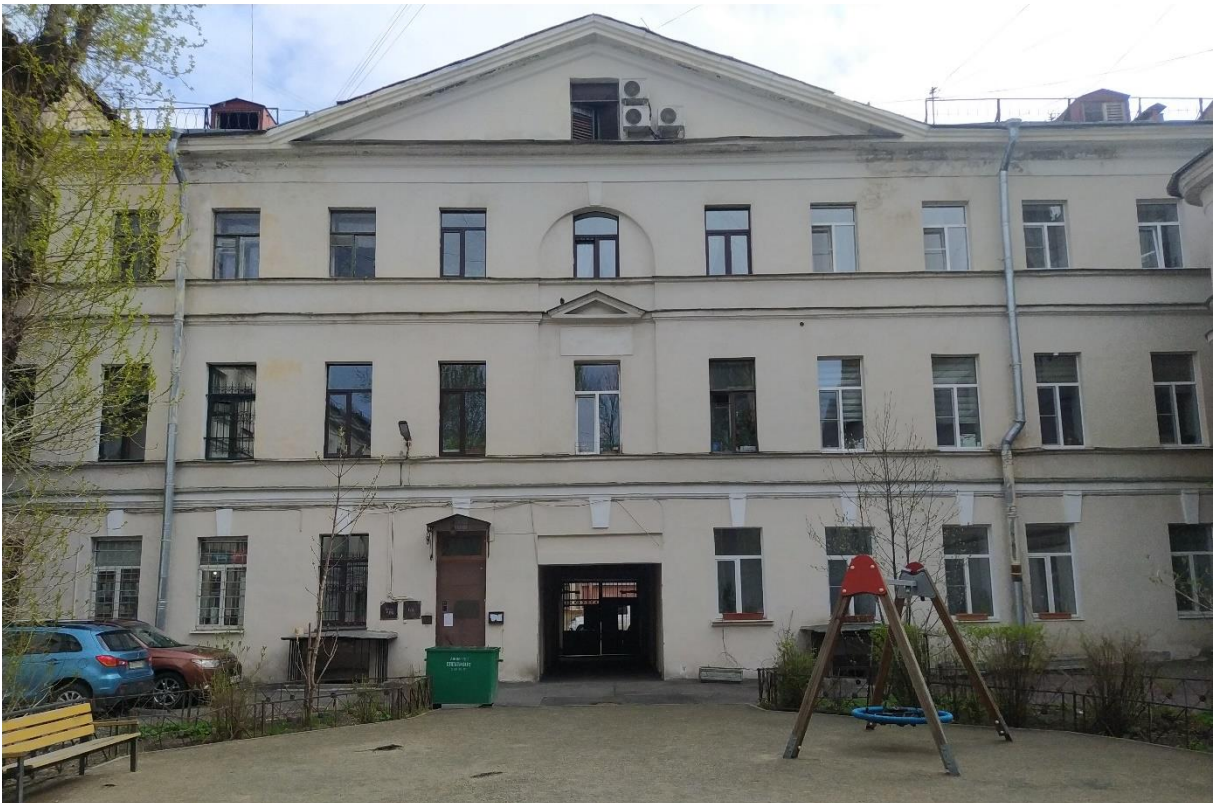
Фото 4. Северный фасад лицевого корпуса здания (со стороны двора). Вид в юго-восточном направлении.
