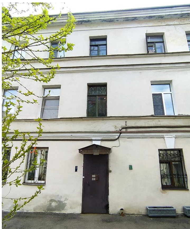
Фото 12. Северо-восточный фасад трёхэтажного дворового корпуса здания. Вход в подъезд (ЛК № 4).
