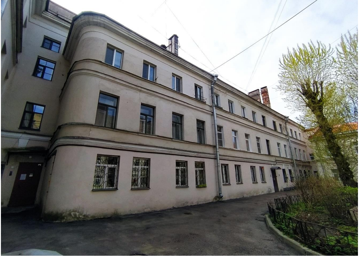
Фото 9. Вид в северном направлении на северо-восточный фасад трёхэтажного западного дворового корпуса здания.
