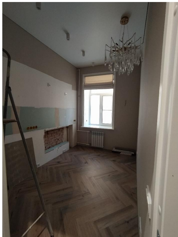
Фото 15. Вид от входа в кухню в сторону окна (пом. 4)
