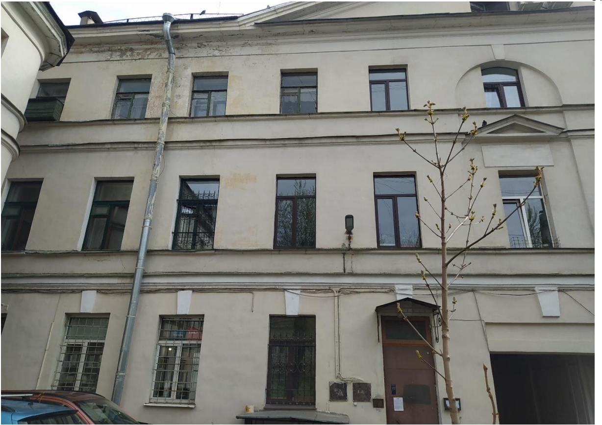
Фото 5. Северный фасад лицевого корпуса здания (со стороны двора). Вид в юго-восточном направлении. Фрагмент.
