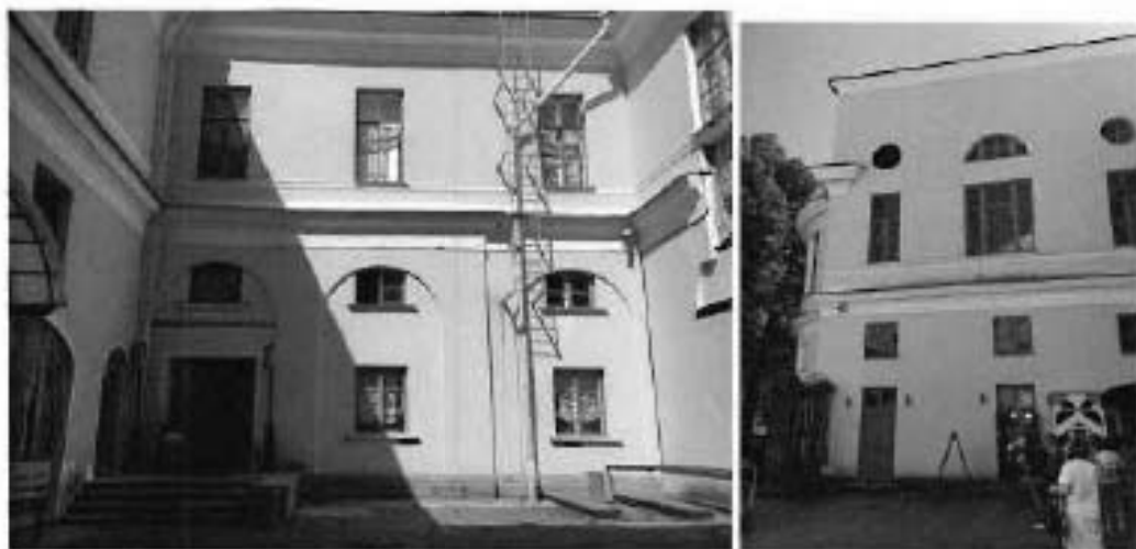
16, 17. Общий вид фасадов со стороны внутреннего двора.
