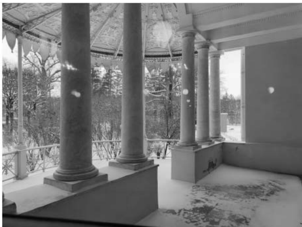
17. Южный прямоугольный (церковный) корпус. Первый этаж. Вид из Колонного зала в Собственный сад.
