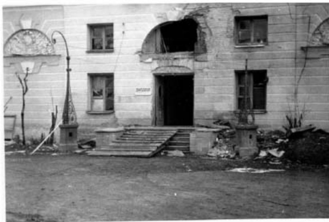
17. Поврежденный фасад Северного корпуса 1944г. https://pastvu.com/
