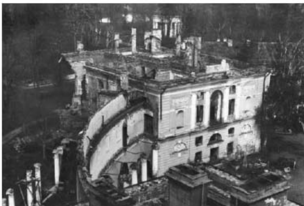
20. Разрушенный северный корпус и галерея. 1944г. https://pastvu.com/ .
