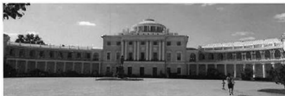
2. Общий вид на боковой и служебный корпус (северное крыло).
