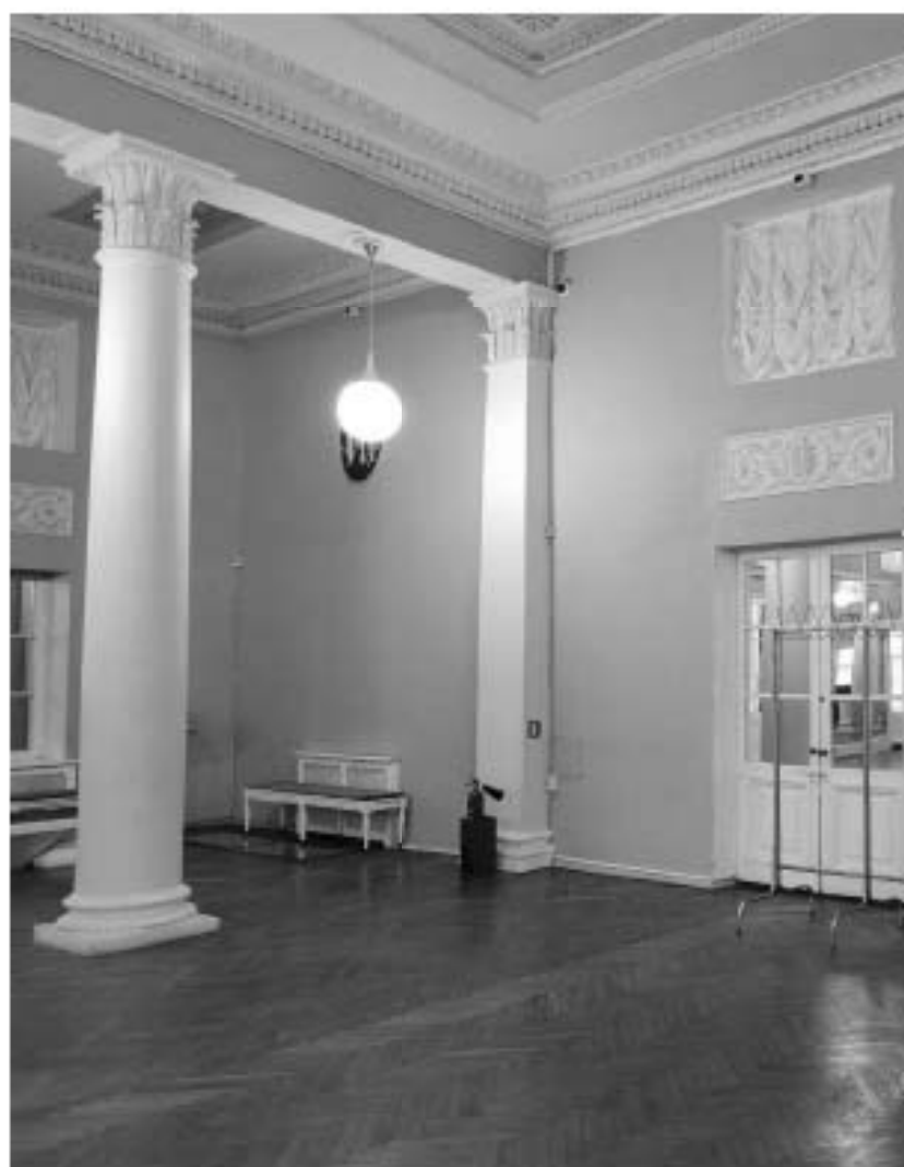
19. Южный прямоугольный (церковный) корпус. Первый этаж. Колонный зал
