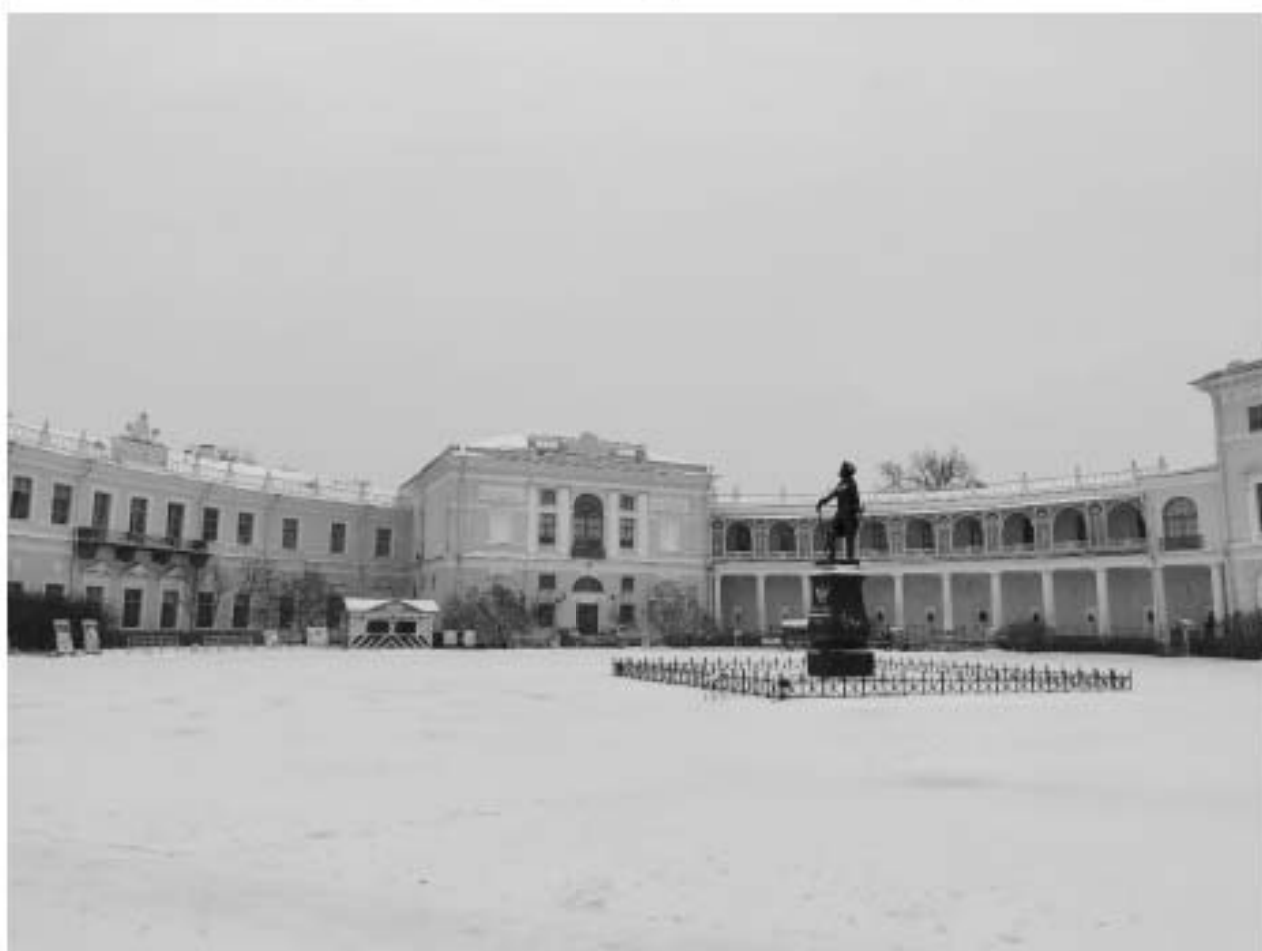
2. Юго-восточный полуциркулярный корпус. Фасад со стороны плаца.
