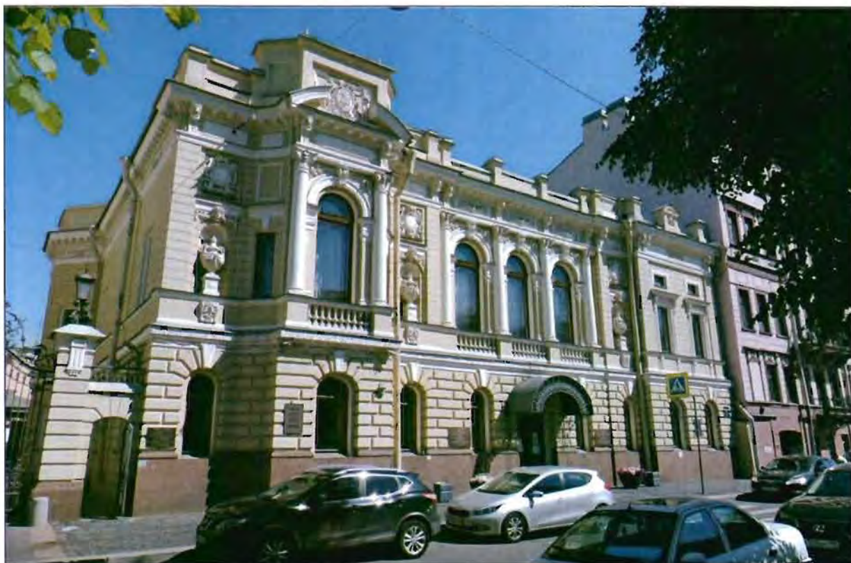
2. Лицевой фасад по Фурштатской улице.
