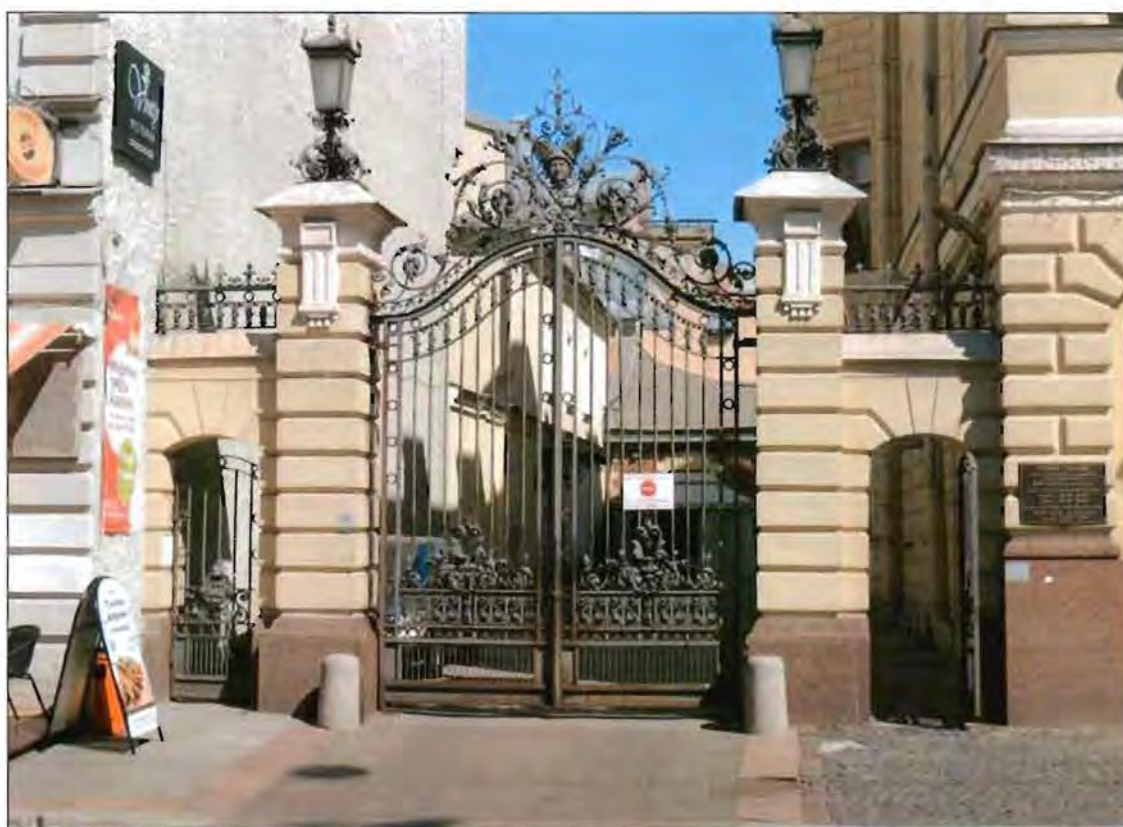
1. Лицевой фасад по Фурштатской улице.
