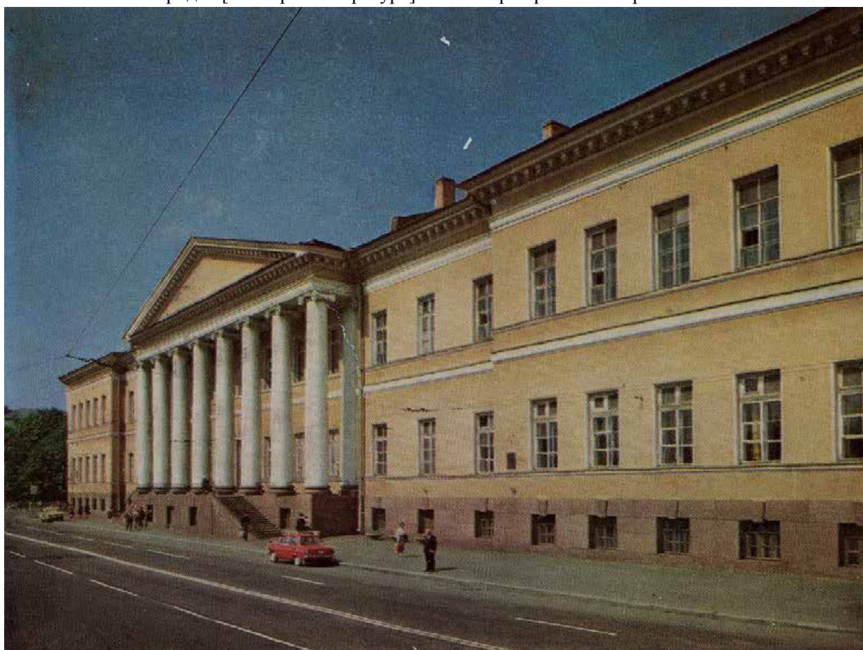
30. Здание Академии наук. 1981 г. — А. Кедринский и др. Восстановление памятников архитектуры Ленинграда, Ленинград, "Стройиздат", 1987. Издание второе, дополненное. 1987 г.
