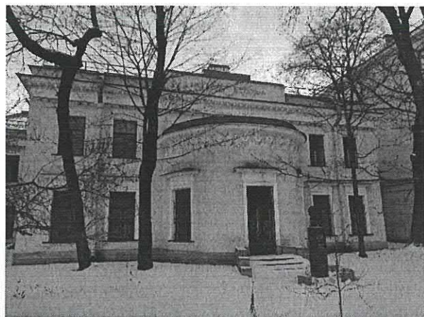
6. Лицевой фасад со стороны Московского пр.
