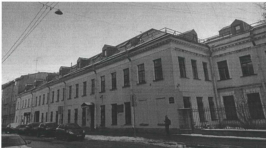
2. Лицевой фасад со стороны ул. 4-я Красноармейская
