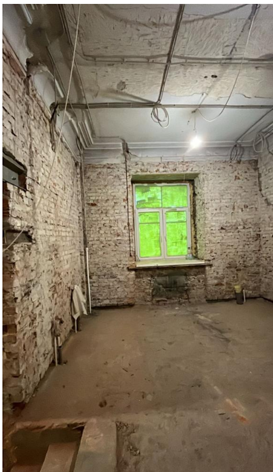
Фото 14. Интерьер пом. 1-Н выявленного объекта культурного наследия «Жилой дом»
