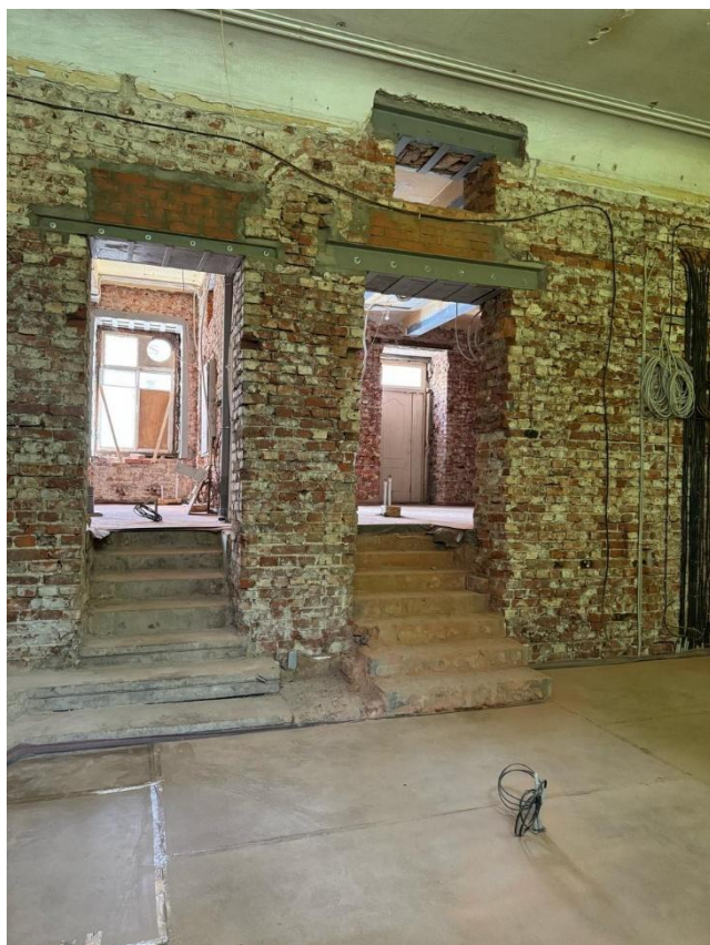
Фото 16. Интерьер пом. 1-Н выявленного объекта культурного наследия «Жилой дом»
