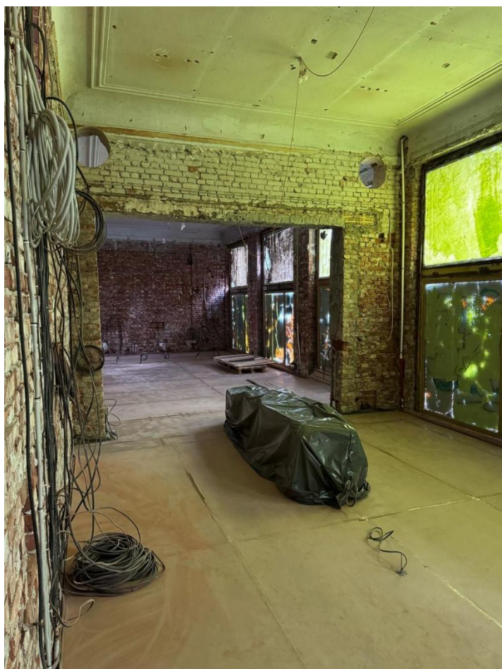
Фото 8. Интерьер пом. 1-Н выявленного объекта культурного наследия «Жилой дом»
