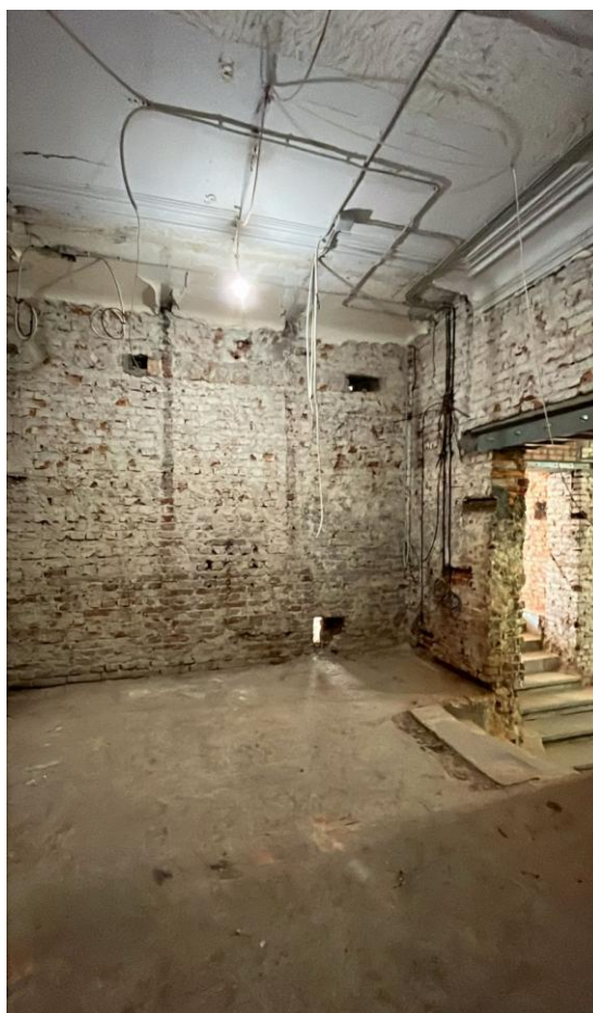
Фото 10. Интерьер пом. 1-Н выявленного объекта культурного наследия «Жилой дом»
