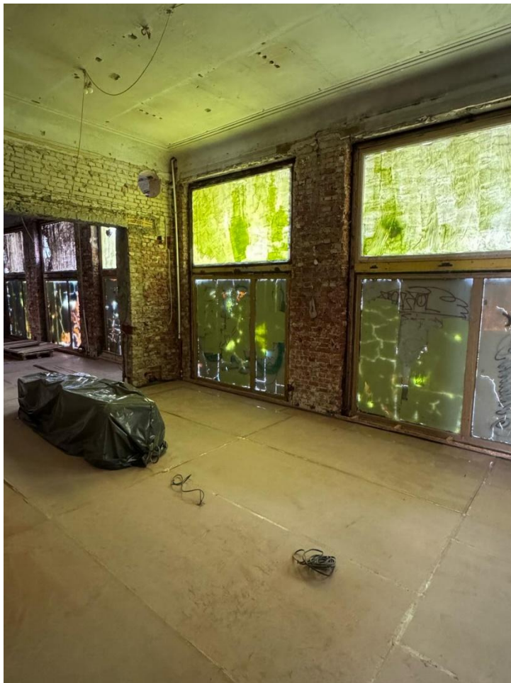
Фото 7. Интерьер пом. 1-Н выявленного объекта культурного наследия «Жилой дом»
