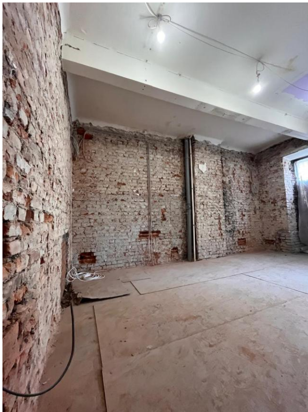
Фото 9. Интерьер пом. 1-Н выявленного объекта культурного наследия «Жилой дом»
