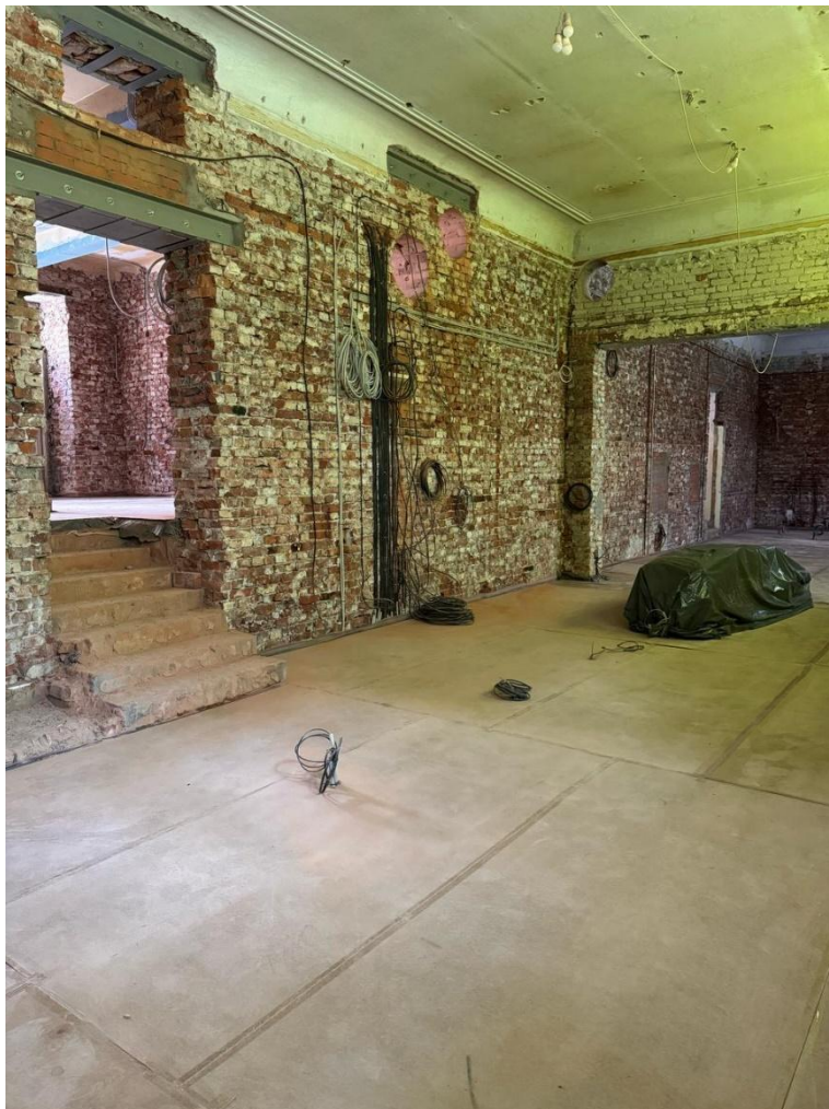
Фото 11. Интерьер пом. 1-Н выявленного объекта культурного наследия «Жилой дом»
