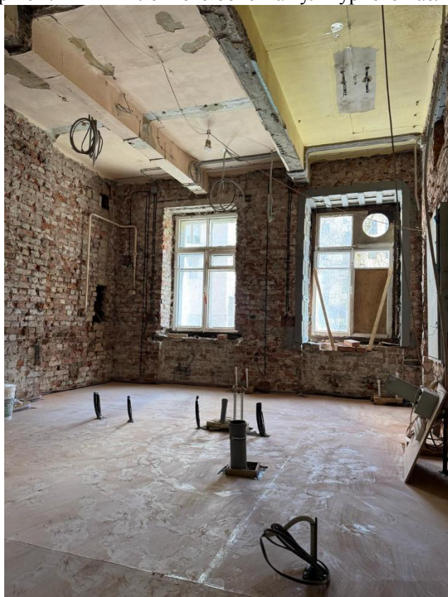
Фото 12. Интерьер пом. 1-Н выявленного объекта культурного наследия «Жилой дом»
