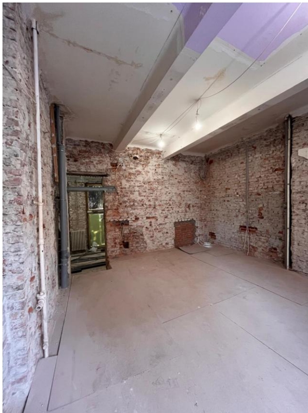
Фото 17. Интерьер пом. 1-Н выявленного объекта культурного наследия «Жилой дом»
