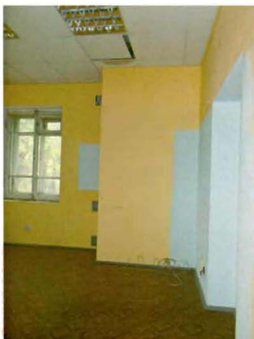
10. Интерьер помещения второго этажа.
