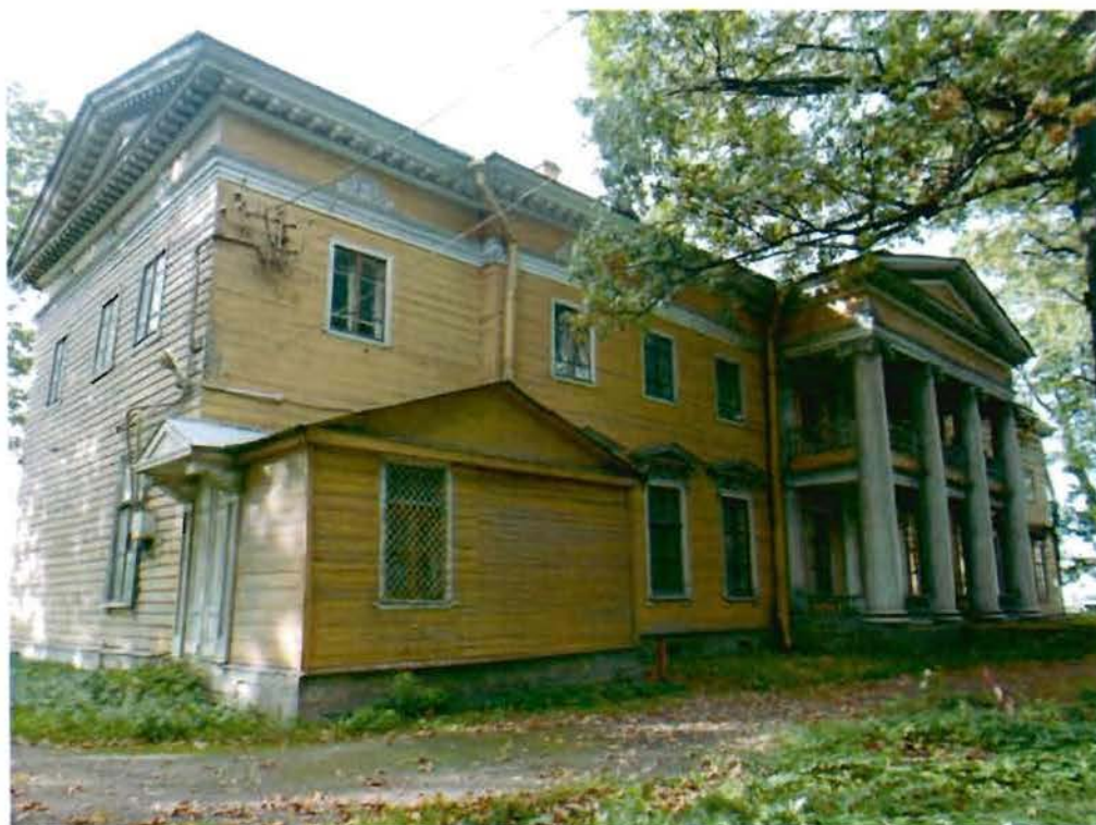
2. Общий вид с северо-востока.
