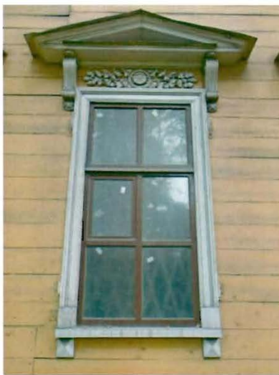
4. Оконный проем первого этажа.
