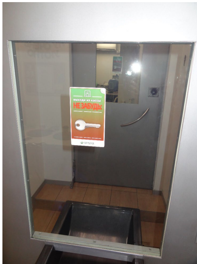
Фото 10. Переход между помещениями 13 и 11. Фрагмент. Дата фотофиксации: 09.04.25
