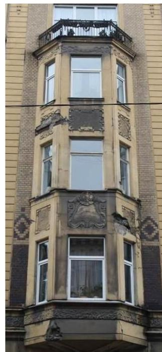
балкон на крыше эркера, трапециевидной формы, с металлическим ограждением (рисунок – вертикальные стойки, горизонтальные тяги, провисающие цветочные гирлянды с лавровыми венками по середине, пояс меандра);
