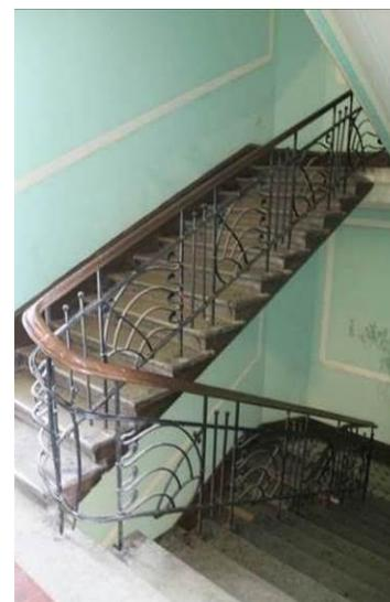
двухмаршевая межэтажная лестница, в центральной части поперечного дворового корпуса – с известняковыми ступенями и металлическим ограждением (рисунок – вертикальные стойки с набалдашниками, волнообразные тяги с завитками на концах, горизонтальные тяги), с деревянными профилированными поручнями, на косоурах;
