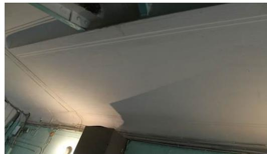
потолок лестничной клетки оформлен профилированной тягой по периметру; в верхних частях стен – профилированный карниз;
