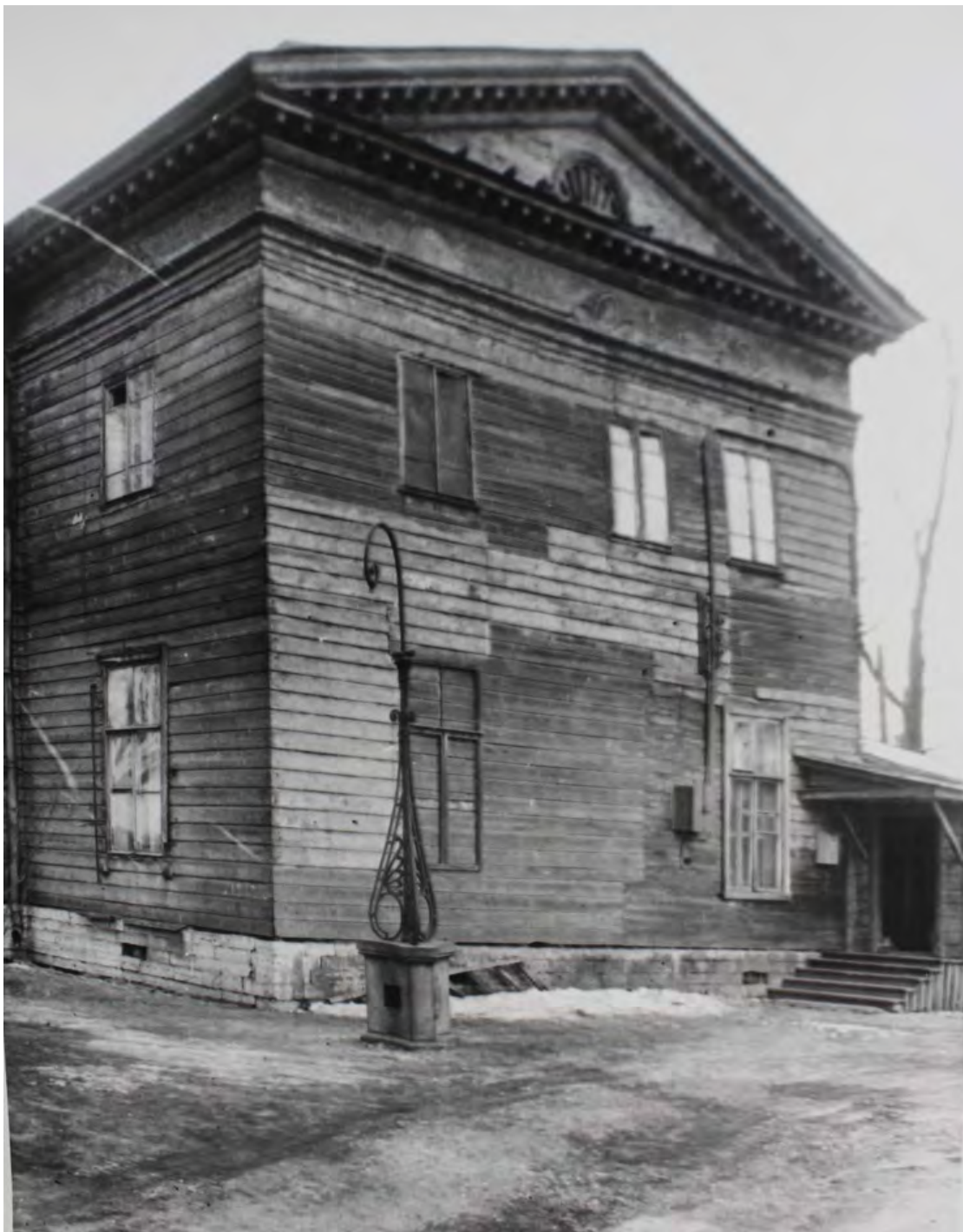
89. Дача Головина. Восточный фасад. 1961 г. // ЦГА НТД СПб. Ф. 488. Оп. 3-13. Д. 15. Л. 16.
