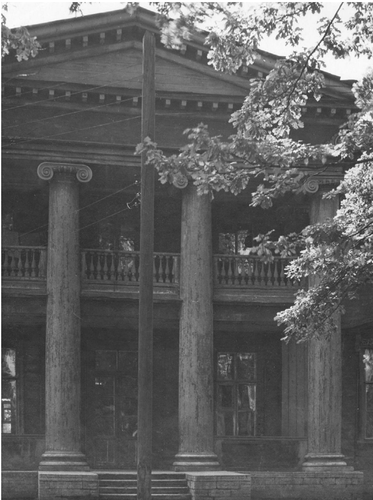
86. Дача Головина. Портик на северном фасаде. 1953 г. // Архив КГИОП.
