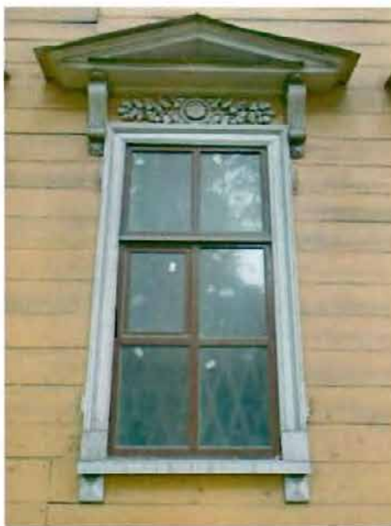
4. Оконный проем первого этажа.
