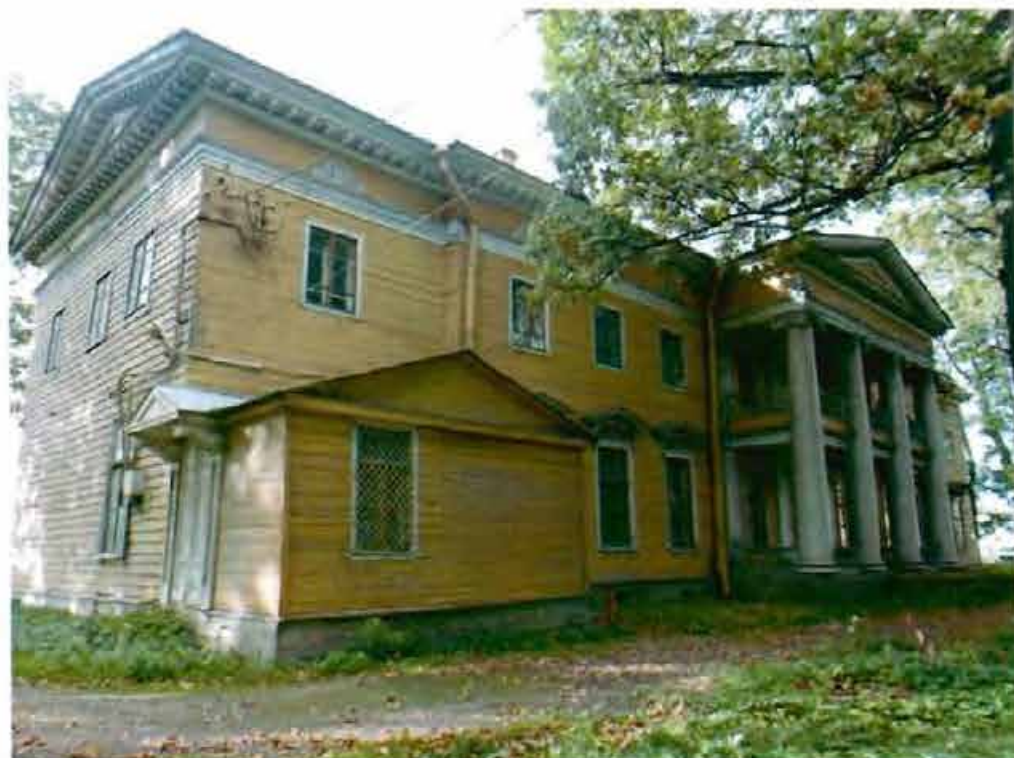
2. Общий вид с северо-востока.
