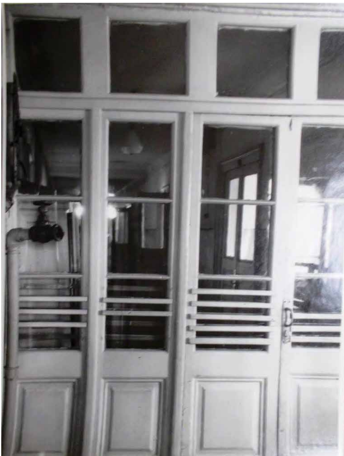
105. Дача Головина. Перегородка с дверью в помещениях 2 этажа (из коридора на лестницу). 1961 г. // ЦГА НТД СПб. Ф. 488. Оп. 3-13. Д. 15. Л. 12.
