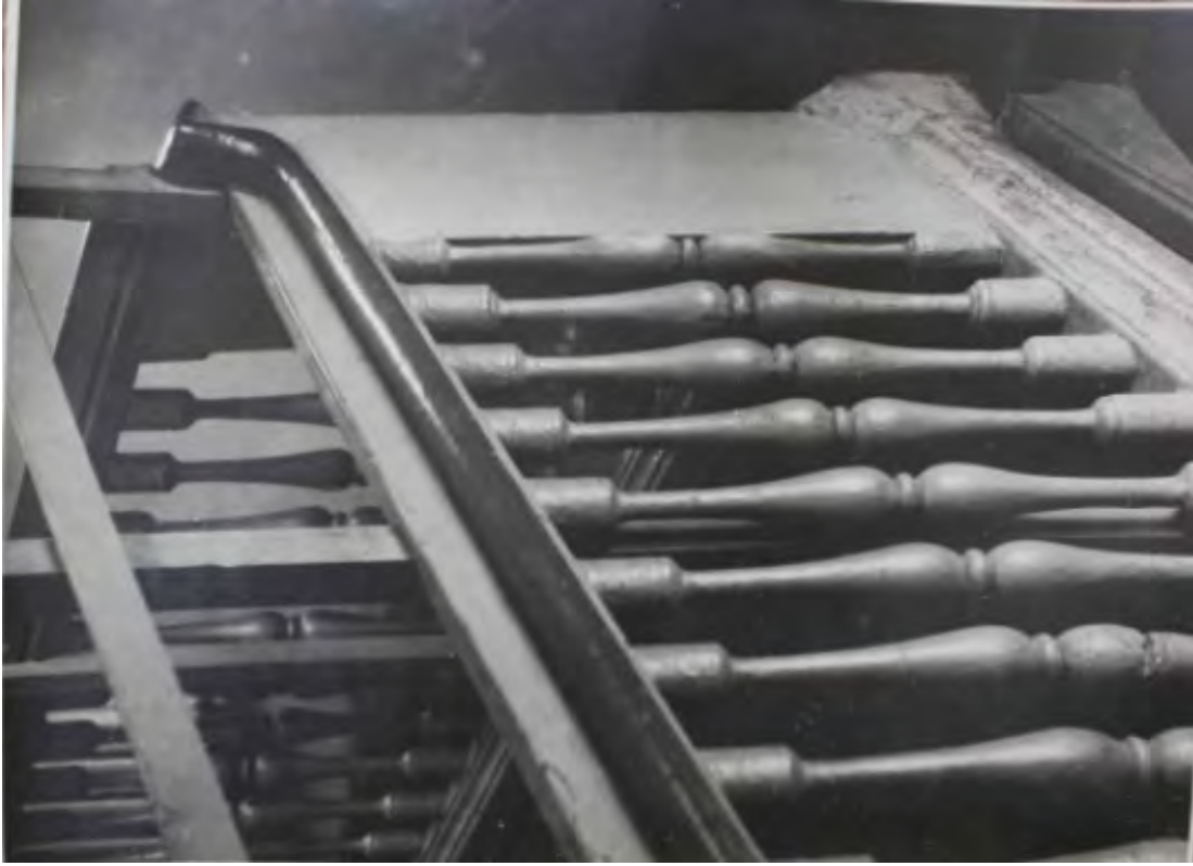
108. Дача Головина. Перила трехмаршевой лестницы в восточной части здания. 1961 г. // ЦГА НТД СПб. Ф. 488. Оп. 3-13. Д. 15. Л. 9.
