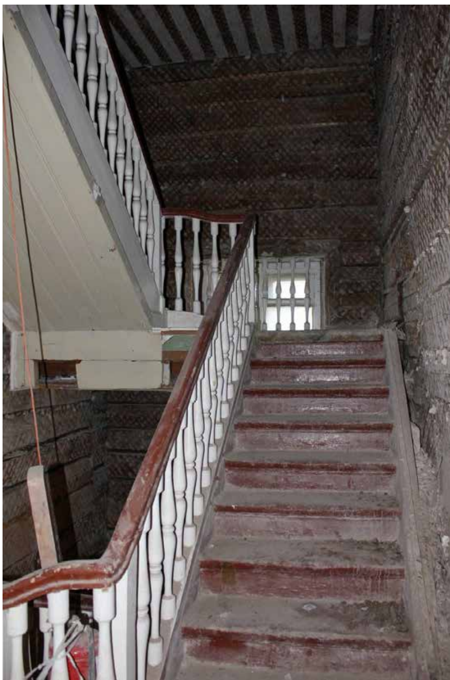
44. Объект культурного наследия федерального значения «Дача Головина» по адресу: Выборгская наб., д. 63, лит. А. 2 этаж, пом. 44. ЛК-1. Общий вид бывш. «черной» лестницы. Дата съемки: 20.01.25
