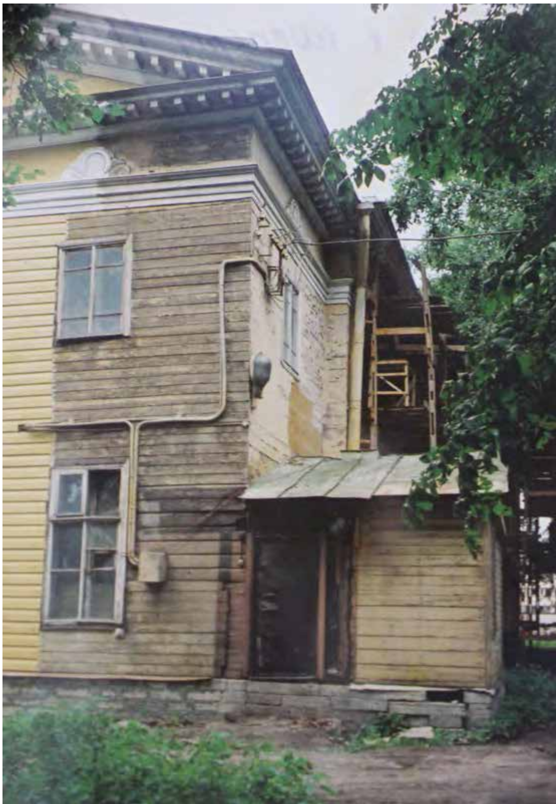
128. Вид части восточного фасада во время реставрационных работ. 2005 г. // Архив КГИОП.
