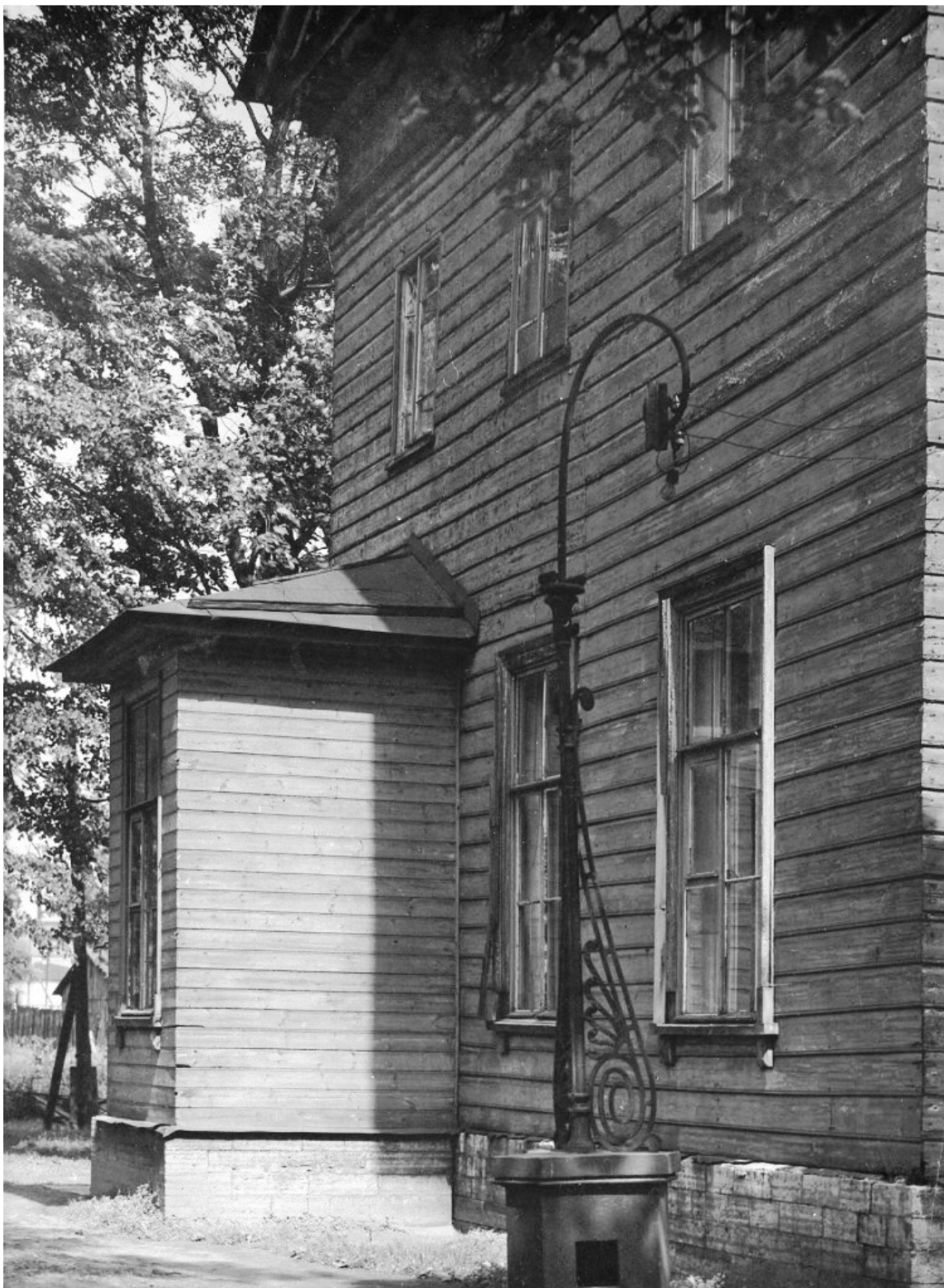
87. Дача Головина. Западный фасад. 1953 г. // Архив КГИОП.
