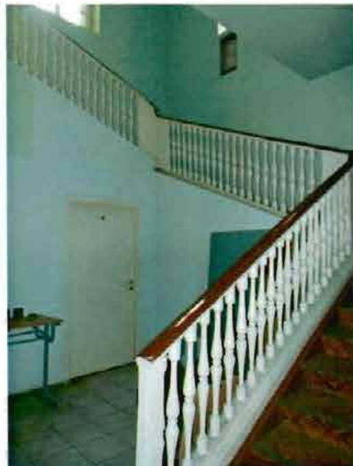
12. Ограждение лестничных маршей.
