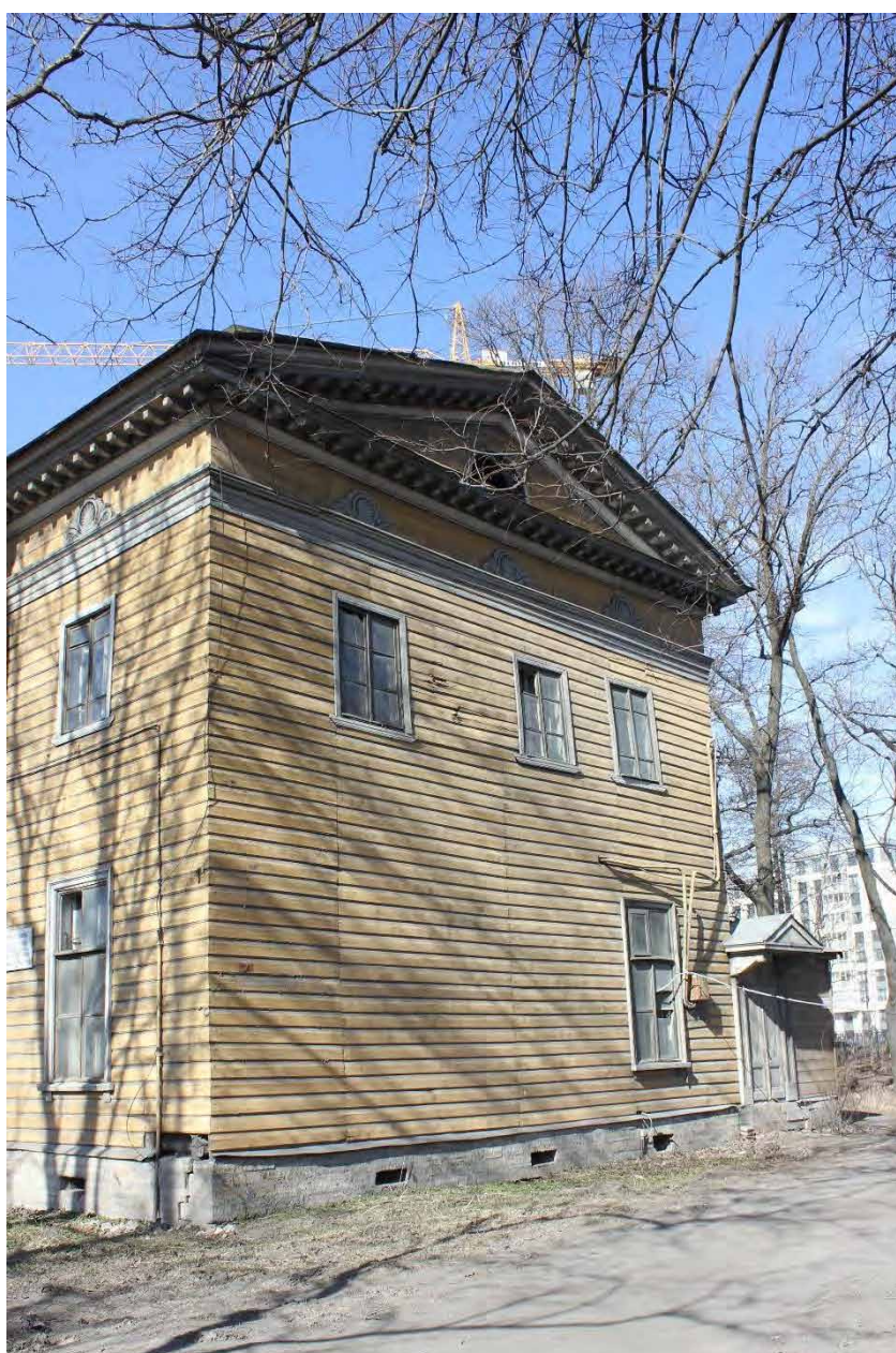
7. Объект культурного наследия федерального значения «Дача Головина» по адресу: Выборгская наб., д. 63, лит. А. Боковой (восточный) фасад. Дата съемки: 07.04.2025
