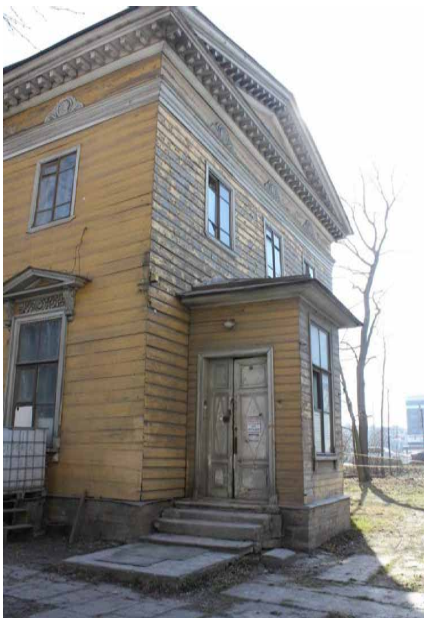
16. Объект культурного наследия федерального значения «Дача Головина» по адресу: Выборгская наб., д. 63, лит. А. Боковой (западный) фасад. Вид с территории объекта культурного наследия в юго-восточном направлении. Дата съемки: 07.04.2025
