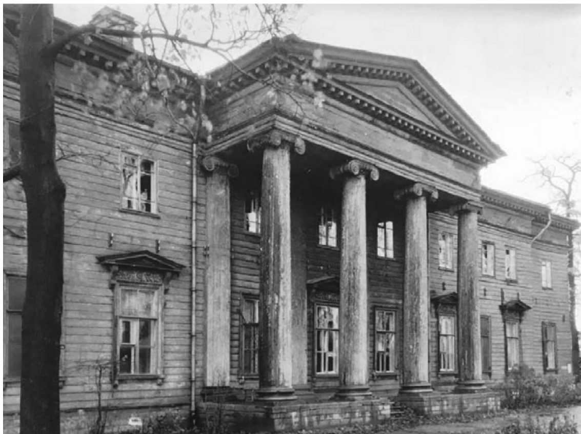
79. Дача Головина. 1952 г. Главный (южный) фасад. // Архив КГИОП.
