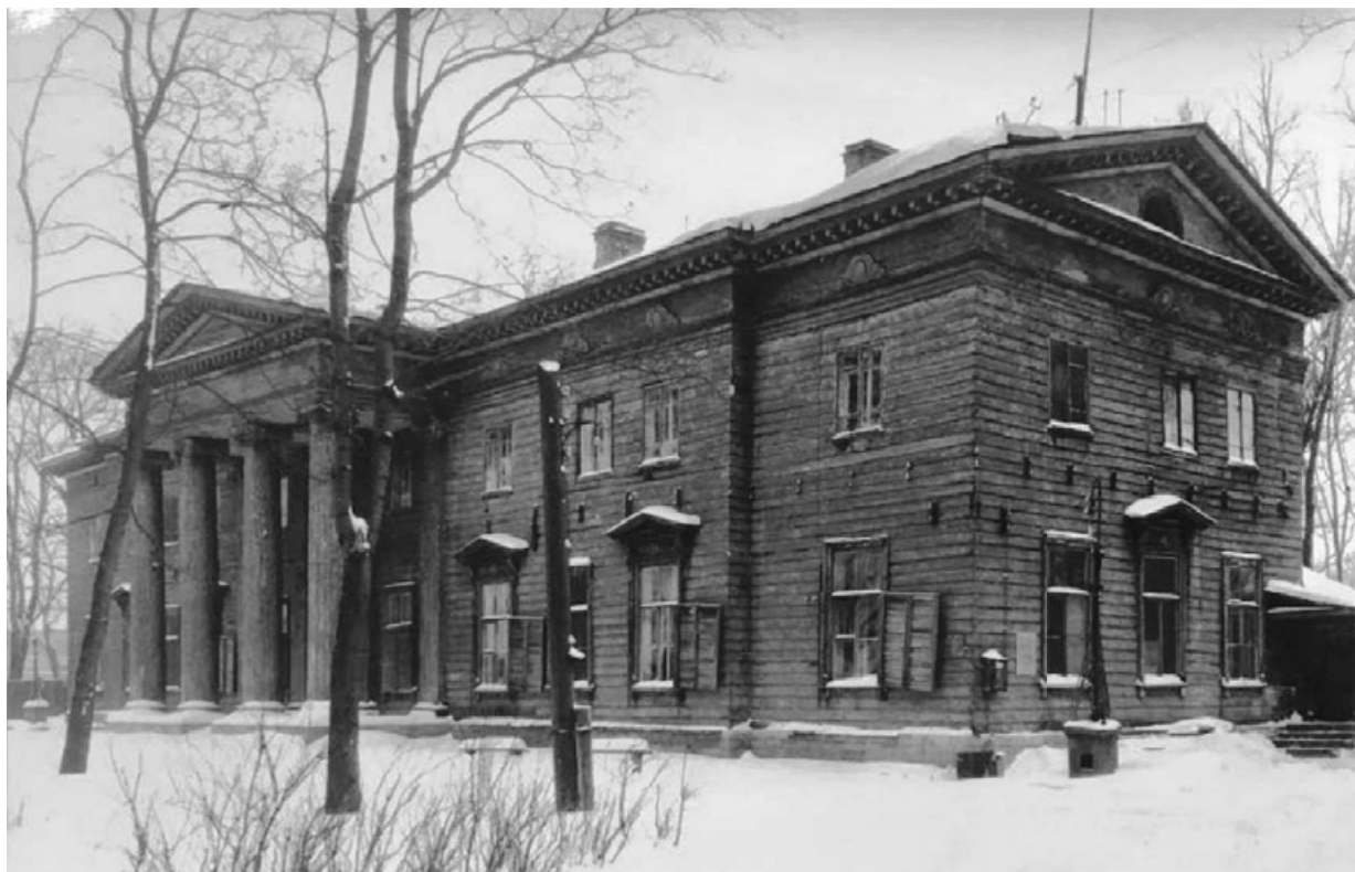
77. Дача Головина. Вид на южный и восточный фасады. 1948 г. // Архив КГИОП.
