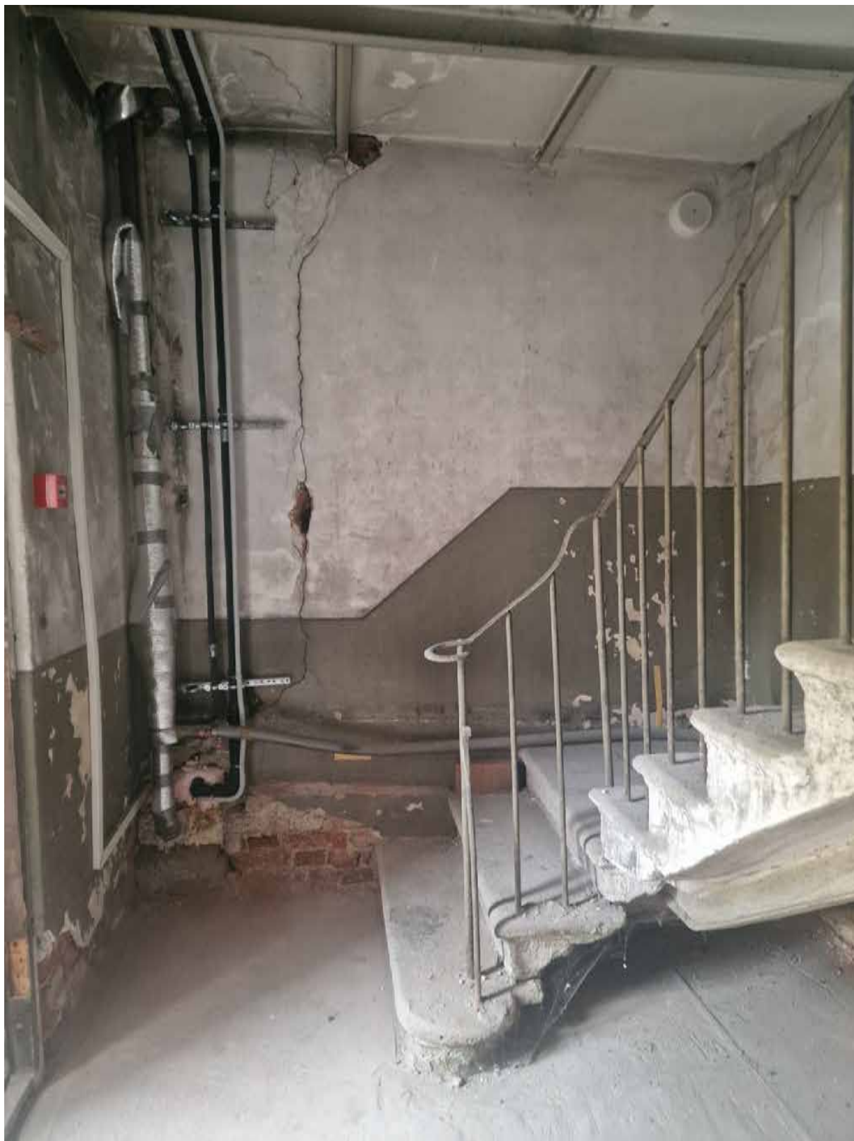
Фото 2. Помещение 48. Вид на первый марш лестницы. Разрушение кирпичной кладки, силовая трещина в штукатурной поверхности.
