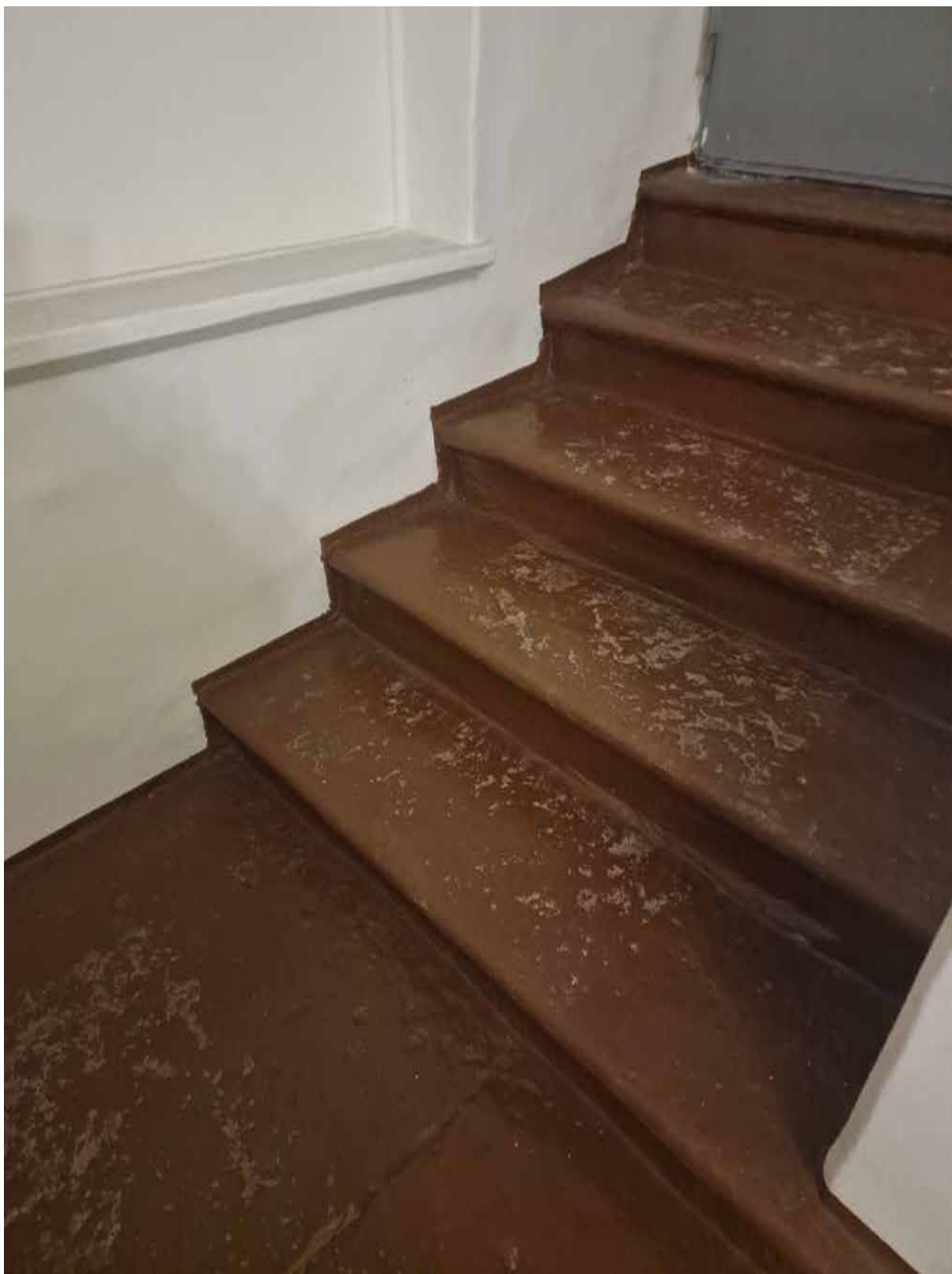
Фото 45. Помещение 393. Межэтажная площадка и лестничный марш со ступенями с валиком. Металлическое дверное заполнение
