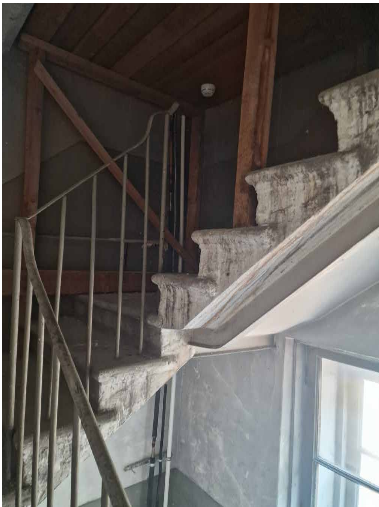
Фото 7. Помещение 48. Вид на шестой марш лестницы. Сколы, каверны, загрязнения ступеней из известняка. Подшивка потолка.
