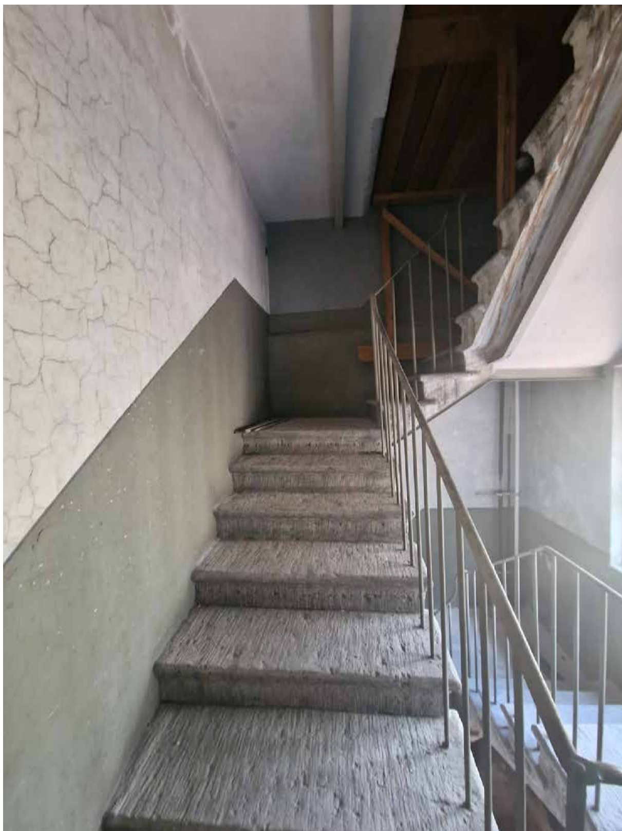
Фото 6. Помещение 48. Вид на пятый марш лестницы. Сколы, каверны, загрязнения ступеней из известняка. Сетка трещин в штукатурной поверхности
