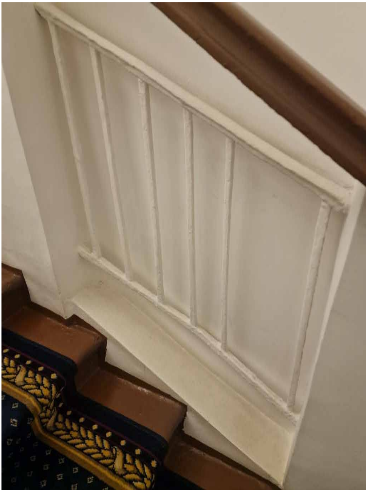
Фото 41. Помещение 393. Металлическое ограждение с деревянным поручнем
