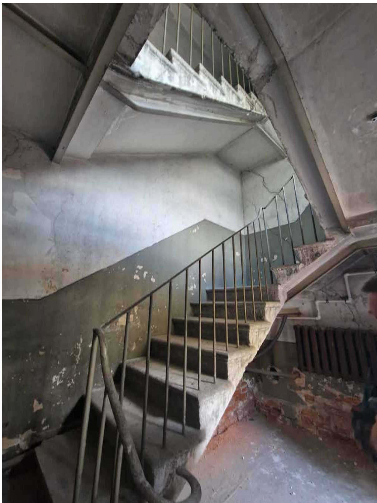
Фото 4. Помещение 48. Вид на второй марш лестницы. Сколы, каверны, загрязнения ступеней из известняка. Разрушение кирпичной кладки, силовая трещина в штукатурной поверхности.
