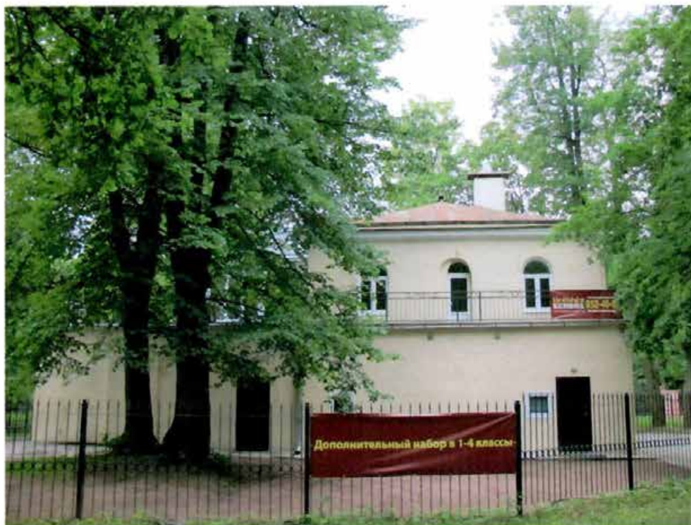
4. «Кухонный корпус». Северо-восточный фасад.
