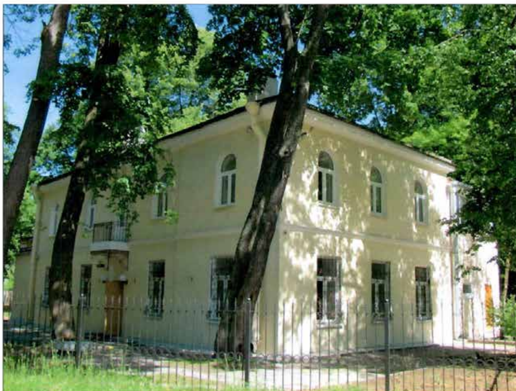
1. «Кухонный корпус». Общий вид с запада.
