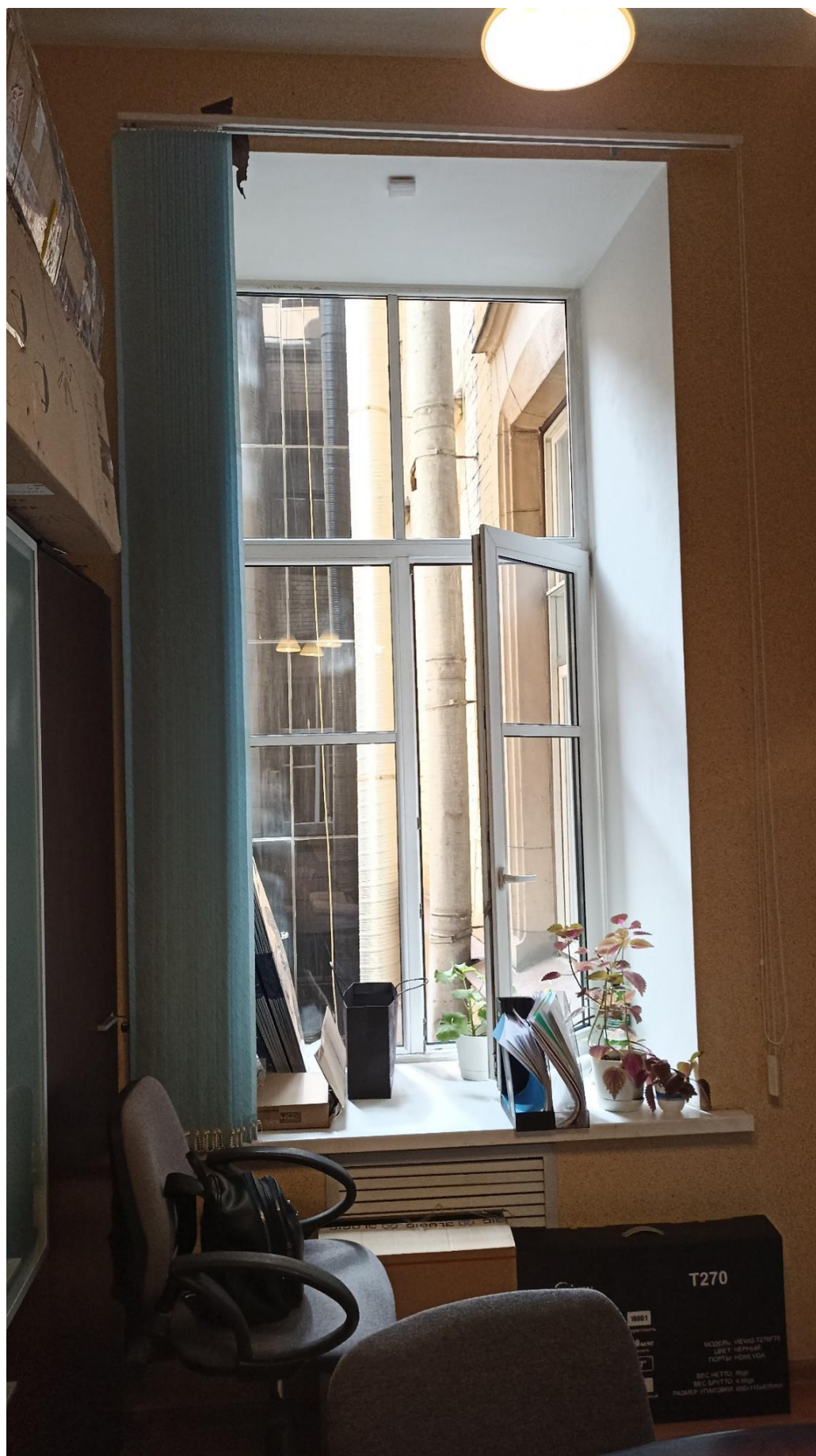
5. Пом. 32, вид изнутри на оконный проем, в раме которого предполагается установка блока кондиционера.
