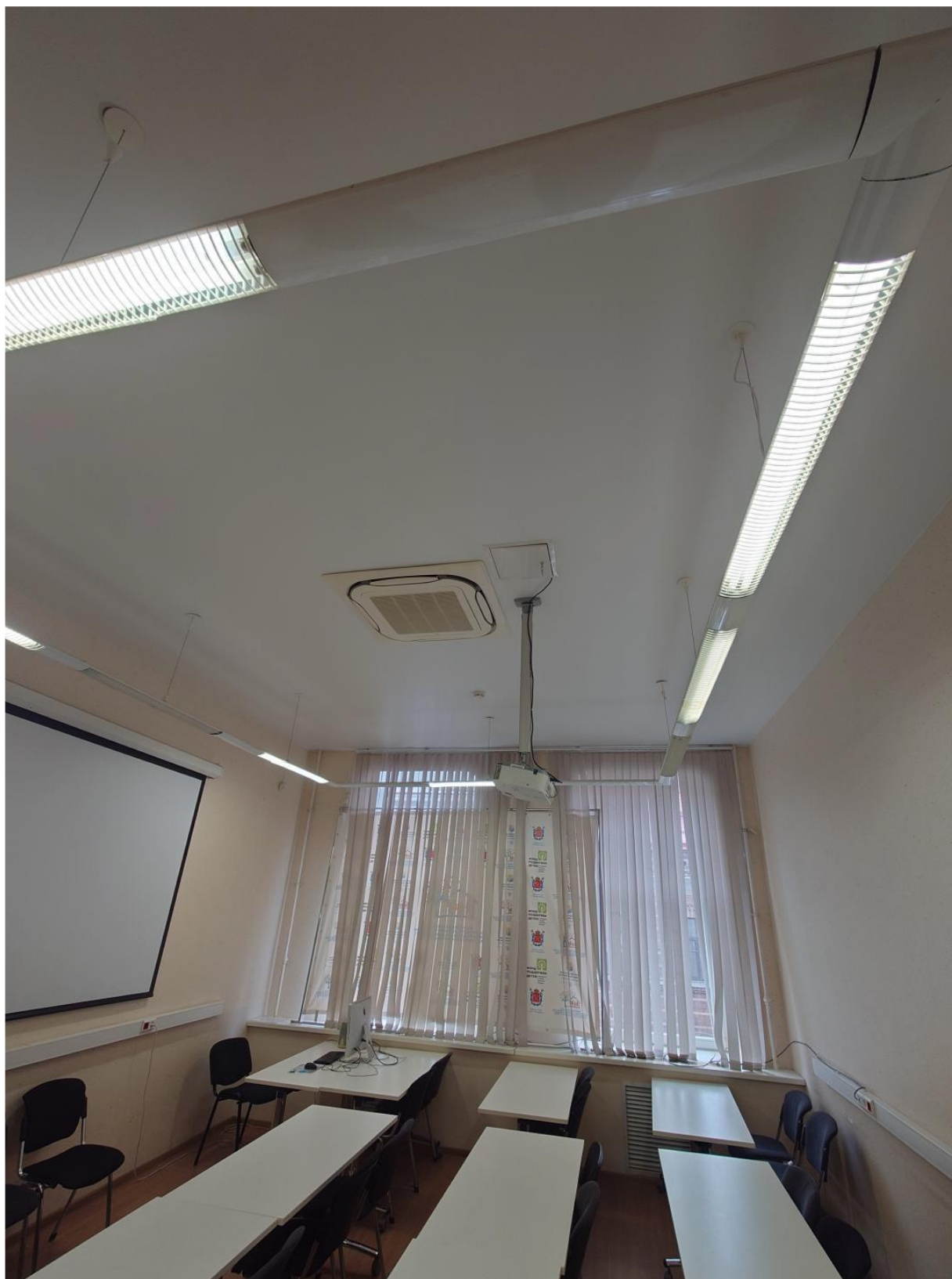
7. Пом. 9, вид на место предполагаемой установки кондиционера.
