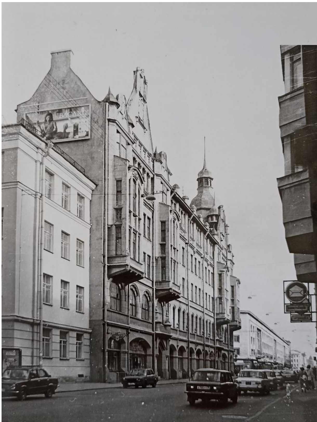
22. Лицевой фасад по Вознесенскому пр. Вид с северо-запада. Фото 1997 г. Архив КГИОП. Паспорт ОКН «Дом городских учреждений».
