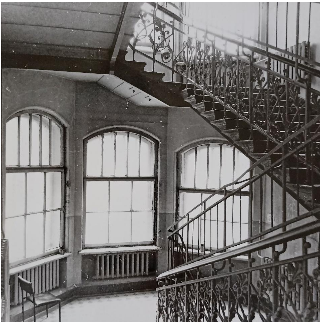
28. Интерьер парадного вестибюля в лицевом корпусе по Вознесенскому пр. Фото 1997 г. Архив КГИОП. Паспорт ОКН «Дом городских учреждений».
