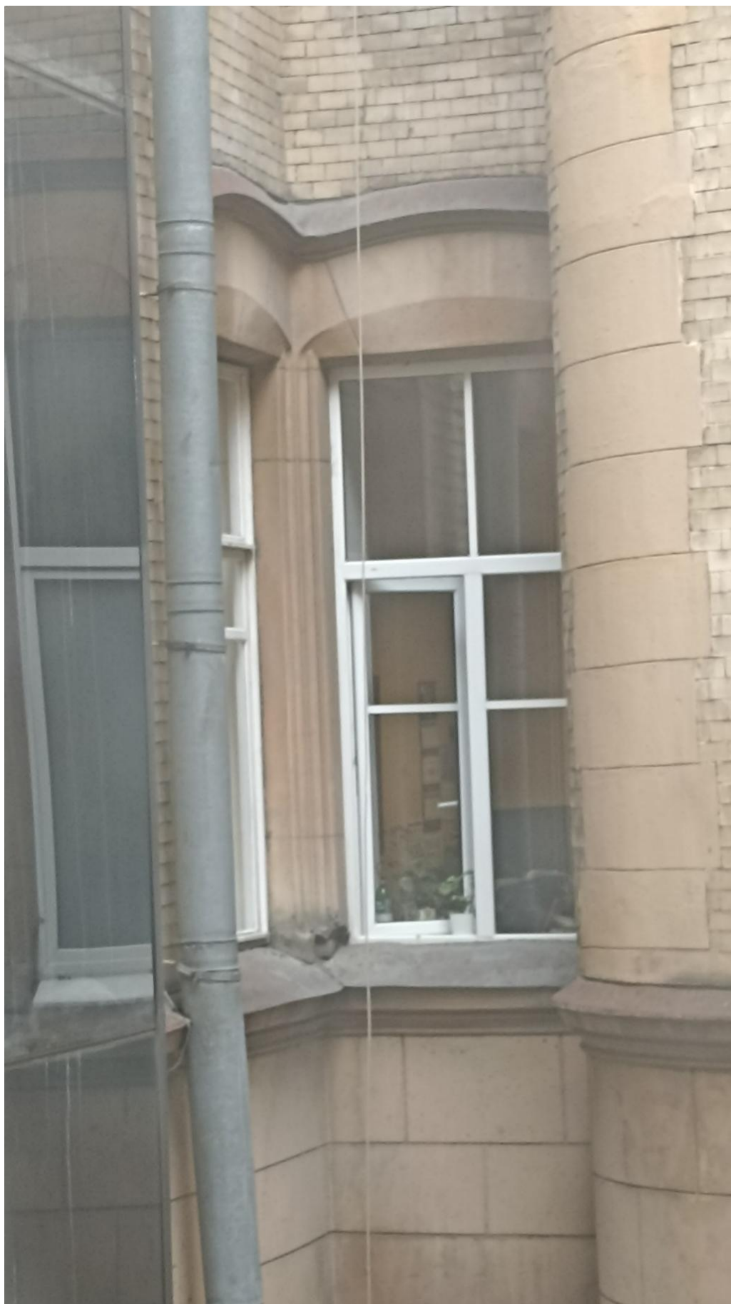
4. Окно, в раме которого предполагается установка блока кондиционера в уровне 3-го этажа фасада малого внутреннего двора.
