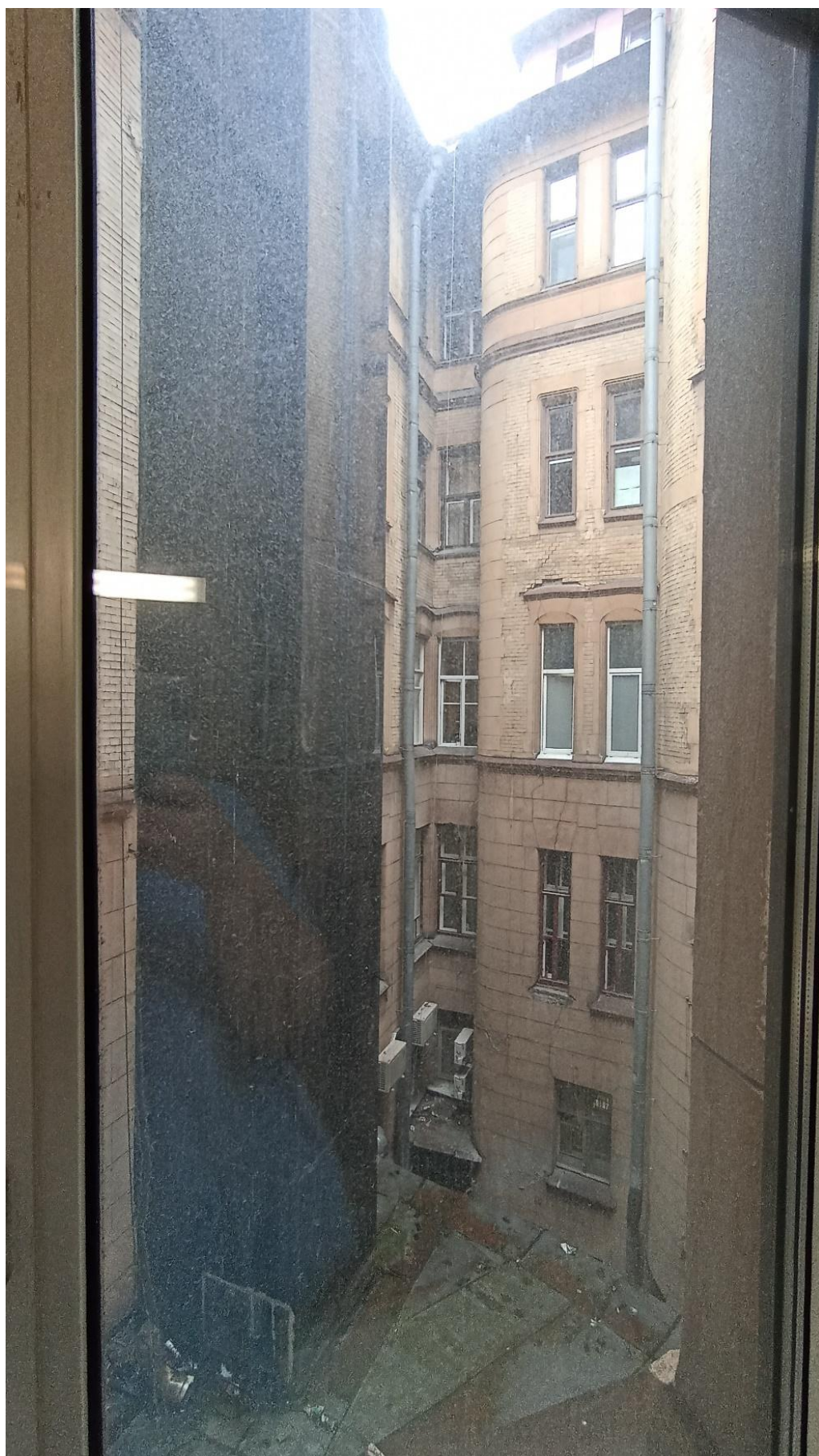
3. Фрагмент фасада малого внутреннего двора с окном, в раме которого предполагается установка блока кондиционера в уровне 3-го этажа.
