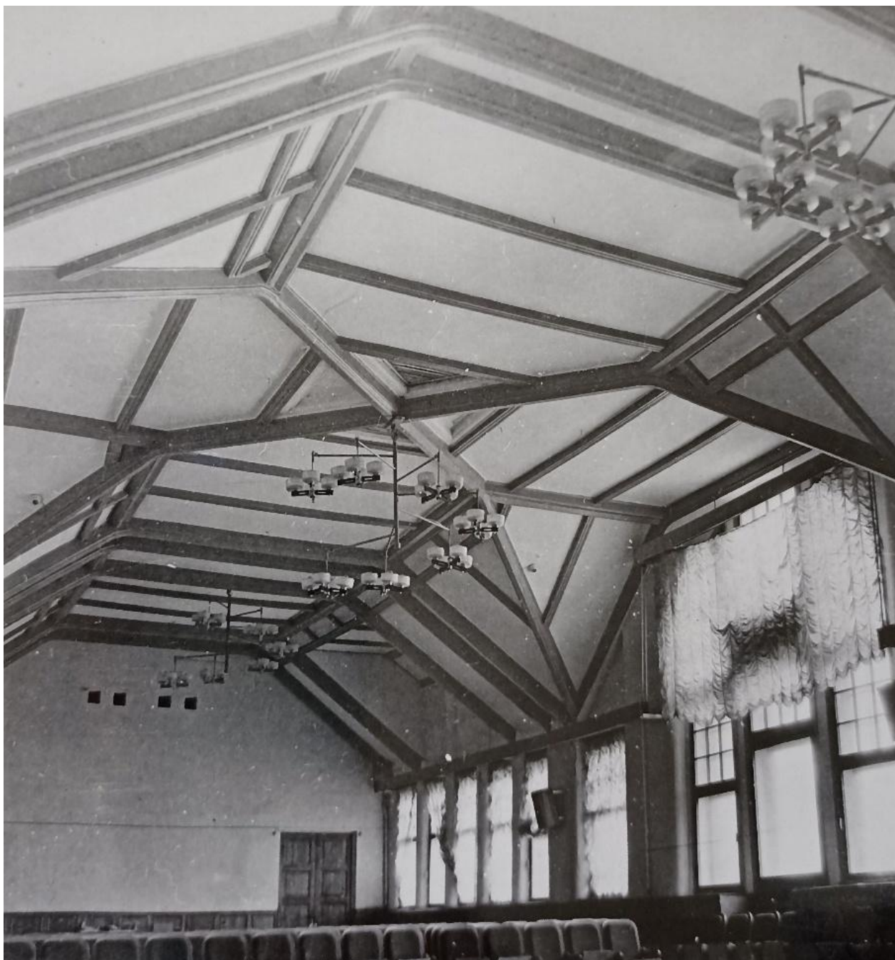
29. Интерьер рекреационного зала в лицевом корпусе по Садовой ул. Вид со стороны входа. Фото 1997 г. Архив КГИОП. Паспорт ОКН «Дом городских учреждений».
