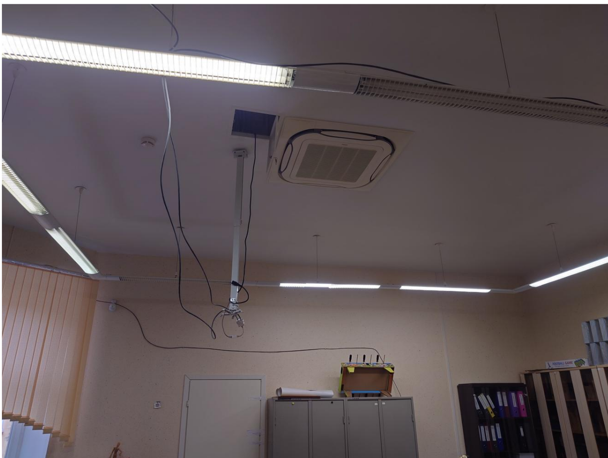
10. Пом. 21, вид на место предполагаемой установки кондиционера.
