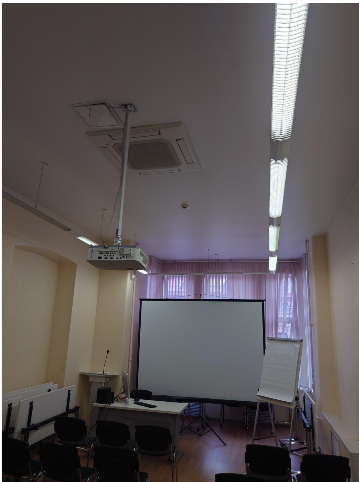
8. Пом. 11, вид на место предполагаемой установки кондиционера.
