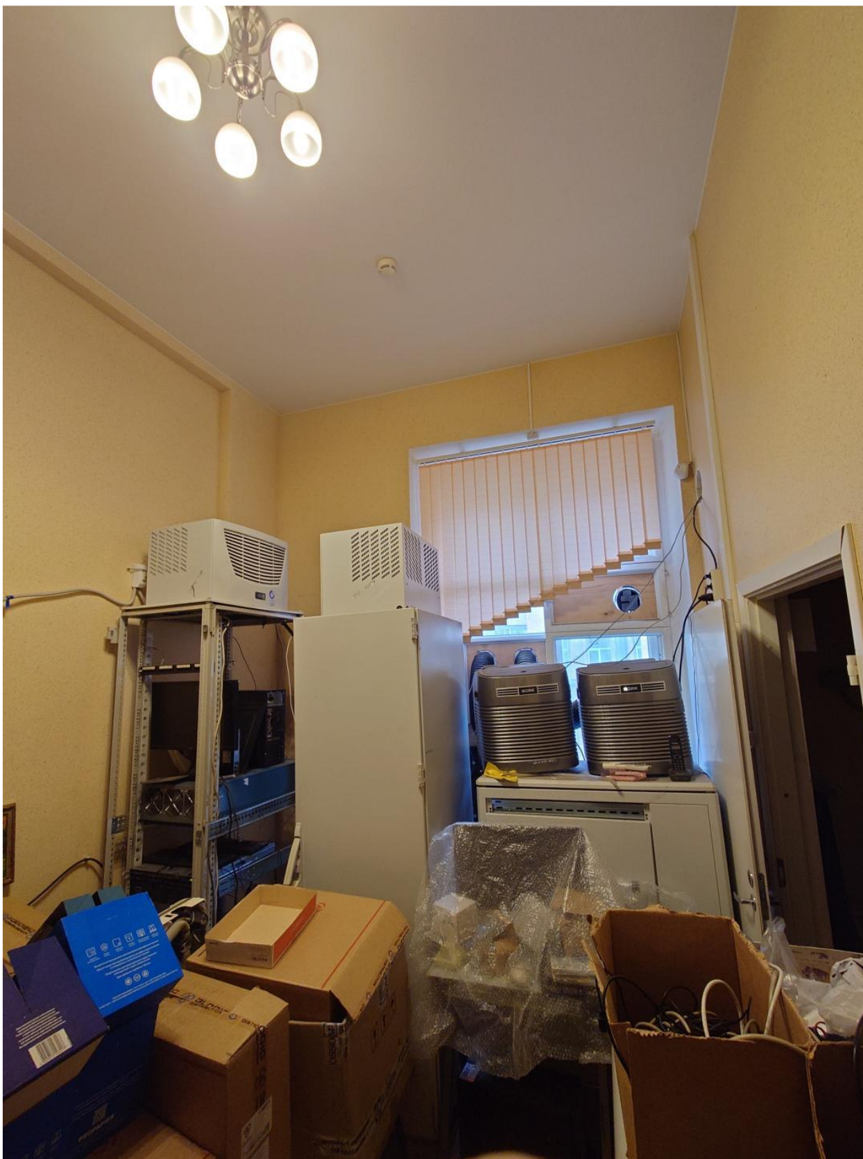
9. Пом. 20, вид на место предполагаемой установки кондиционера.
