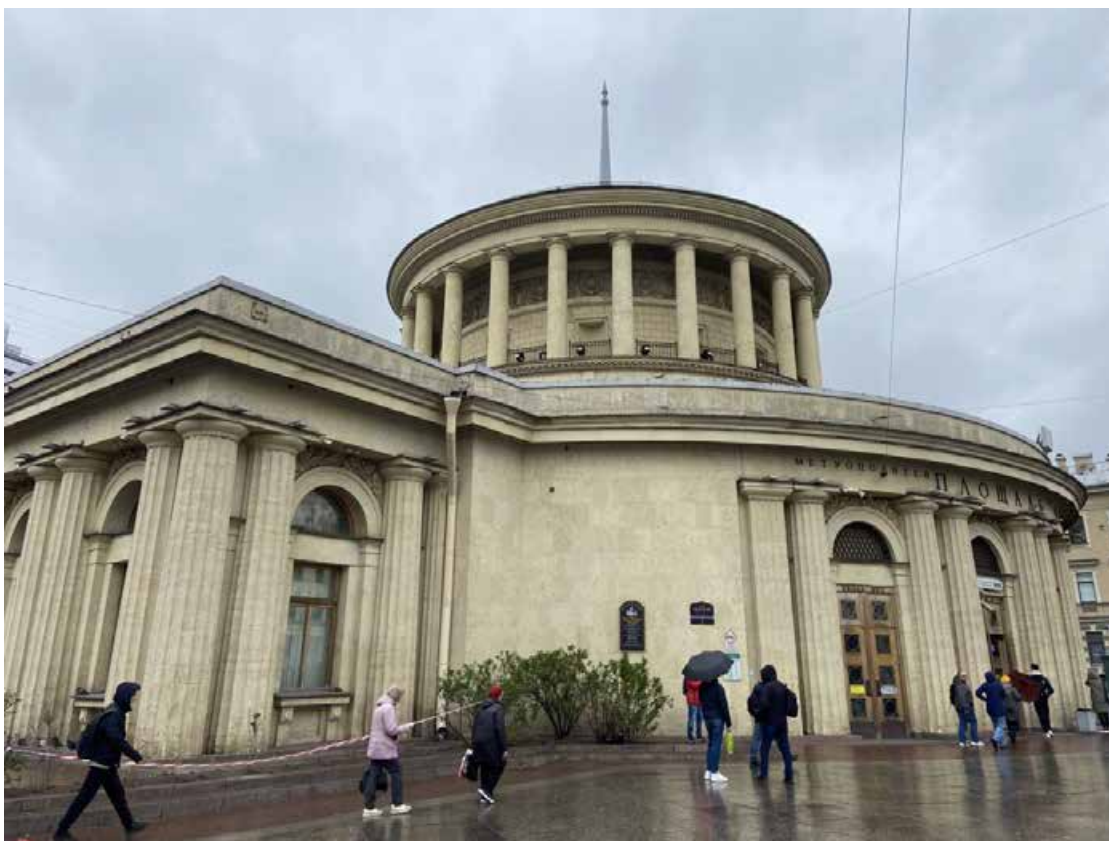
Фото 5. Лицевой фасад объекта культурного наследия регионального значения «Станция метро «Площадь Восстания» (с перронным залом)»
