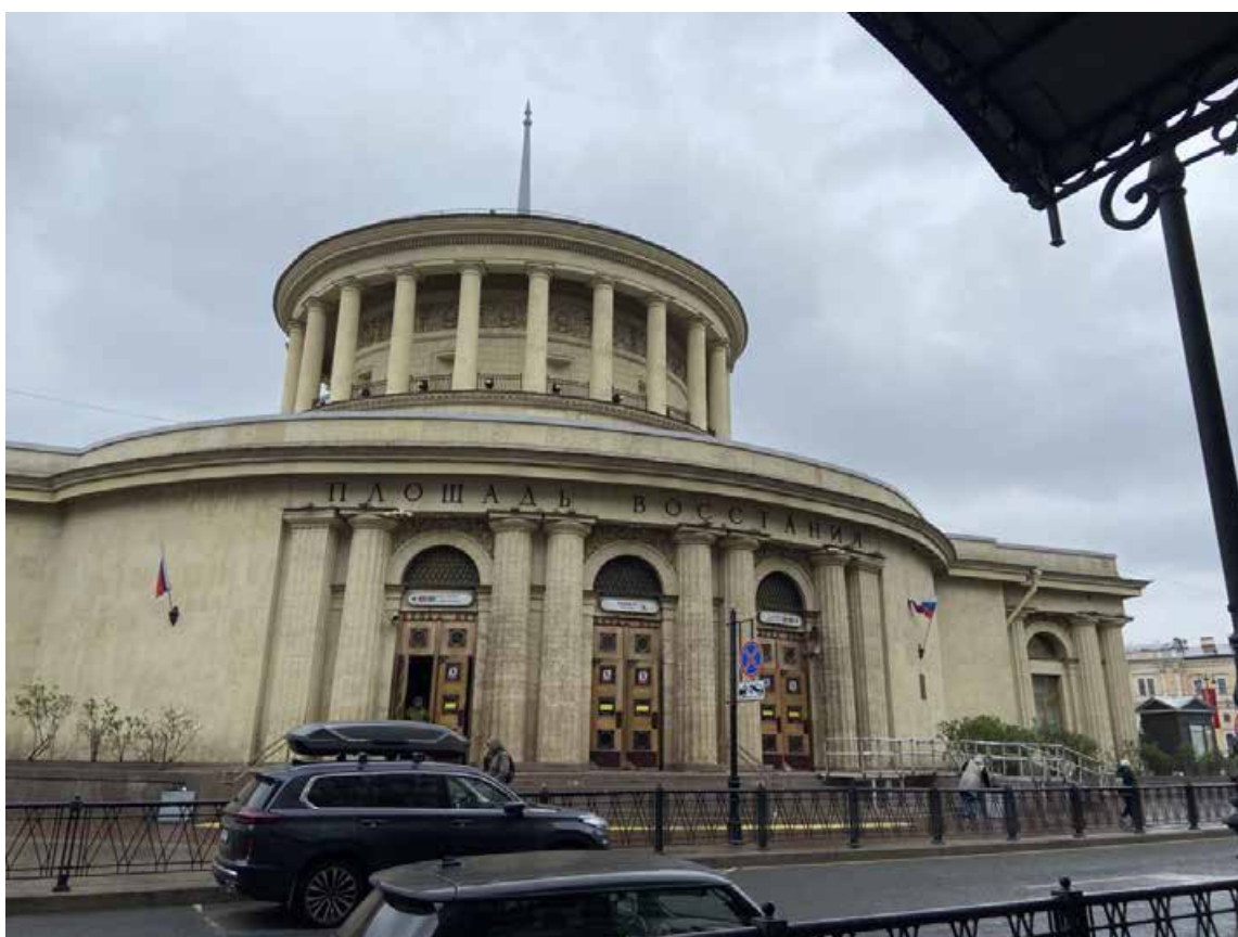
Фото 2. Лицевой фасад объекта культурного наследия регионального значения «Станция метро «Площадь Восстания» (с перронным залом)»
