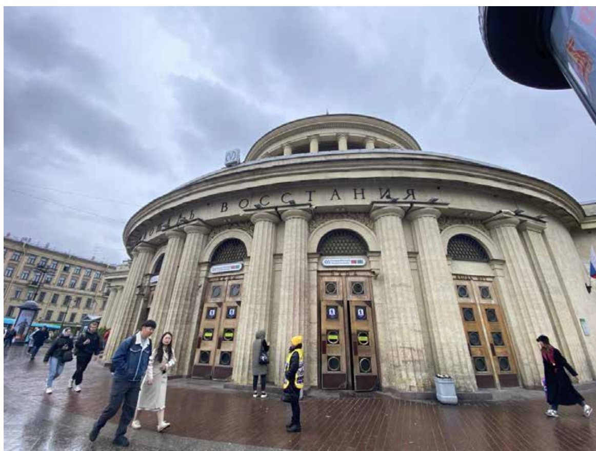
Фото 6. Лицевой фасад объекта культурного наследия регионального значения «Станция метро «Площадь Восстания» (с перронным залом)»
