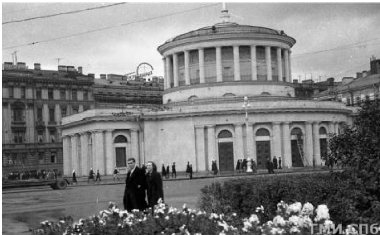
18. Станция метро «Площадь Восстания». 1959 г. СПб ГБУ «Государственный музей истории Санкт-Петербурга». ГМИ СПб Инв.№-II-Б- 12412 н.
