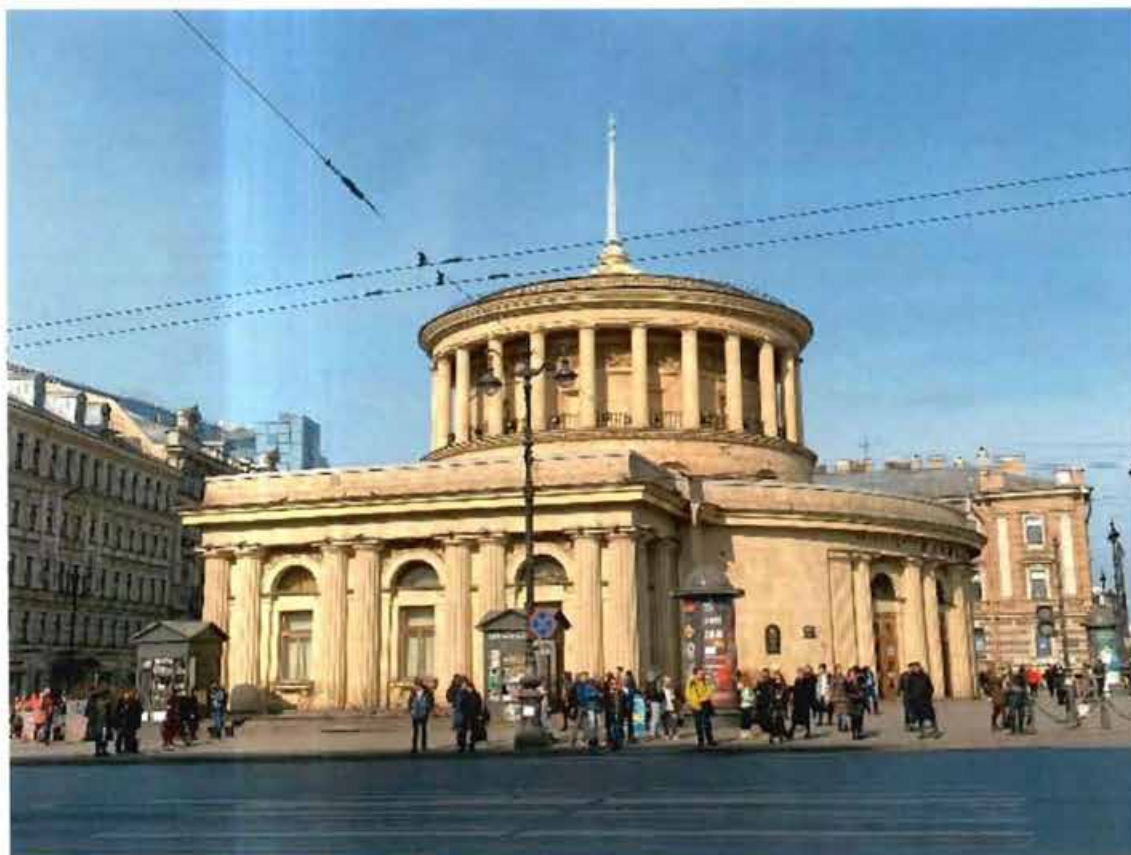
1. Общий вид на объект культурного наследия.
