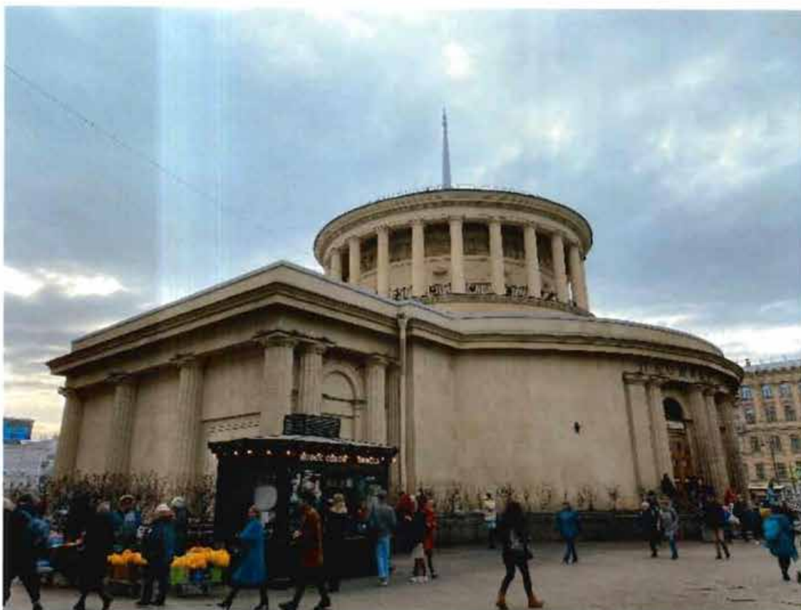
2. Общий вид на объект культурного наследия.
