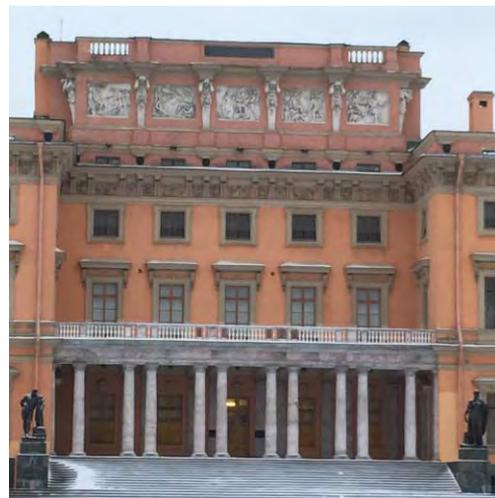
в лоджии линейный руст, мраморные пилястры дорического ордера, над оконными и дверными проемами лепные маски;
