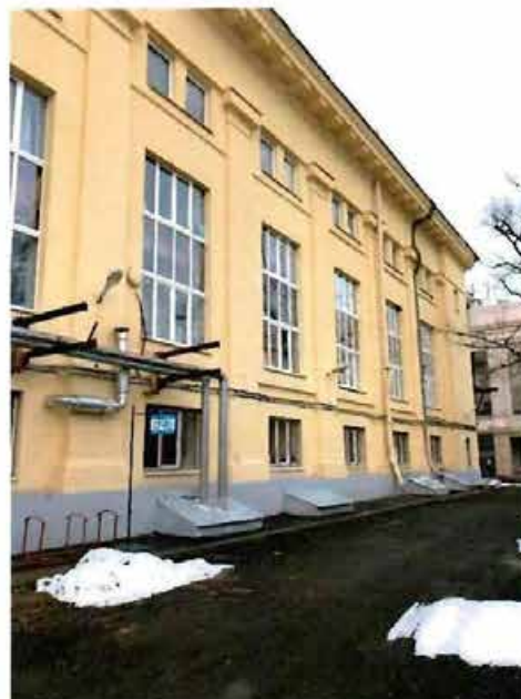
7. Фрагмент южного фасада объекта объекта культурного наследия.
