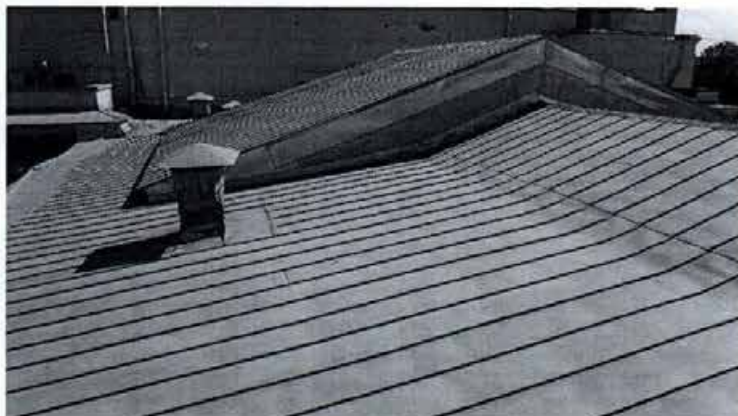
Фото 8. Крыша объекта культурного наследия
