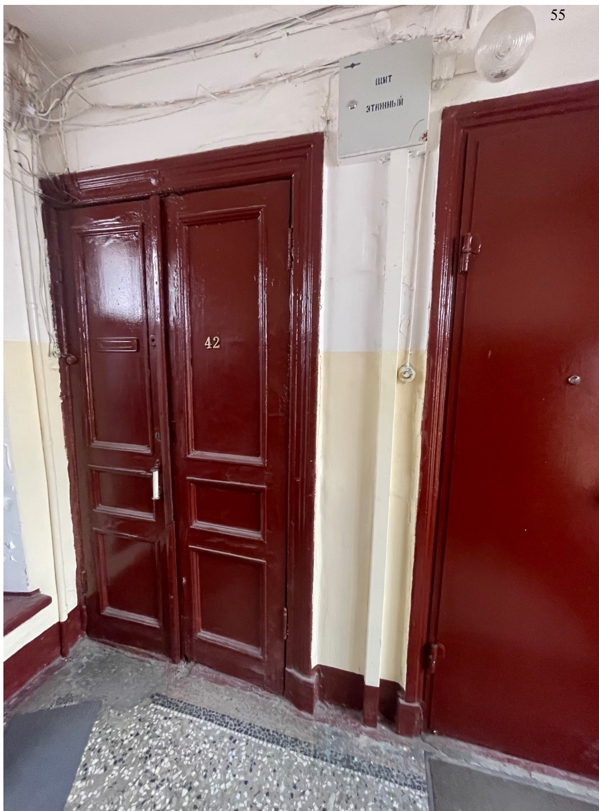
2. Входная дверь в квартиру №42.
