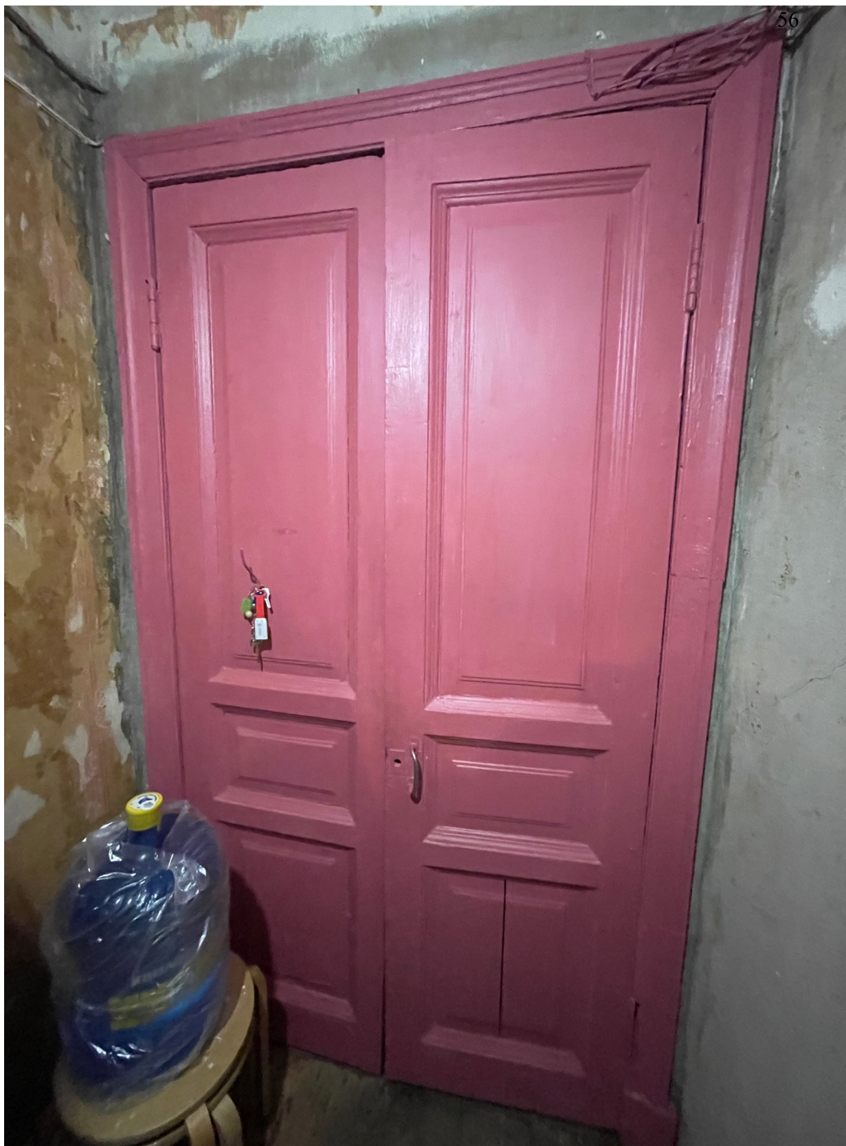
3. Входная дверь в квартиру №42 изнутри.
