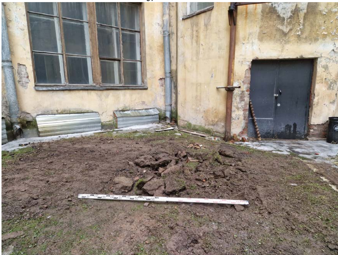
Рис. 23. СПб-2025. Адмиралтейский район, Большая Морская, д. 40. Шурф 1. Общий вид. Рекультивация. Вид с запада.
