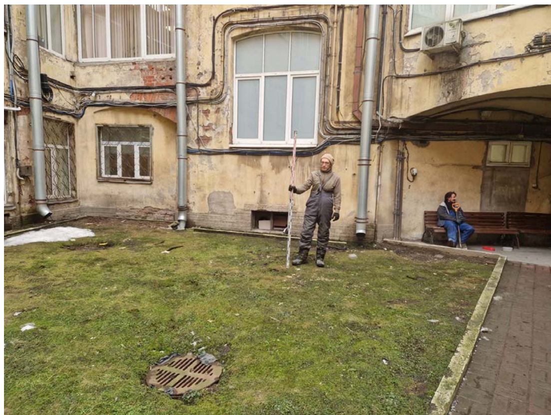
Рис. 24. СПб-2025. Адмиралтейский район, Большая Морская, д. 40. Общий вид участка обследования. Шурф 2. До начала работ. Вид с востока.
