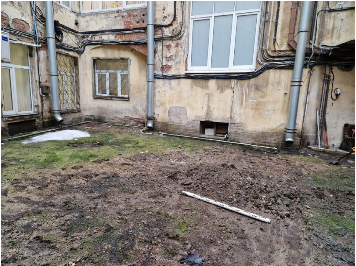
Рис. 32. СПб-2025. Адмиралтейский район, Большая Морская, д. 40. Шурф 1. Рекультивация. Вид с юга.
