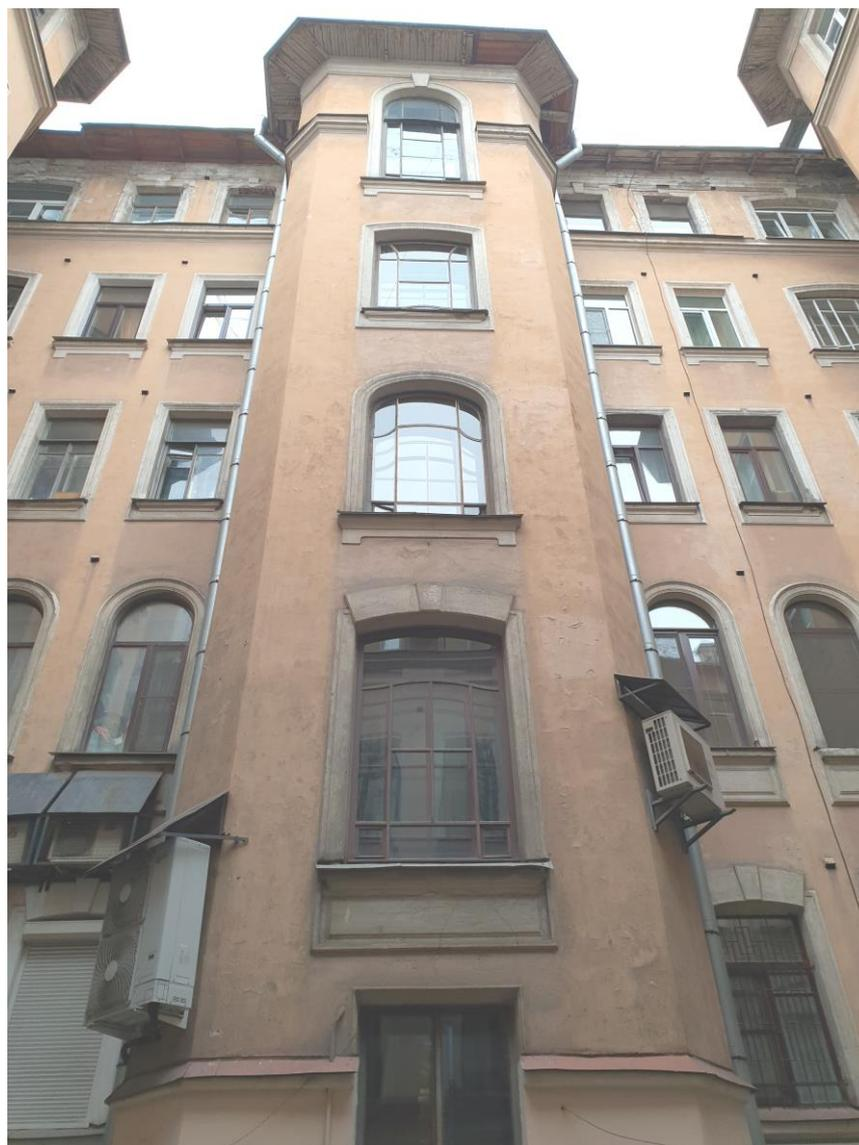
**Фото 29.** Фрагмент дворового северного фасада с пятигранным одноосевым ризалитом лестничной клетки лицевого 5-и этажного лицевого копуса по 2-й Советской ул. Венчающий выносной карниз с деревянной подшивкой на кобылках. Оконные проемы прямоугольной конфигурации, с лучковой перемычкой, полуциркульного очертания.
