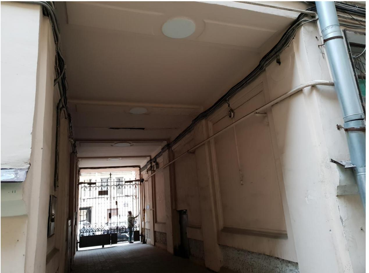
**Фото 21.** Арка дворового проезда лицевого 5-и этажного корпуса по 3-й Советской ул с плоским перекрытием, оформленным штукатурным геометрическим декором в виде плоских филенок и кругов, заключенных в них; стены разбиты на зеркала в профилированных рамах между пилястрами, нижняя часть стены под зеркалами выполнена в штукатурке «под шубу»
