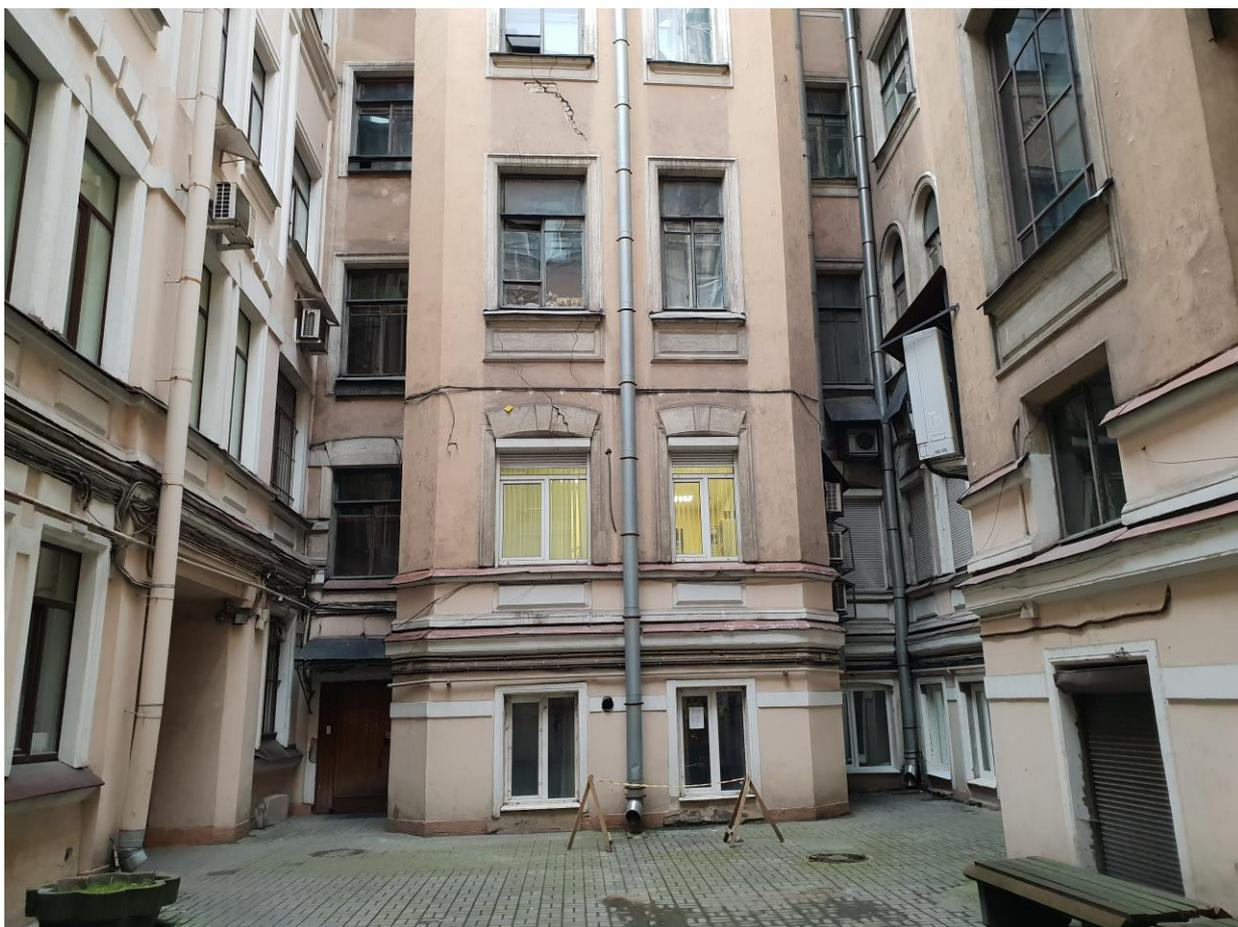
**Фото 28.** Вид на дворовые фасады северного двора сложной конфигурации: слева фрагмент южного дворового фасада поперечного 4-х этажного дворового корпуса с воротным проездом; в центре фрагмент западного дворового фасада с выступающим пятигранным ризалитом на две оси (наблюдаются поперечные конструктивные трещины на всю высоту ризалита), справа фрагмент северного дворового фасада лицевого 5-и этажного лицевого корпуса по 2-й Советской ул.
