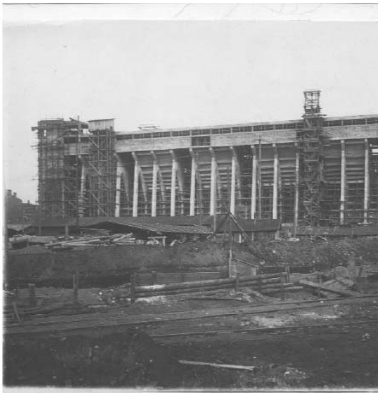
114. Строительство новой котельной. Дата съемки: 08.10.1931 г. // Исто
