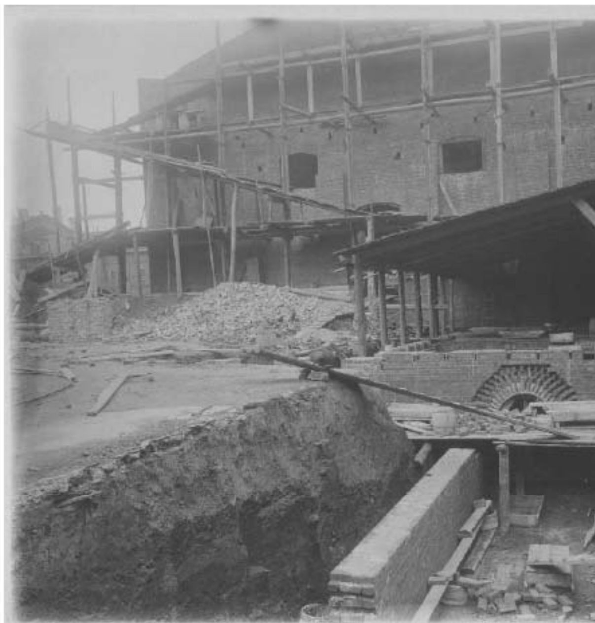
124. Строительство новой котельной. Дата съемки: 1930-е гг. // Исто
