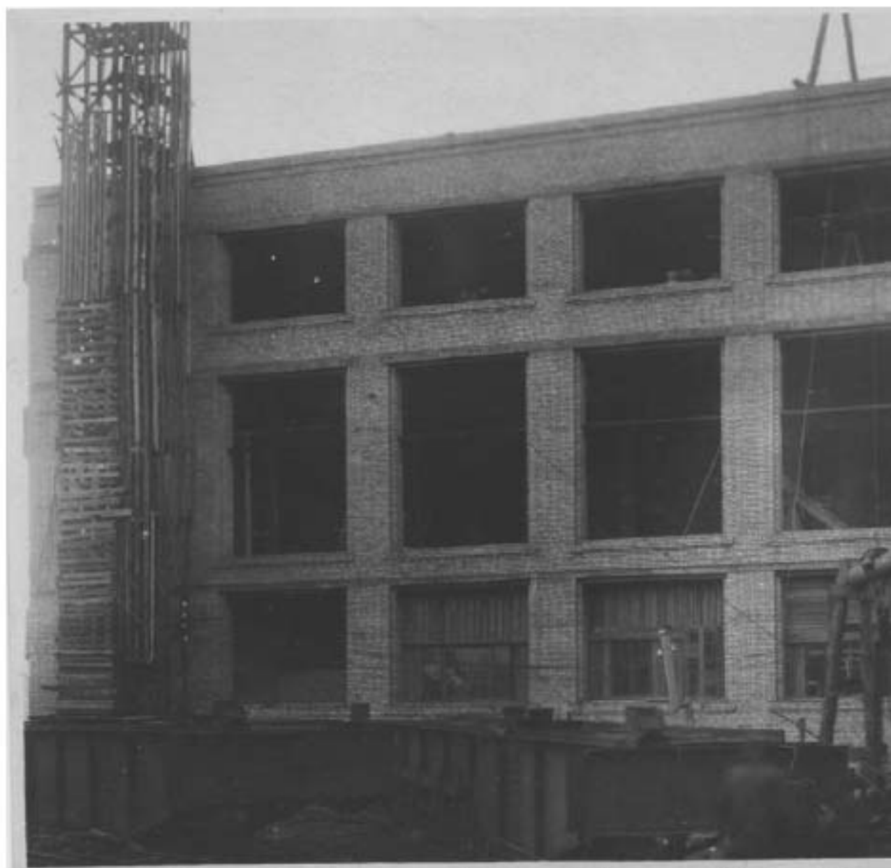
127. Строительство новой котельной. Дата съемки: 1930-е гг. // Источ
