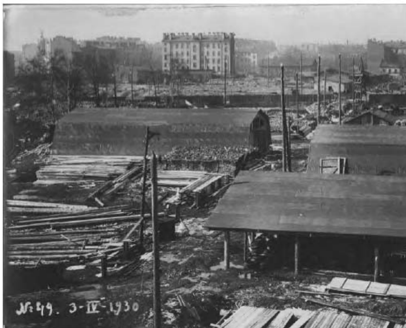
85. Территория электростанции. Дата съемки: 03.04.1930 г. // Источник: Архив
