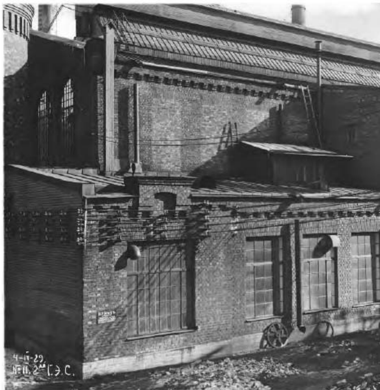
69. Территория электростанции. Дата съемки: 04.04.1929 г. // Источ
