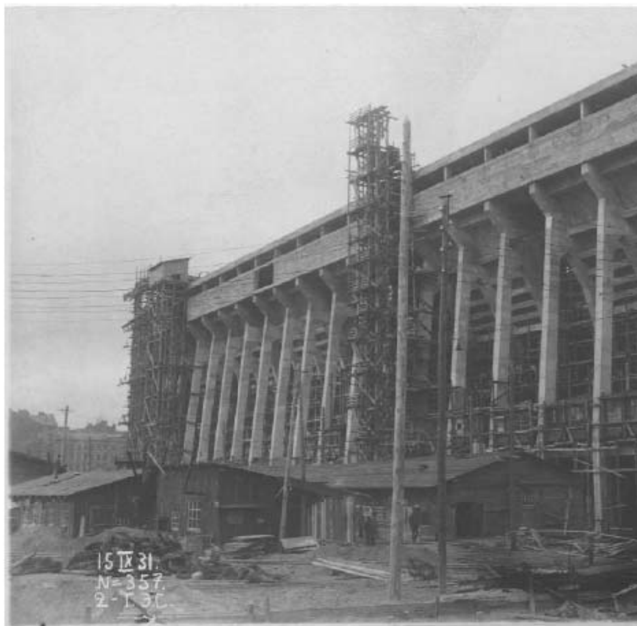
113. Строительство новой котельной. Дата съемки: 15.09.1931 г. // Исто
