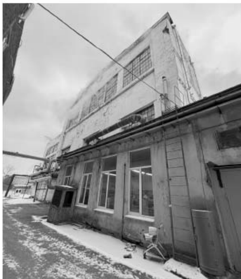
Фото 13. Северный фасад объекта культурного наследия «Административное здание и машинный зал».
