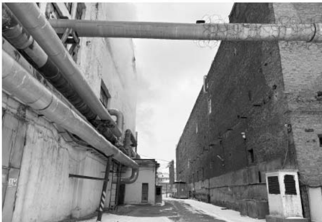
Фото 12. Северный фасад объекта культурного наследия «Административное здание и машинный зал».
