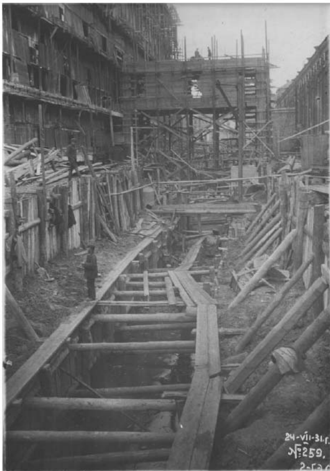
107. Строительство новой котельной. Дата съемки: 24.07.1931 г. // Источник: Архив ТЭЦ-2.
