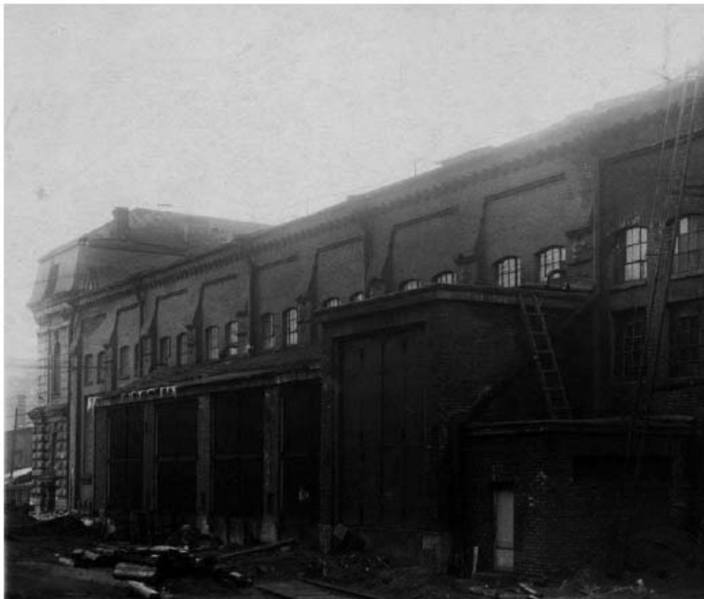
100. Начало строительства новой котельной. Вид на здание машинного отделения. Источник: Архив ТЭЦ-2.
