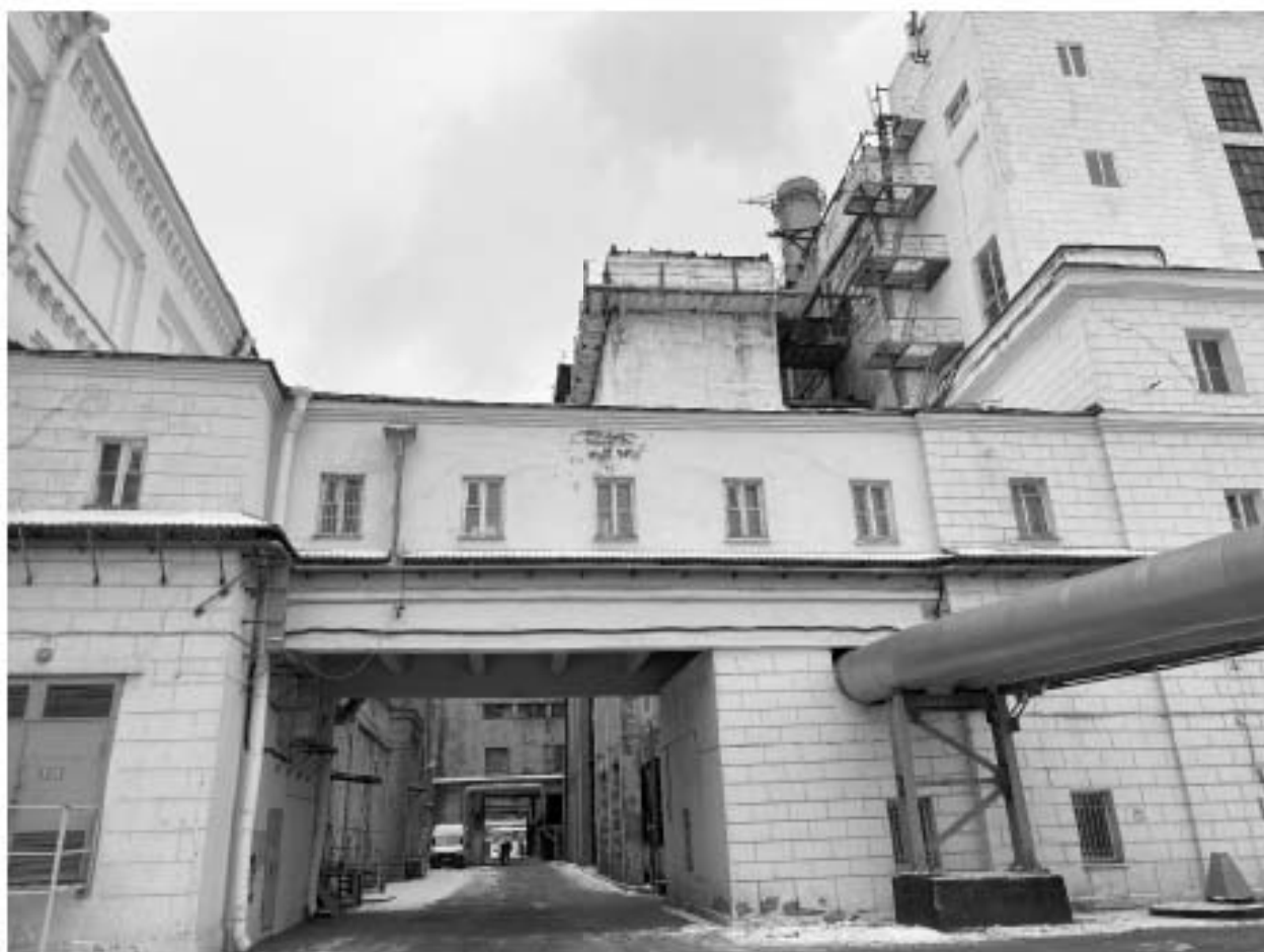
Фото 9. Переход между объектами культурного наследия «Котельная ТЭЦ» (справа) и «Административное здание и машинный зал» (слева).
