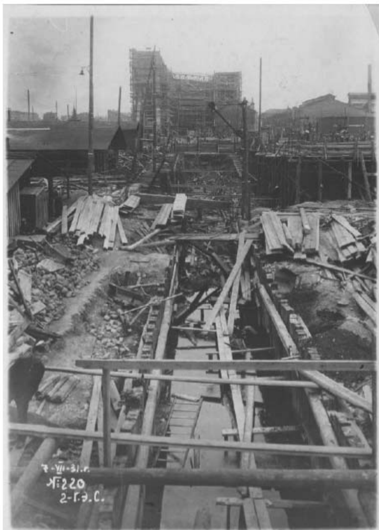
105. Строительство новой котельной. Дата съемки: 07.07.1931 г. // Источник: Архив ТЭЦ-2.
