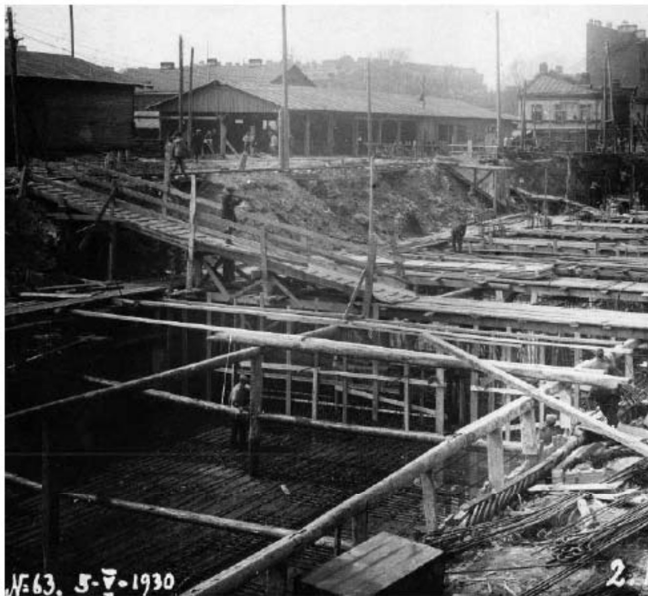
86. Начало строительства новой котельной. Вид на котлован. Дата съемки: 05.05.1930 г.
