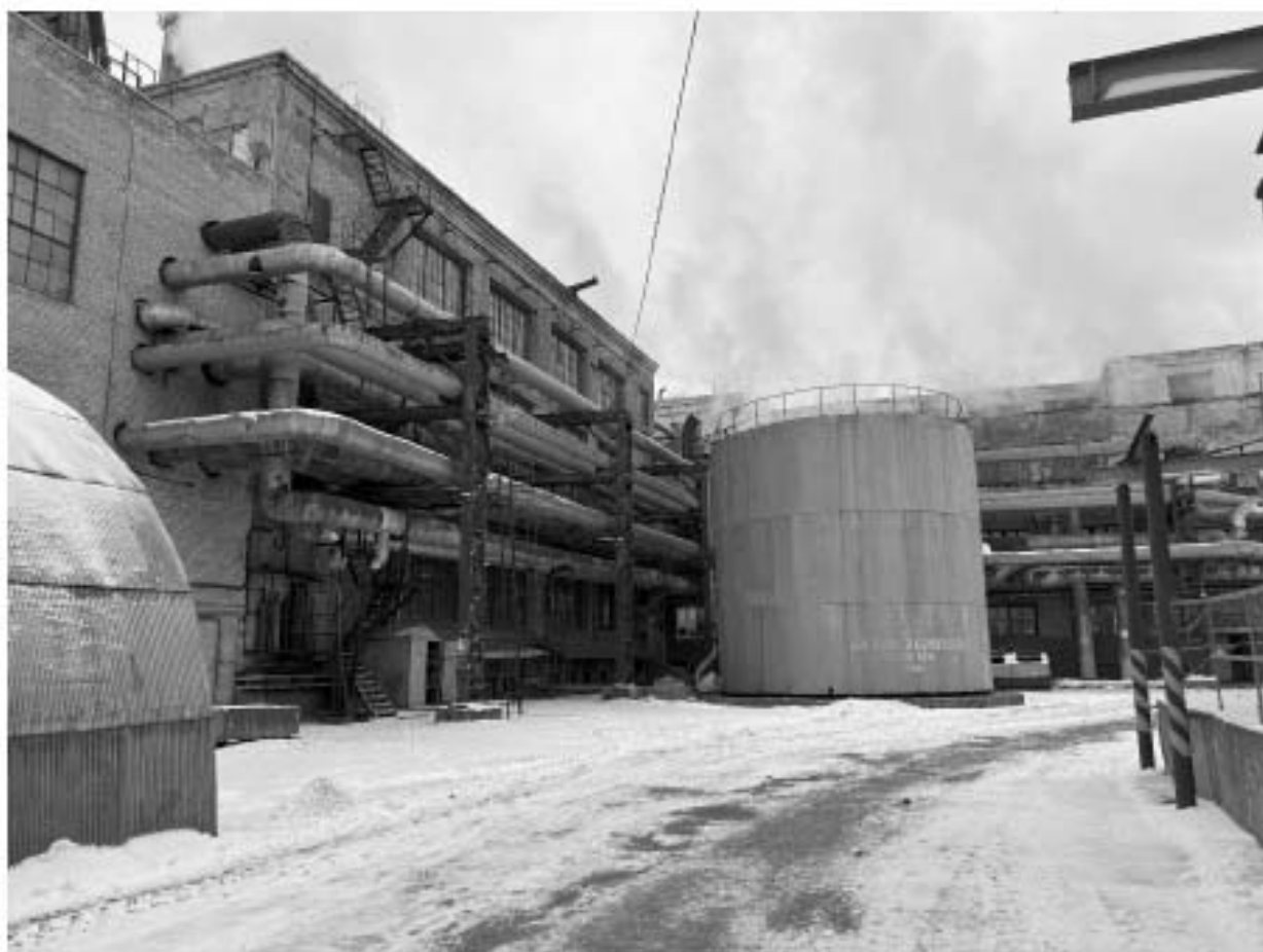
Фото 11. Северный фасад объекта культурного наследия «Административное здание и машинный зал».
