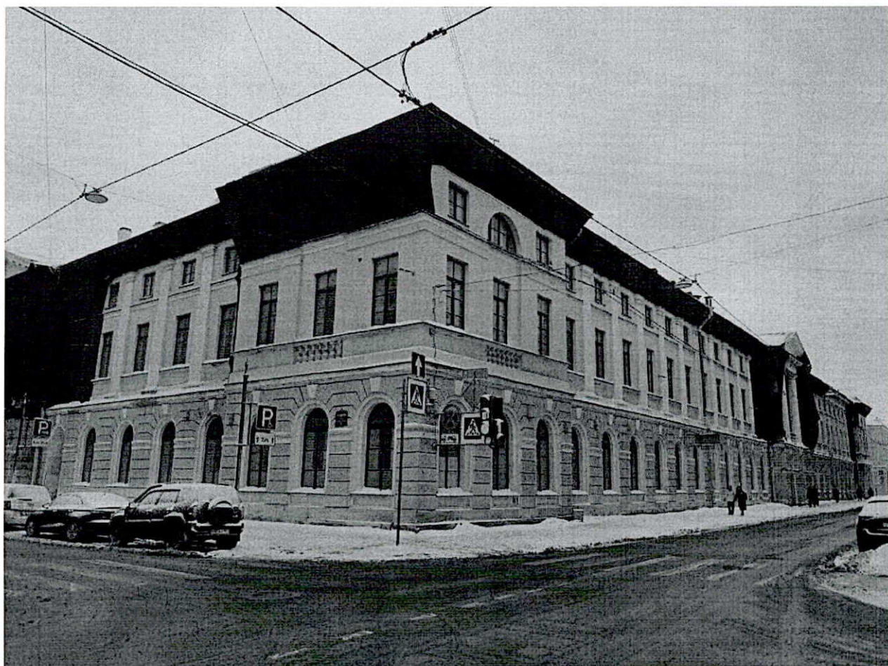
Южный лицевой фасад с переходной галереей
