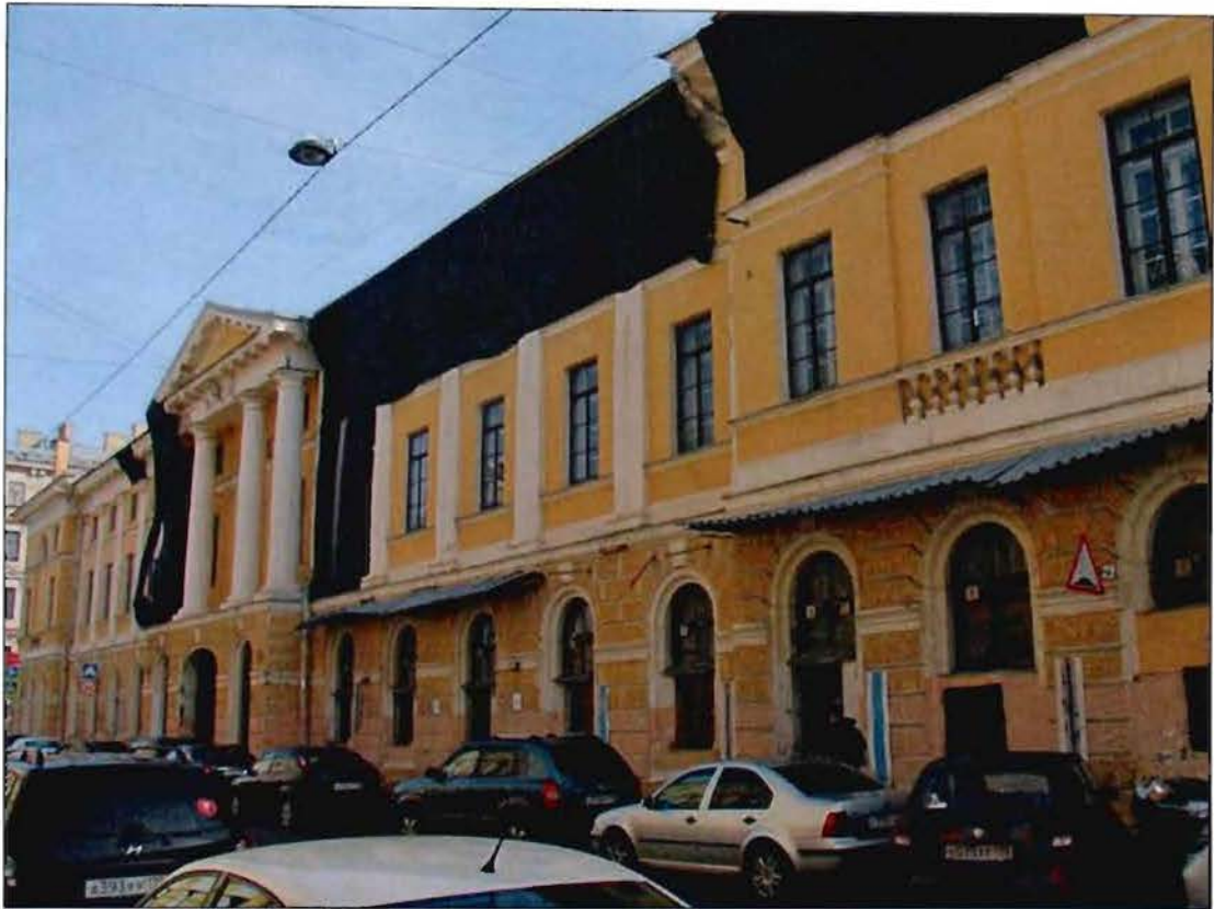
3. Северный лицевой фасад. Вид с запада.
