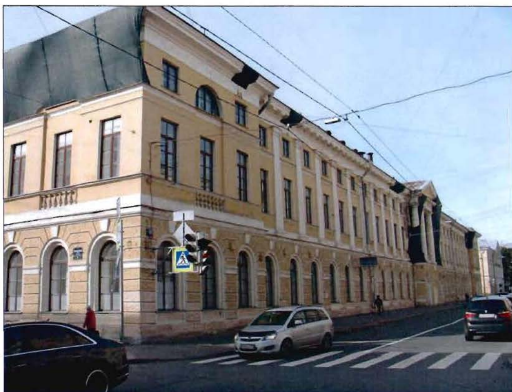
2. Восточный лицевой фасад. Вид с юго-востока.
