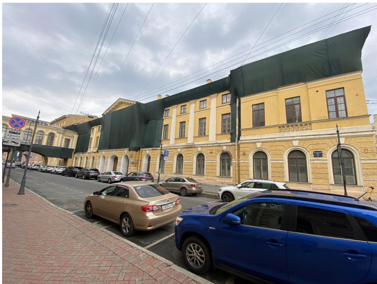
Фото №1. Угол северо-восточного и юго-восточного фасадов.
