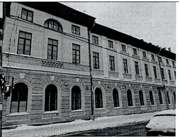
Восточный лицевой фасад. с юго-востока
