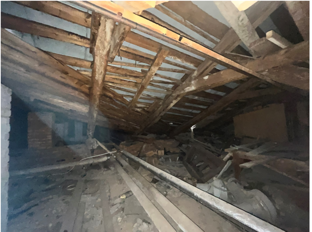
Фото №22. Чердачное пространство, фрагмент стропильной системы.
