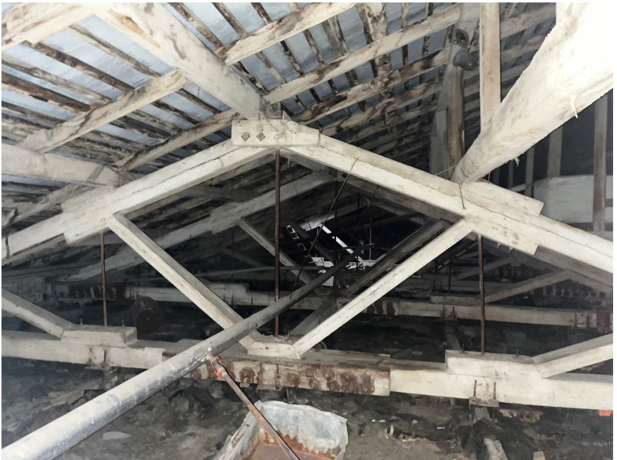
Фото №17. Чердачное пространство, фрагмент стропильной системы.
