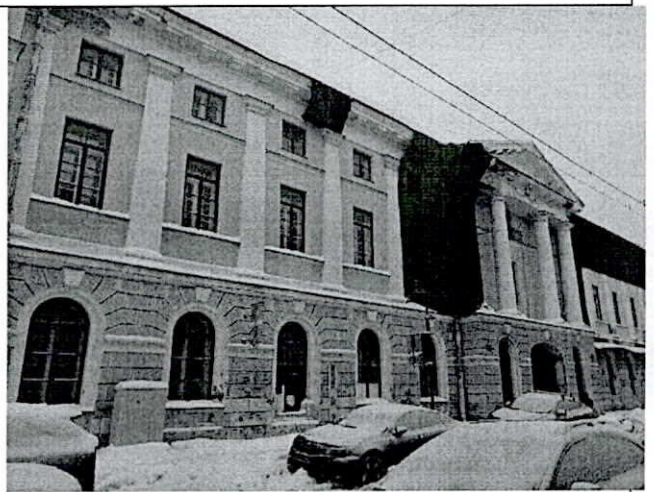
Северный лицевой фасад. Вид с запада
