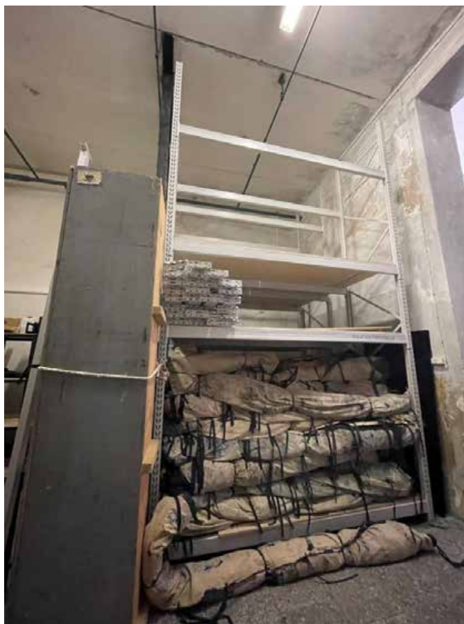
Фото 9. Интерьер пом. 8-Н (ч.п.3) объекта культурного наследия федерального значения «Дом Голенищева-Кутузова П.В. Здесь в 1924-1939 гг. жил художник Бродский И.И.»
