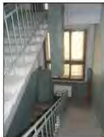
историческая лестница, ведущая к обсерватории, помещения 1-Н(419) пл. 24,4 кв. м, 1-Н(438) пл. 24,5 кв. м – местоположение, габариты, конфигурация, тип (винтовая), материал (металл), рисунок подступенков (ажурный); ограждение в виде вертикальных стоек;
