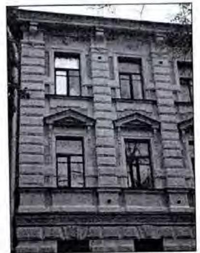
оформление оконных проемов 2 и 3 этажей – профилированные наличники с перехватами в нижней части; треугольные профилированные сандрики окон 2-го этажа центральной части на кронштейнах; прямые профилированные сандрики сдвоенных окон 2-го этажа вне раскреповки на кронштейнах; лавровые гирлянды; подоконные филенки; маскароны над окнами 3-го этажа;
