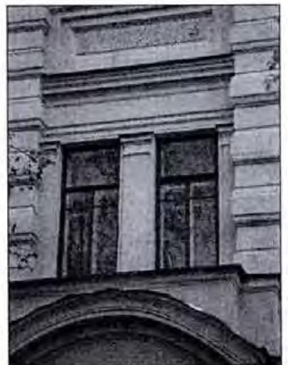
оформление оконных проемов 3-го этажа – профилированные архивольты, декорированные замковыми камнями, на профилированных импостах; подоконные филенки в перспективном обрамлении;
