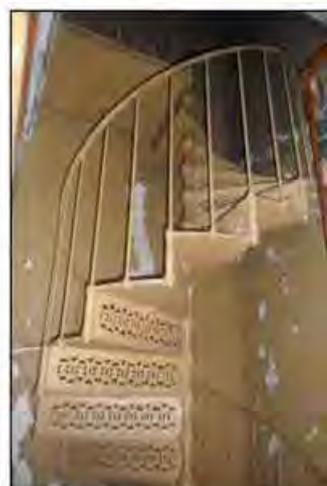
балкон в актовом зале (пом. 1-Н(332) пл. 370,0 кв. м) – местоположение, габариты, конфигурация, конструкция (на прусских сводах); ограждение – материал (металл), техника исполнения, рисунок (растительный орнамент);
