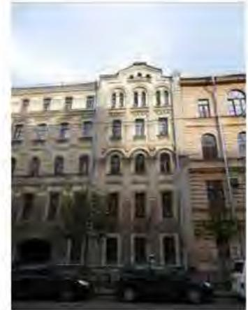
оконные проемы – местоположение, габариты и конфигурация, включая проемы 3-го этажа в форме полуциркульной арки и проемы 4-5-го этажей с лучковыми перемычками;
