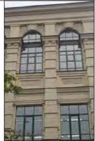
оформление оконных проемов 1-го этажа – профилированные наличники, декорированные замковыми камнями в виде «бриллиантового» руста;
