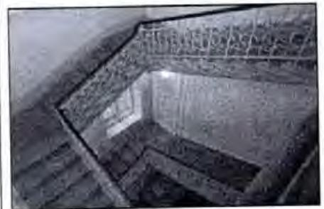
историческая лестница (Л-4) – местоположение, габариты, конфигурация, тип (двухмаршевая), конструкция; материал ступеней (известняк) и конфигурация (с валиком); ограждения маршей – материал (металл);
