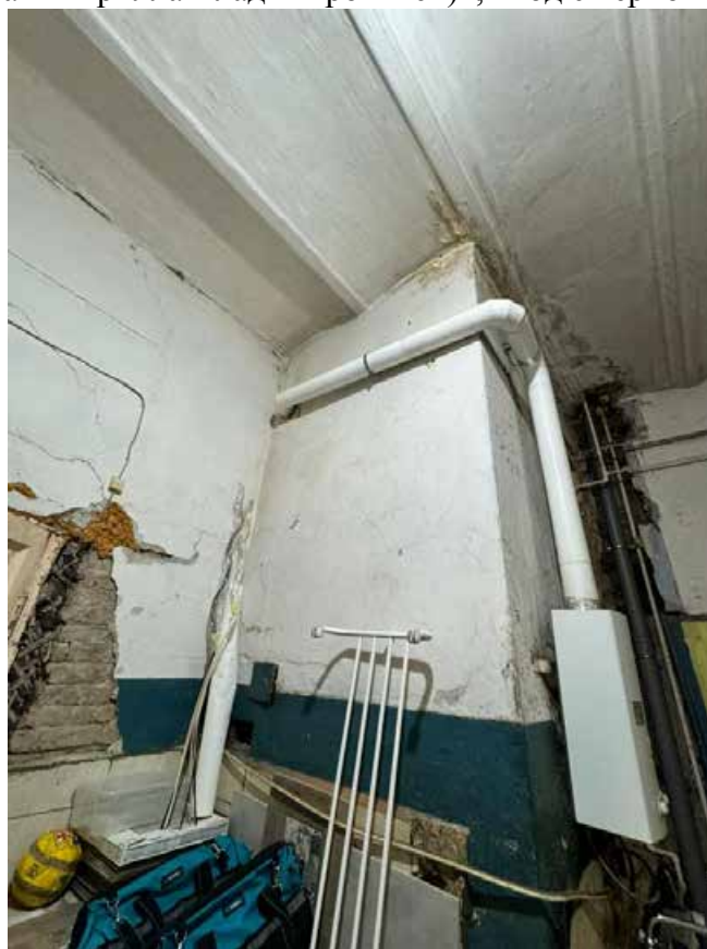
Фото 6. Интерьер квартиры №39 объекта культурного наследия регионального значения «Дом по наб. р. Мойки (с флигелями)», входящего в состав объекта культурного наследия регионального значения «Доходные дома фон Дервиза П.П. (великих князей Бориса и Кирилла Владимировичей)»
