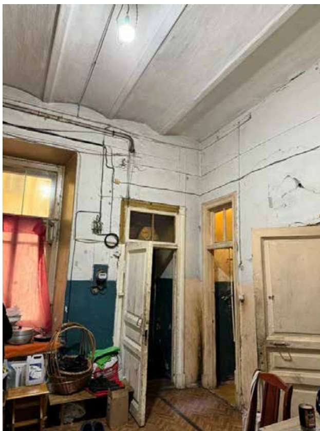
Фото 7. Интерьер квартиры №39 объекта культурного наследия регионального значения «Дом по наб. р. Мойки (с флигелями)», входящего в состав объекта культурного наследия регионального значения «Доходные дома фон Дервиза П.П. (великих князей Бориса и Кирилла Владимировичей)»
