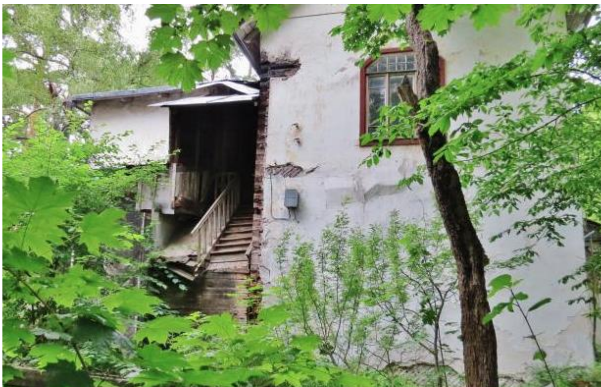
Илл. 9. Южный фасад исследуемого здания. Дата: 2017 г. Источник: citywalls.ru.
