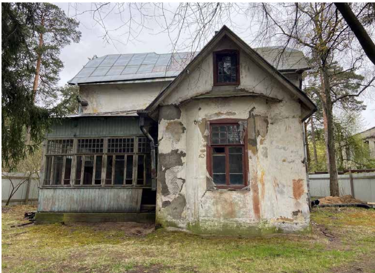
Фото 3. Вид на северный фасад.
