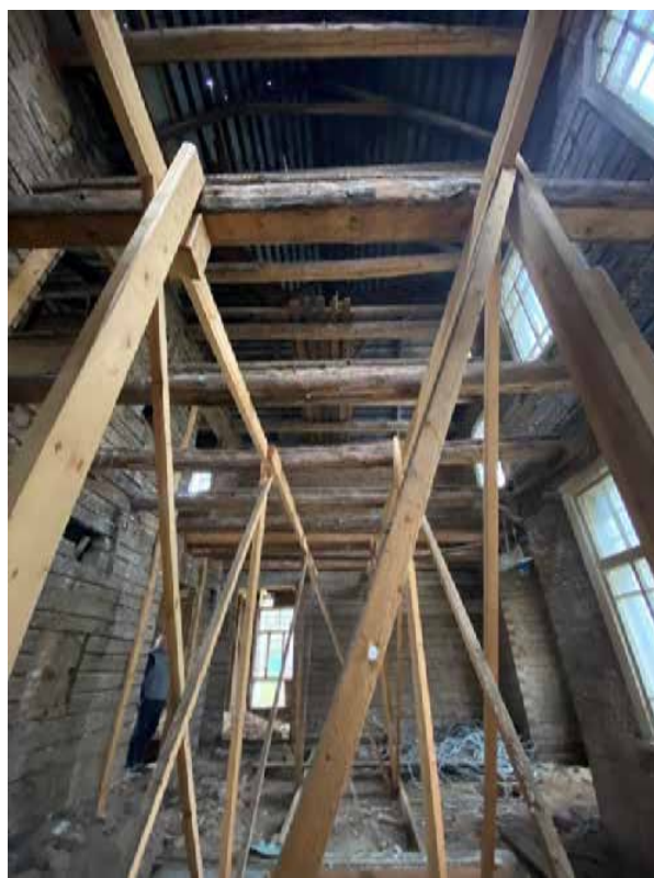
Фото 10. Вид на помещения №№ 3 и 4.
