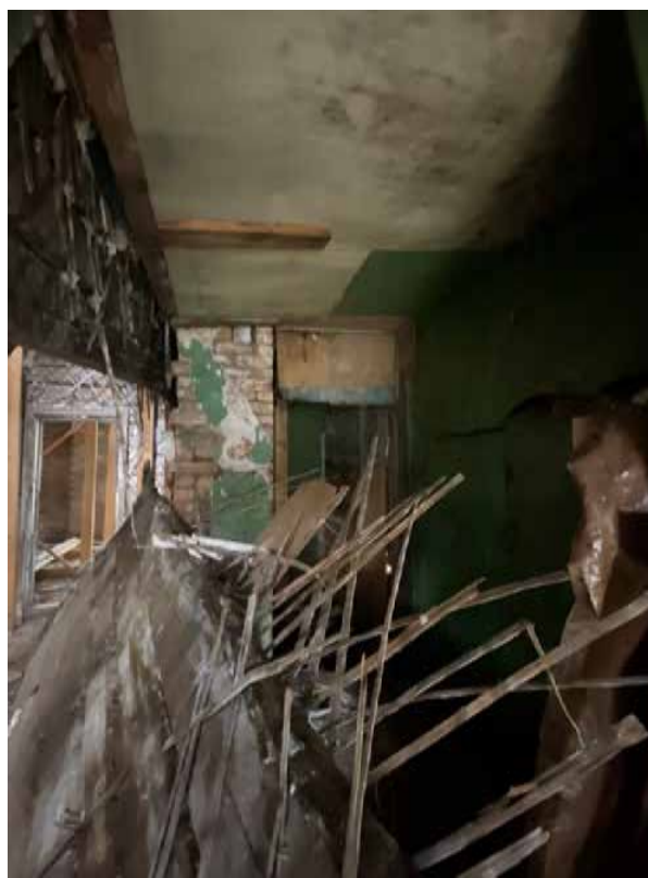
Фото 12. Вид на помещение № 1.
