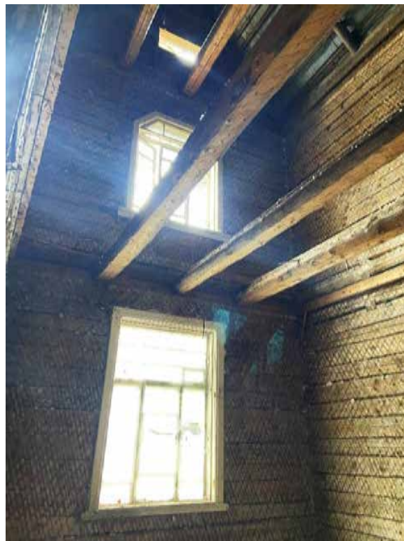
Фото 2. Вид на помещение № 2.
