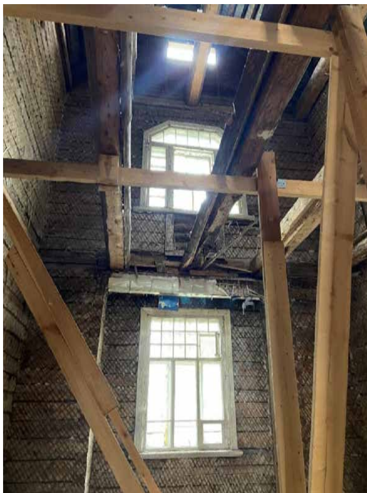
Фото 8. Вид на помещение № 4.
