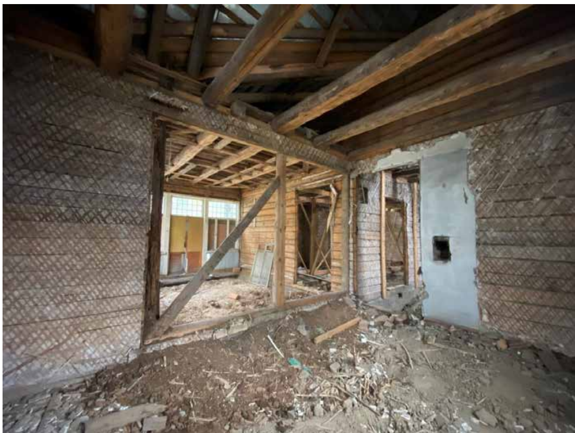
Фото 7. Вид на помещение № 1.
