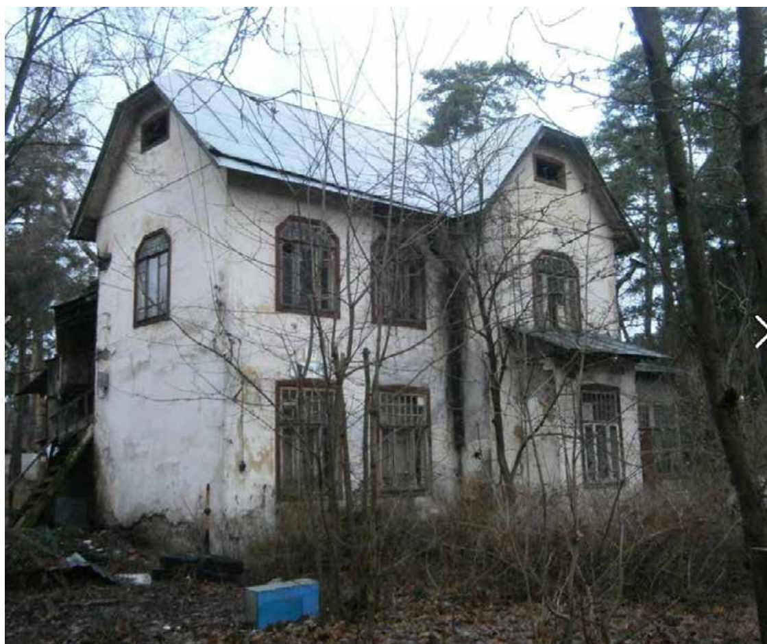
Илл. 8. Юго-восточный угол исследуемого здания. Дата: 2013 г. Источник: citywalls.ru.
