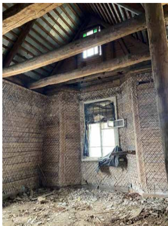
Фото 4. Вид на помещение № 6.
