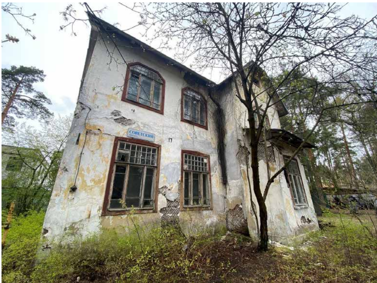
Фото 5. Вид на восточную часть фасада.
