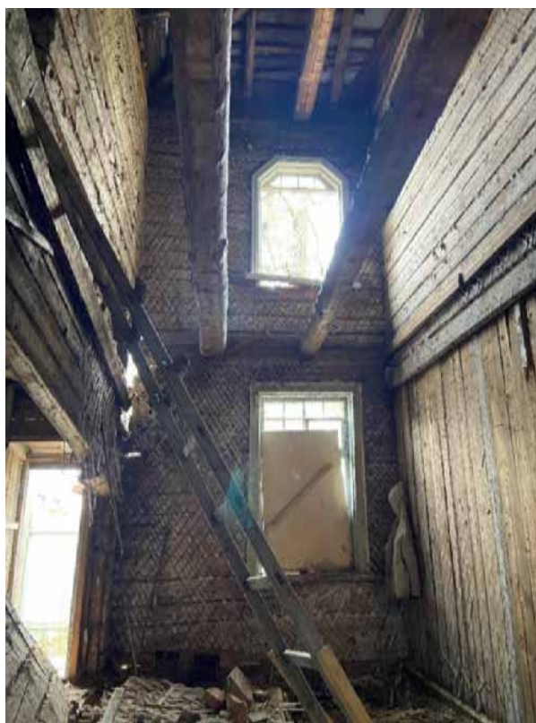
Фото 11. Вид на помещение № 8.
