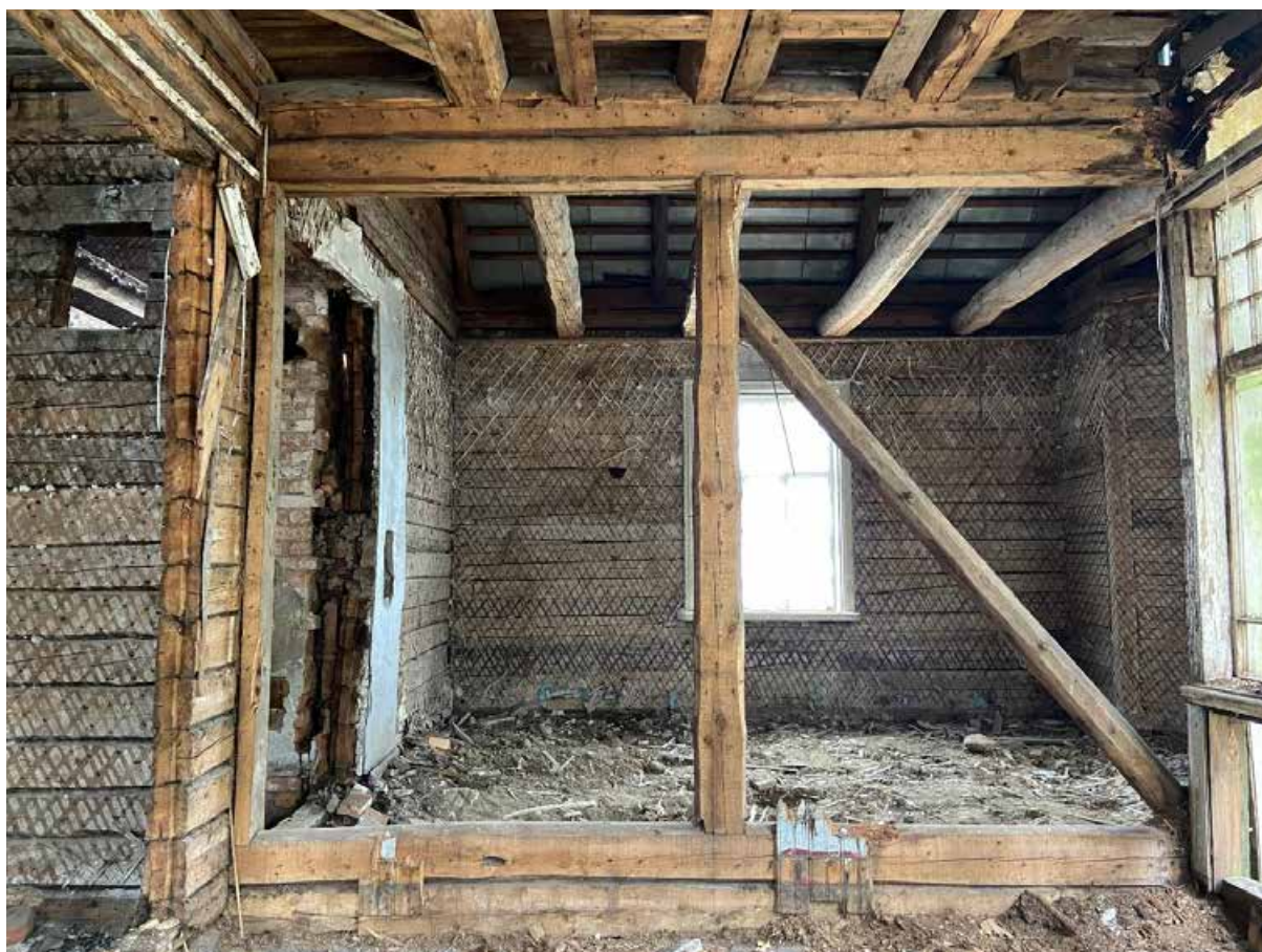
Фото 6. Вид с веранды на помещение № 6.
