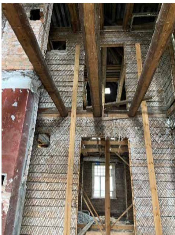
Фото 3. Вид на помещения №№ 8 и 9.
