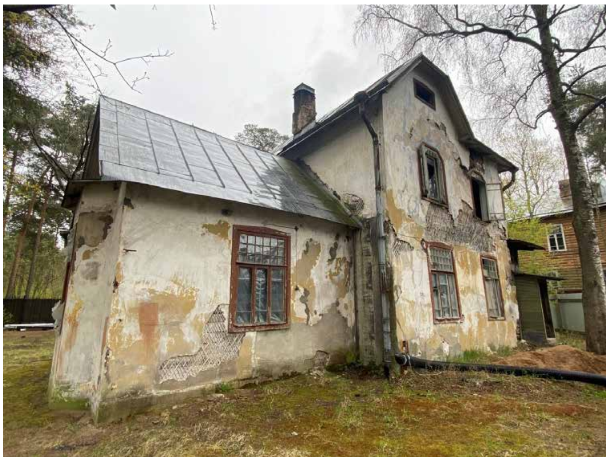
Фото 2. Вид на западный фасад.
