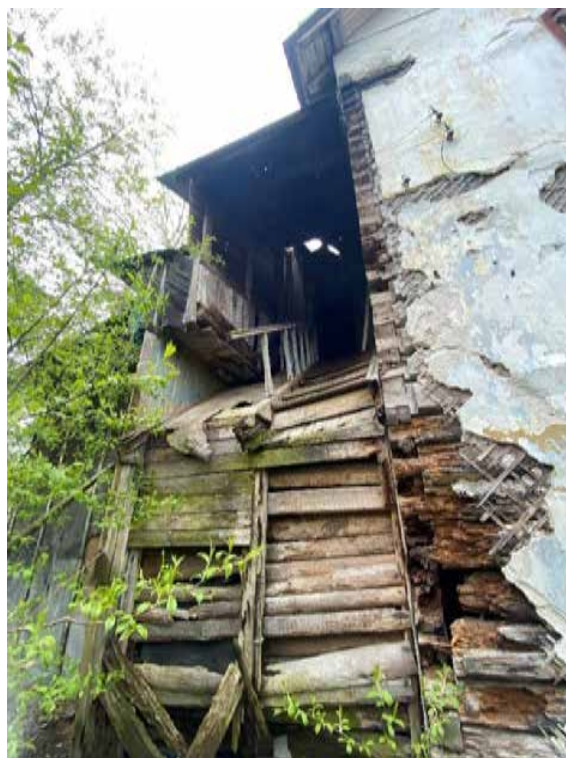
Фото 7. Фрагмент южного фасада.
