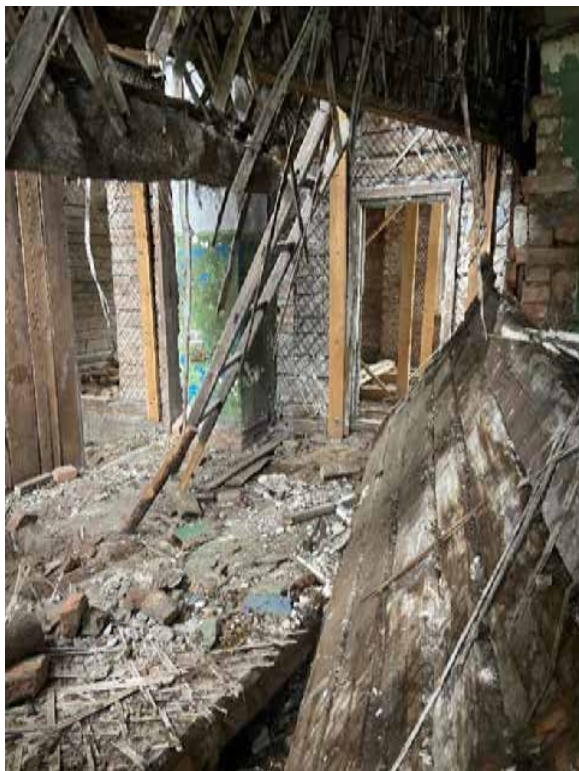
Фото 1. Вид на помещения №№ 8 и 9.
