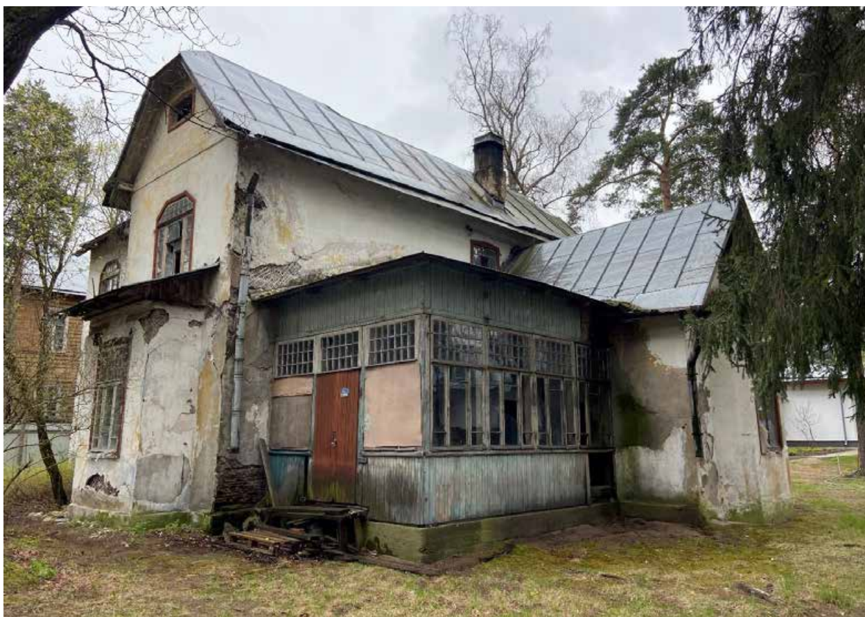
Фото 4. Вид на северо-восточный угол дома.
