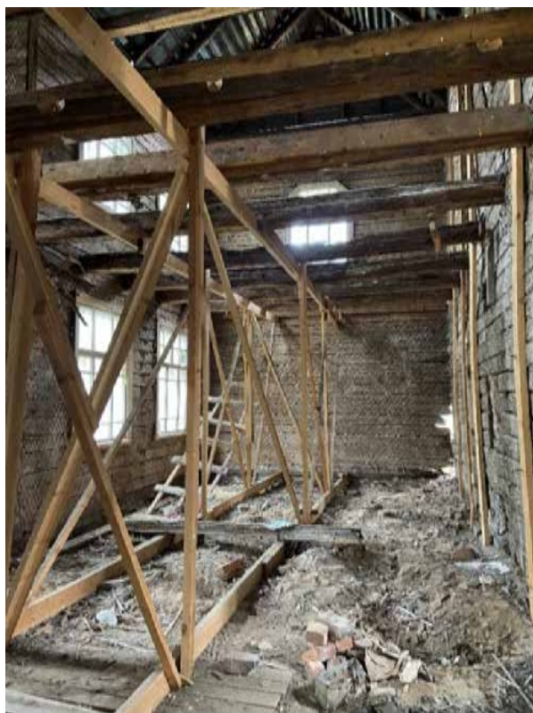
Фото 9. Вид на помещение № 3.
