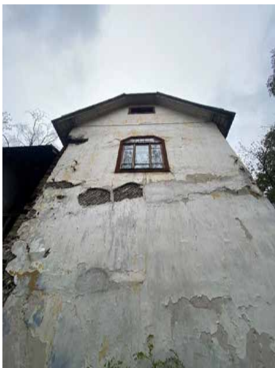
Фото 6. Фрагмент южного фасада.
