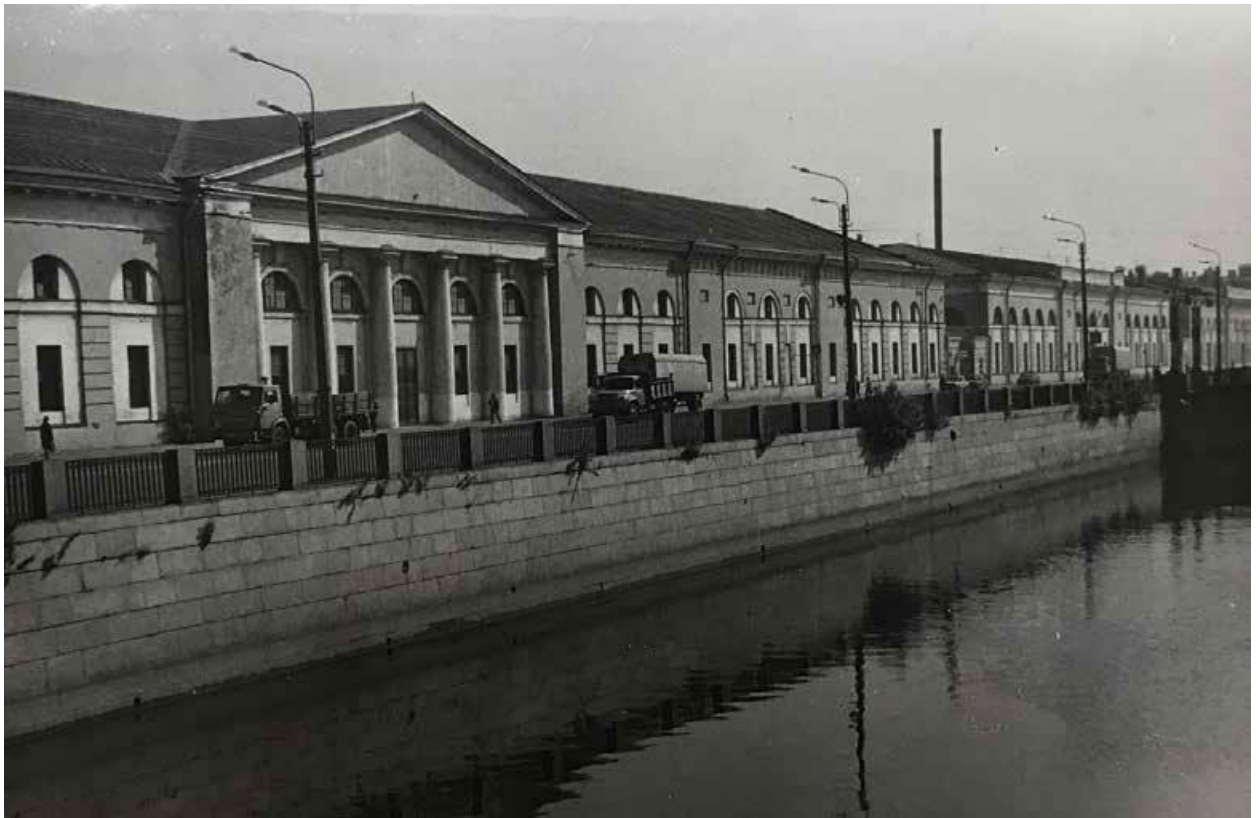
29. Склады провиантские Измайловского полка. Общий вид с юго-запада. Автор: С. Шмидт. 1993 г. // КГИОП. № 452/15-Н
