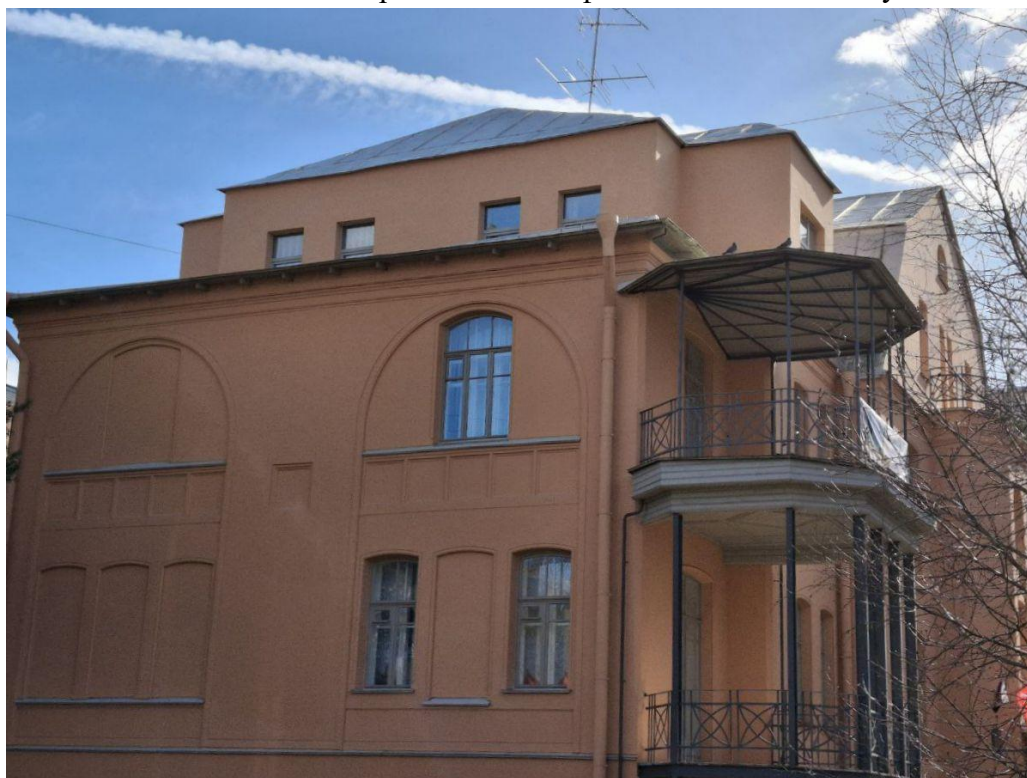
5. Вид на крышу и кованую веранду с северо-востока.
