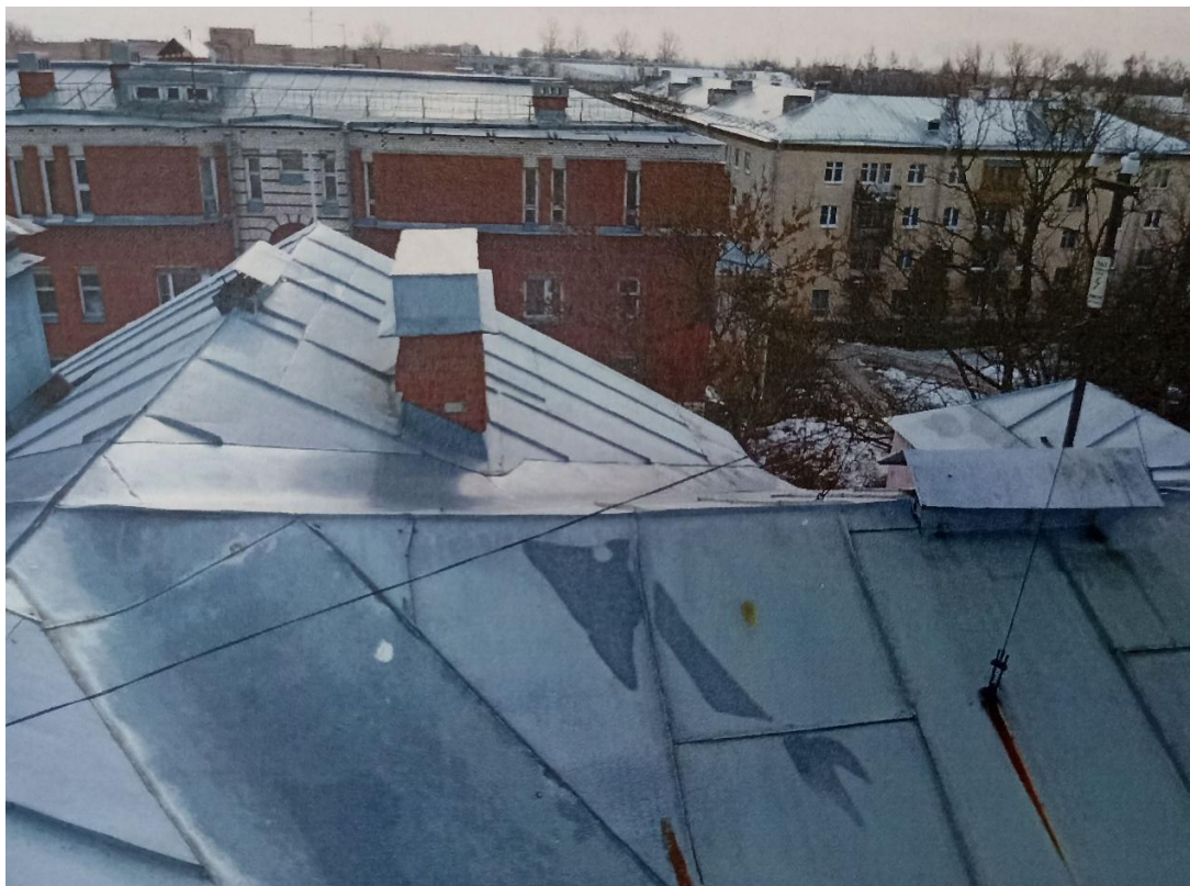
22. Вид металлического покрытия крыши в осях «Д...И» между осями «2/3...5». Архив КГИОП. Заключение по результатам технического обследования конструкций крыши здания. Разработано ЗАО «Стройком». 2012 г.
