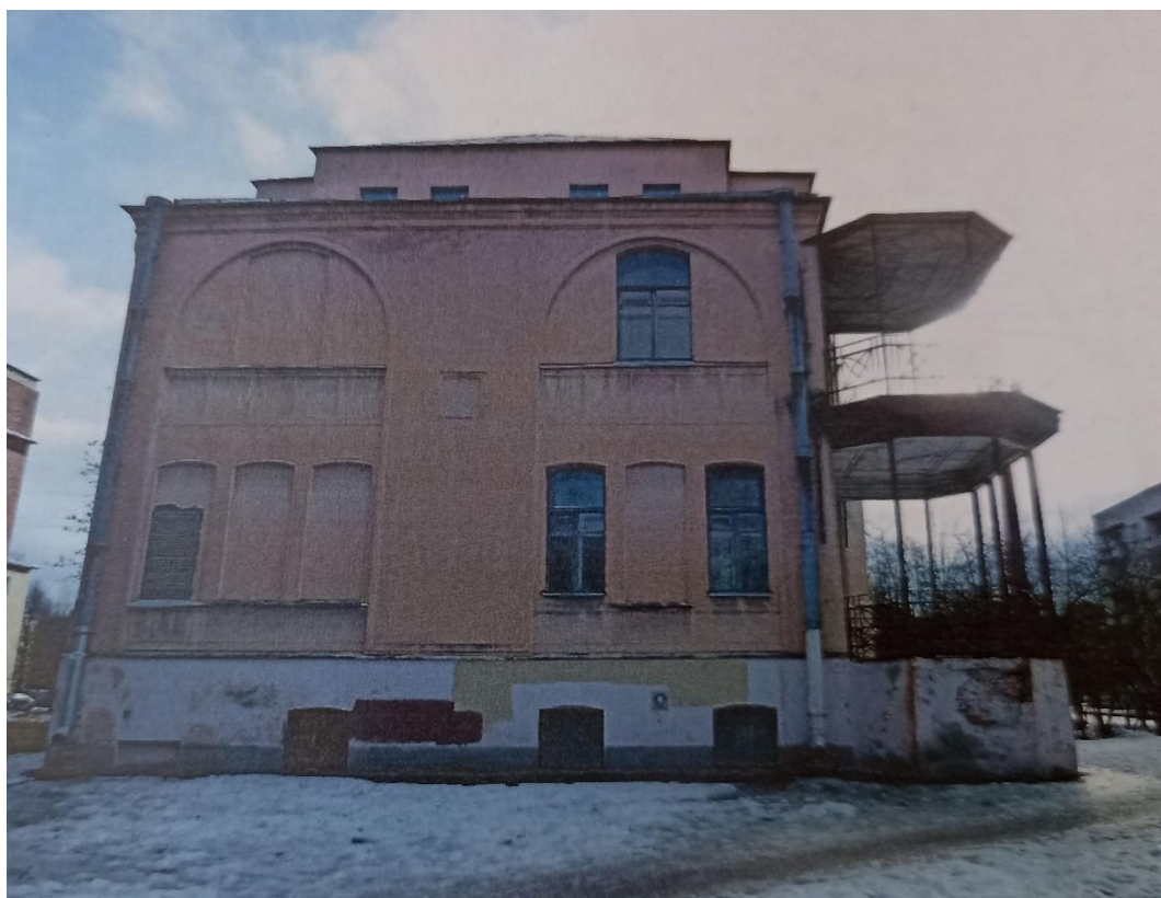
18. Общий вид здания с обследованными конструкциями крыши, фасад вдоль оси «1». Архив КГИОП. Заключение по результатам технического обследования конструкций крыши здания. Разработано ЗАО «Стройком». 2012 г.
