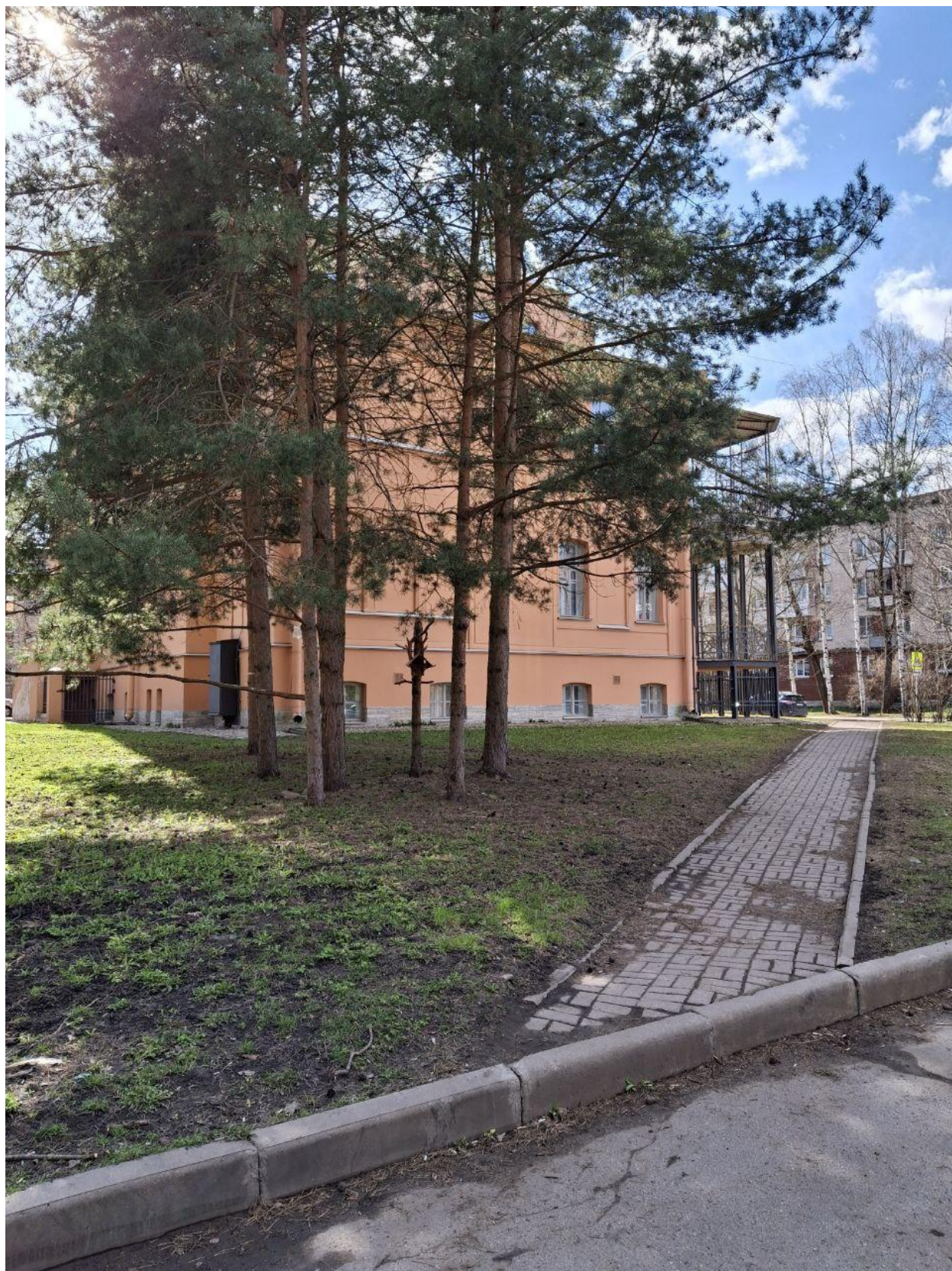
1. Вид на северо-восточный фасад от д.41 по Оранжерейной ул.
