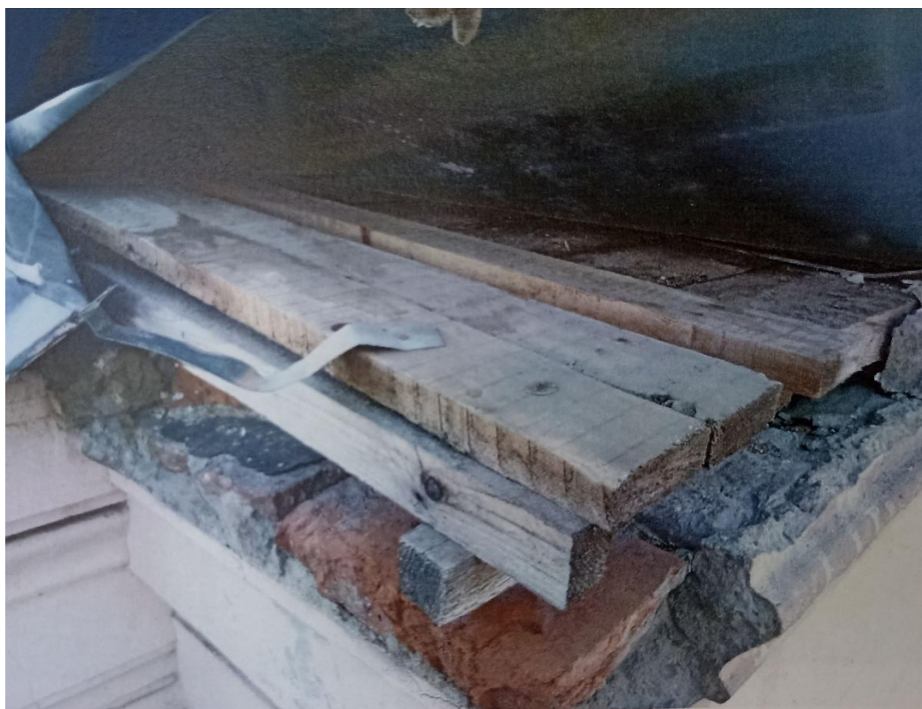
25. Вид деревянных конструкций крыши, уложенных с контруклоном в сторону наружных стен здания по осям «Г/1», «2/1».
