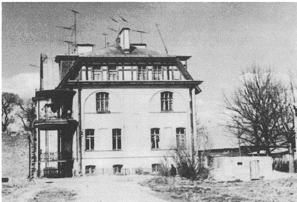
10. Вид на юго-западный фасад. Фото 1976 г. https://www.citywalls.ru/house20582.html
