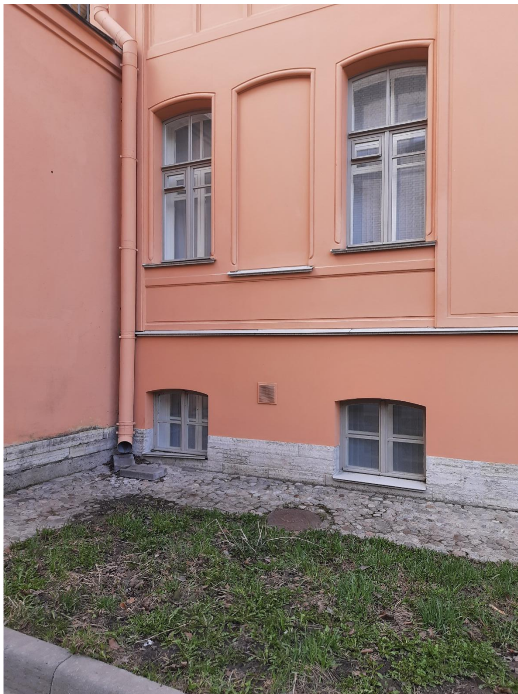
14. Фрагмент юго-восточного фасада.
