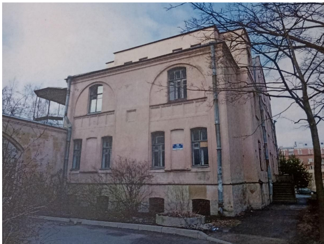
20. Общий вид здания с обследованными конструкциями крыши, фасад вдоль оси «б». Архив КГИОП. Заключение по результатам технического обследования конструкций крыши здания. Разработано ЗАО «Стройком». 2012 г.
