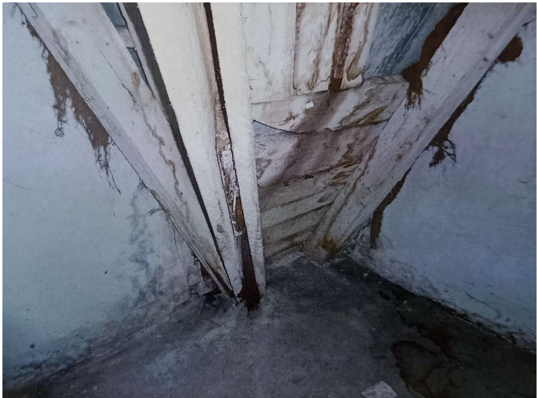
30. Вид стропильных конструкций крыши в осях «Е\1...И» между осями «4/1...4/2». Архив КГИОП. Заключение по результатам технического обследования конструкций крыши здания. Разработано ЗАО «Стройком». 2012 г.
