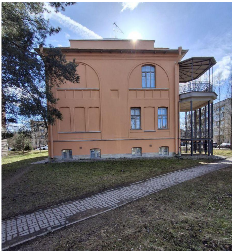
2. Вид на северо-восточный фасад.
