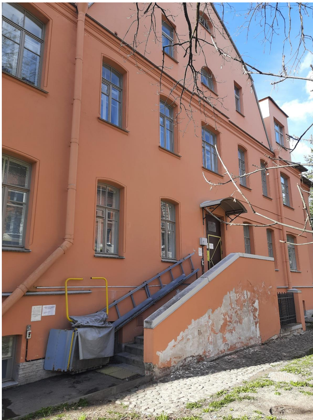
16. Вид на крыльцо юго-восточного фасада, вид с юго-востока.
