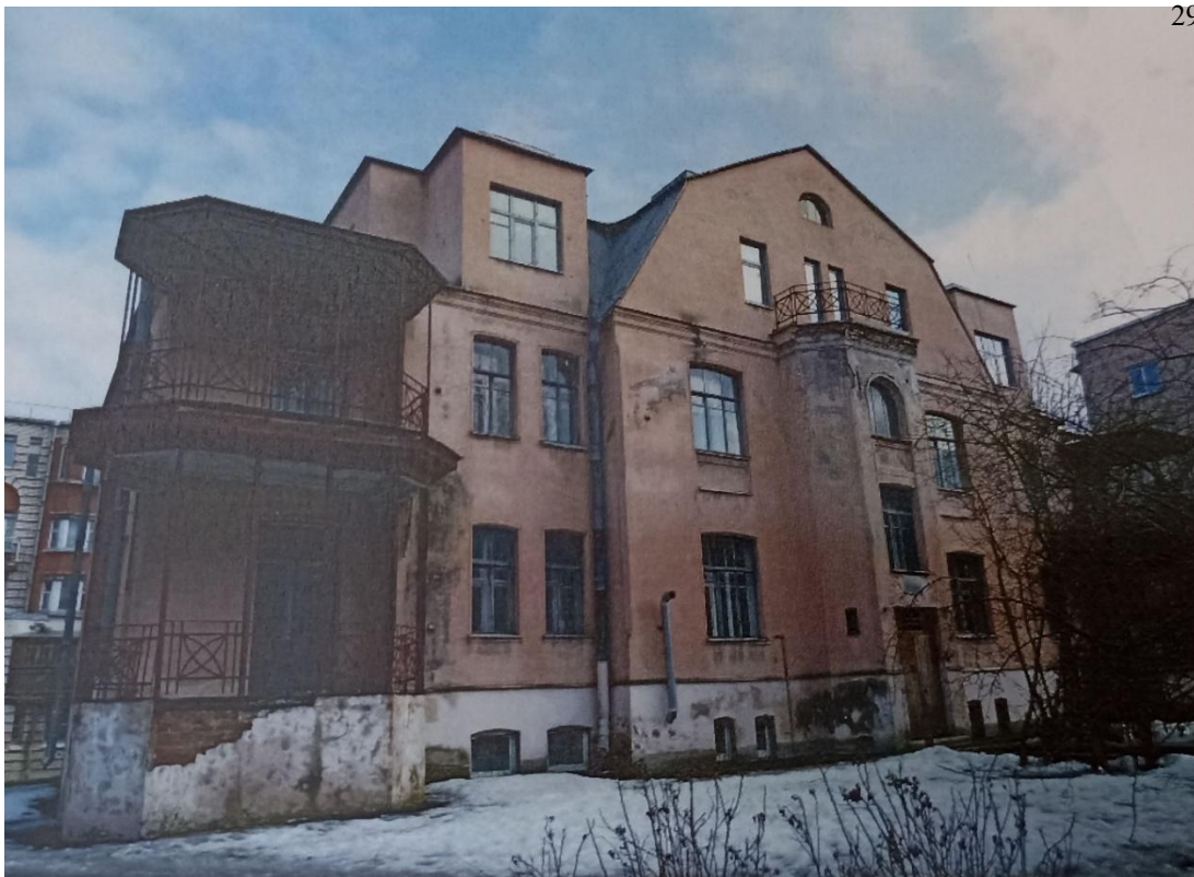
17. Общий вид здания с обследованными конструкциями крыши, фасад вдоль оси «А». Архив КГИОП. Заключение по результатам технического обследования конструкций крыши здания. Разработано ЗАО «Стройком». 2012 г.
