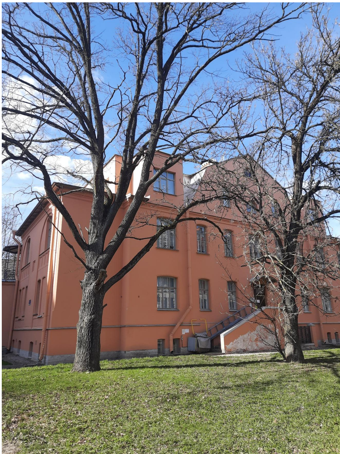
13. Вид на юго-восточный фасад с юго-востока.
