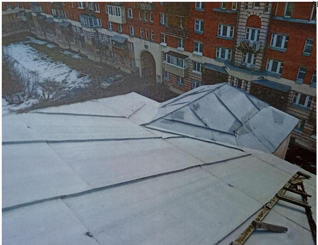
21. Вид металлического покрытия крыши в осях «Д...И» между осями «2...2/3». Архив КГИОП. Заключение по результатам технического обследования конструкций крыши здания. Разработано ЗАО «Стройком». 2012 г.
