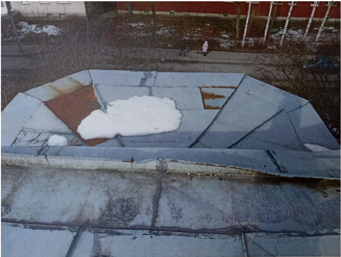
27. Вид состояния кровельного покрытия террасы, расположенной между осями «5...6». Архив КГИОП. Заключение по результатам технического обследования конструкций крыши здания. Разработано ЗАО «Стройком». 2012 г.
