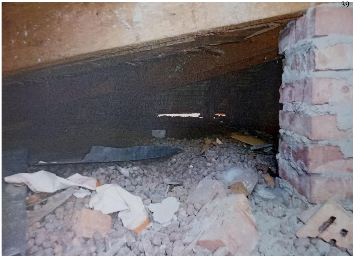
37. Вид стропильных конструкций крыши в осях «В...И» между осями «1...2». Архив КГИОП. Заключение по результатам технического обследования конструкций крыши здания. Разработано ЗАО «Стройком». 2012 г.
