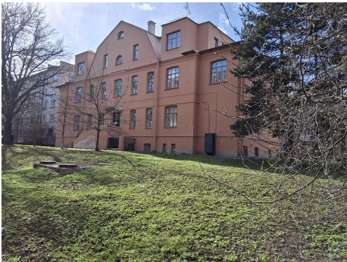
17. Общий вид на здание с северо-востока.
