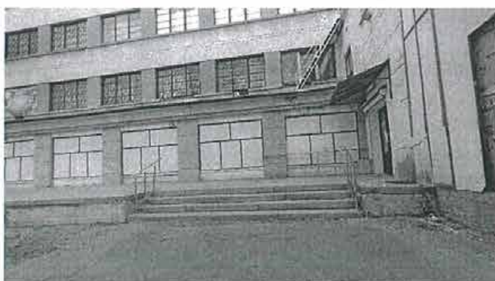
7. Фрагмент южного фасада
