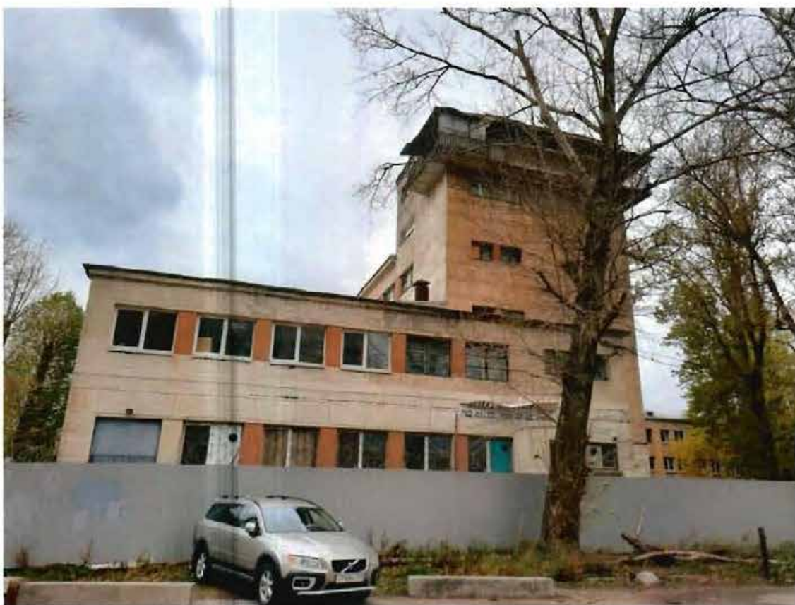
5. Вид на восточный фасад объекта культурного наследия
