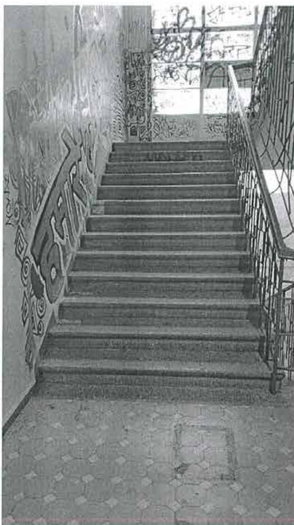
22. Общий вид лестничной клетки юго-восточной части здания.
