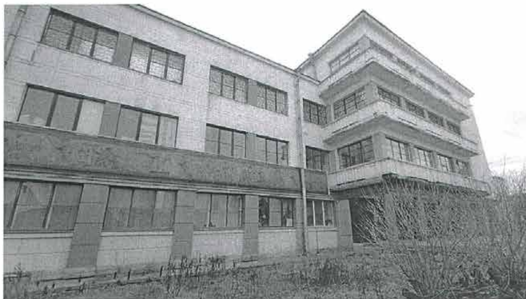
1. Вид Объекта со стороны пр. Стачек (западный фасад).
