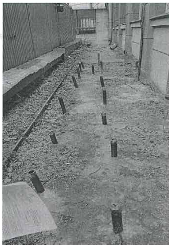
10. Фрагмент отмостки здания в процессе проведения работ по усилению основания
