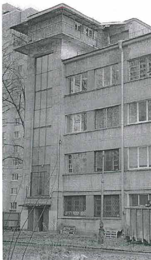
9. Фрагмент юго-восточной части здания.
