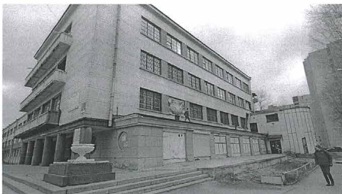
3. Вид южного фасада Объекта (юго-западная часть здания).
