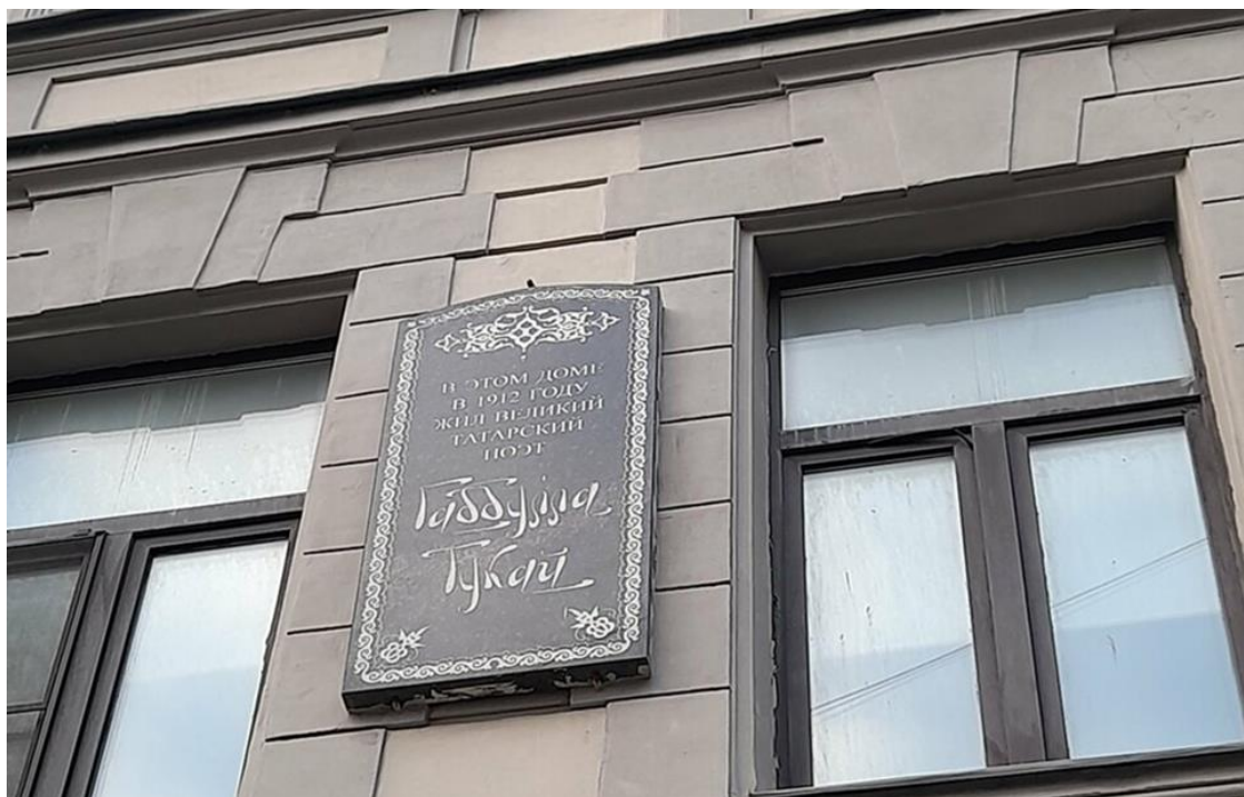
Фото 3. Фрагмент лицевого фасада по Казанской ул., 5. Мемориальная доска великому татарскому поэту Габдулле Тукаю. Дата фотофиксации - 06.12.2024 г.
