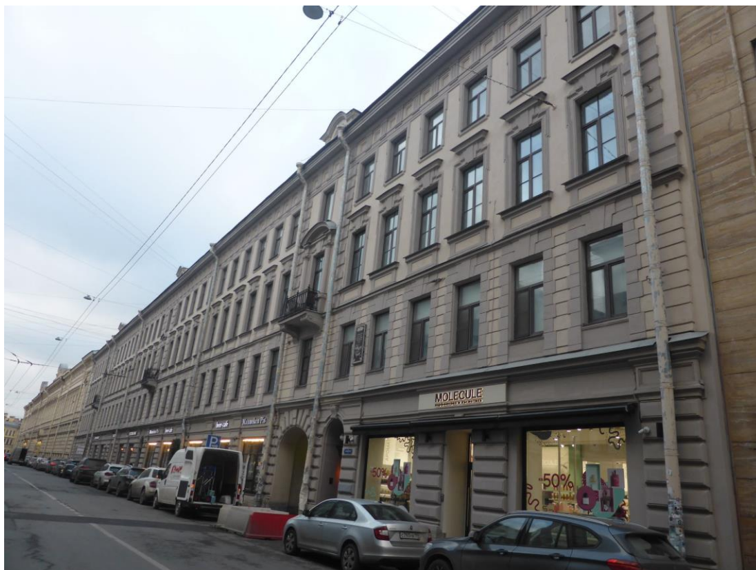
Фото 1. Лицевой фасад по Казанской ул., 5. Общий вид. Стены оштукатурены, с рустованными лопатками в уровне 1-го этажа, с рустовкой в уровне 2-го этажа, гладкими в уровне 3-4-го этажей. Дата фотофиксации - 06.12.2024 г.
