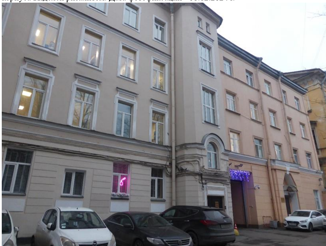
Фото 13. Южный двор. Фрагмент. Примыкание северо-восточного дворового корпуса дома по Казанской ул., 5, лит. А, к дому по Казанской ул., 7, лит. Б. Фасады оштукатурены, оформлены штукатурной рустовкой в нижних этажах. Лестничный объем северо-восточного дворового корпуса выделен ризалитом. Дата фотофиксации - 06.12.2024 г.
