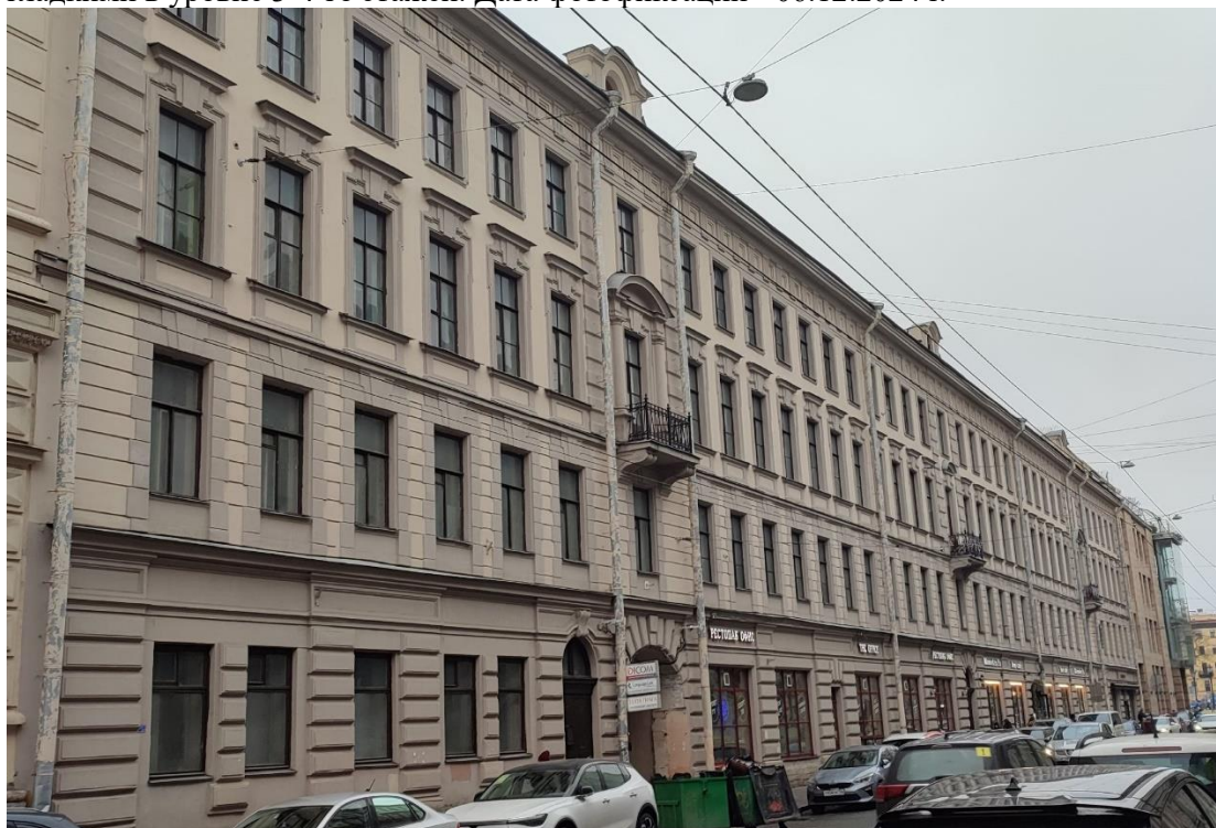
Фото 2. Лицевой фасад по Казанской ул., 5. Общий вид. В оформлении преобладают горизонтальные членения. Здание завершает венчающий профилированный карниз с фризом. Дата фотофиксации - 06.12.2024 г.
