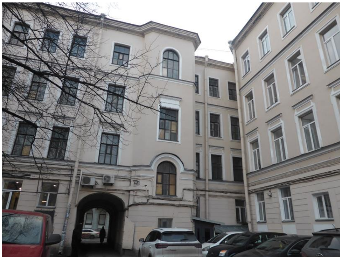
Фото 12. Южный двор дома по Казанской ул., 5. Фрагмент. Вид на дворовый фасад лицевого корпуса и северо-восточный дворовый фасад. Лестничный объем лицевого корпуса выделен ризалитом. Дата фотофиксации - 06.12.2024 г.
