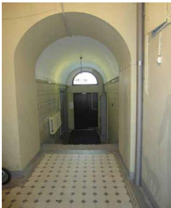
Фото 16. Вестибюль по 6 и 19 световым осям лицевого корпуса по Казанской ул., 5. Дата фотофиксации - 06.12.2024 г.
