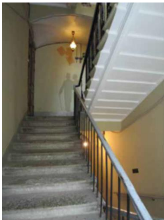
Фото 17. Вид лестниц по 6 и 19 световым осям лицевого корпуса по Казанской ул., 5 (ЛК2 и ЛК3). Дата фотофиксации– 06.12.2024 г.
