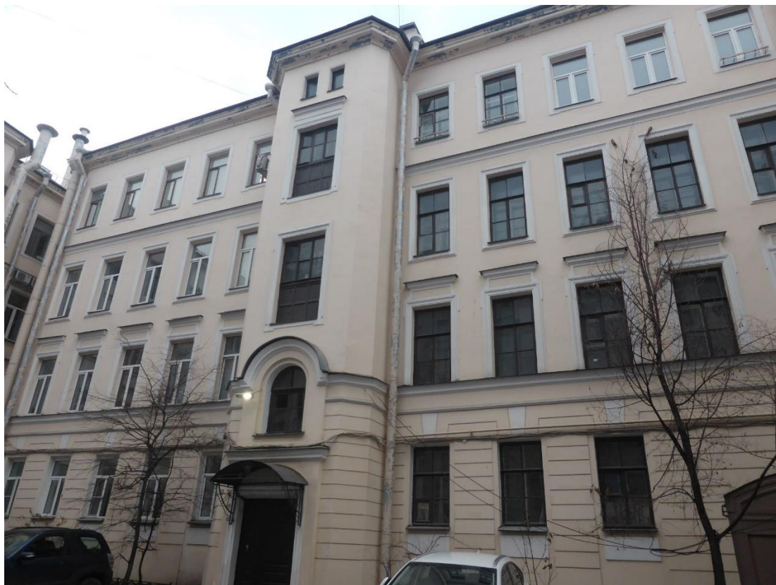
Фото 9. Северный двор дома по Казанской ул., 5. Общий вид на дворовый фасад северо-восточного корпуса. Фасад оштукатурен, оформлен штукатурной рустовкой в нижнем этаже. Лестничный объем выделен ризалитом. Дата фотофиксации - 06.12.2024 г.
