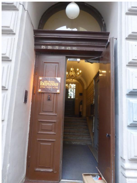
Фото 15. Вестибюль и лестница (ЛК1) по 32 световой оси лицевого корпуса по Казанской ул., 5. (Отель «Рахманинов»). Дата фотофиксации - 06.12.2024 г.
