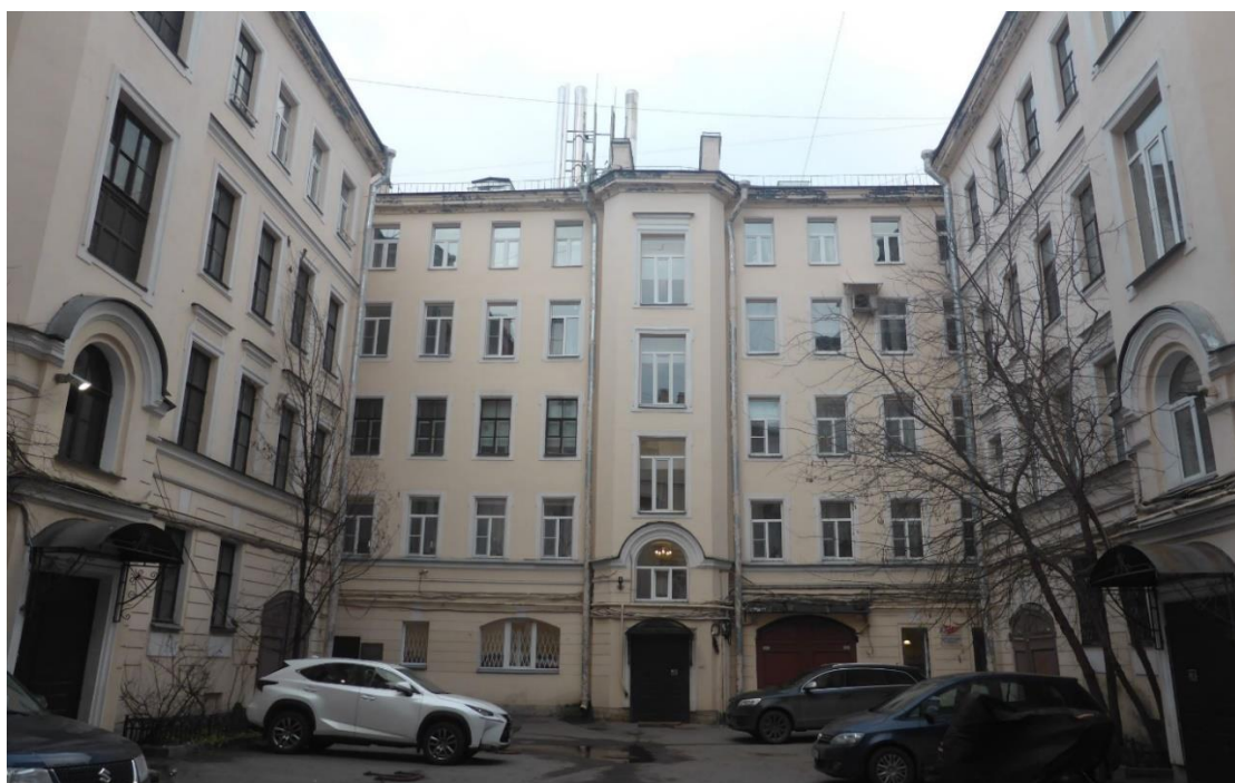
Фото 7. Северный двор дома по Казанской ул., 5. Общий вид на фасады юго-западного, северо-восточного и северо-западного дворовые корпусов. Фасады оштукатурены, оформлены штукатурной рустовкой в нижних этажах. Лестничные объемы выделены ризалитами. Дата фотофиксации - 06.12.2024 г.
