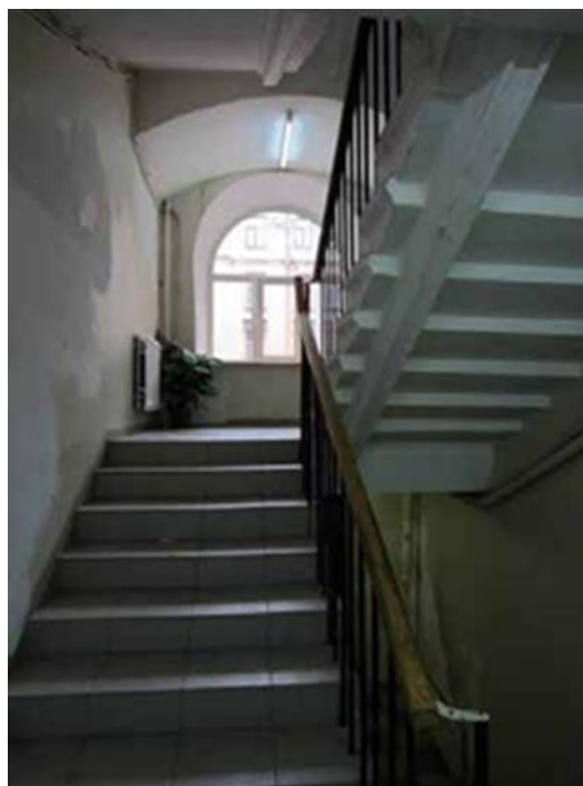
Фото 18. Вид лестниц в объемах ризалитов дворовых корпусов северного двора (ЛК4 и ЛК5). Дата фотофиксации-06.12.2024г.
