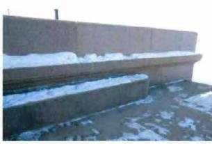
тетива лестниц из профилированных крупноразмерных блоков гранитных блоков;
