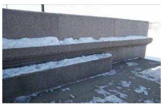
тетива лестниц из профилированных крупноразмерных блоков гранитных блоков;
