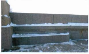
ступени лестниц из крупноразмерных профилированных гранитных блоков;
