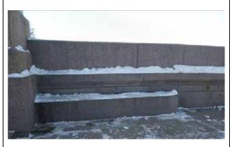
ступени лестниц из крупноразмерных профилированных гранитных блоков;
