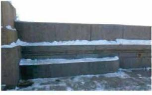
ступени лестниц из крупноразмерных профилированных гранитных блоков,
