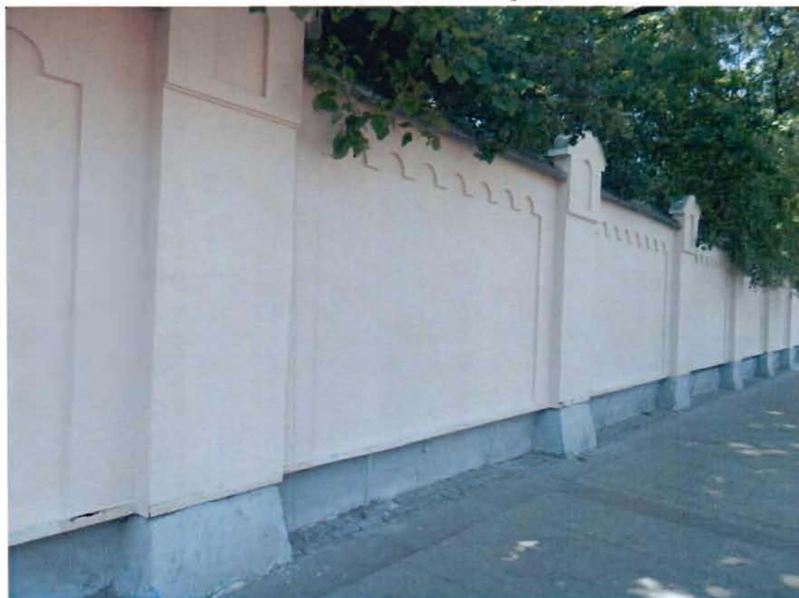
24. Восточная часть ограды
