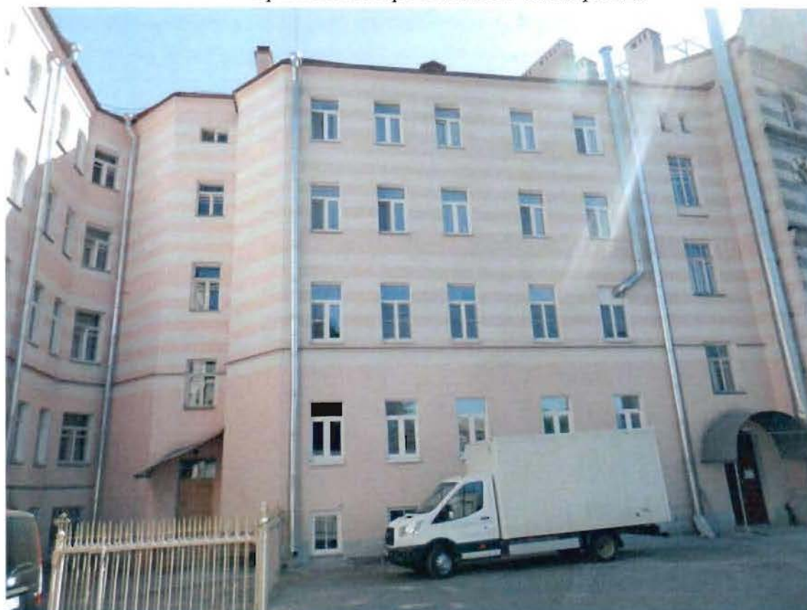
7. Фрагмент северо-западной части фасада
