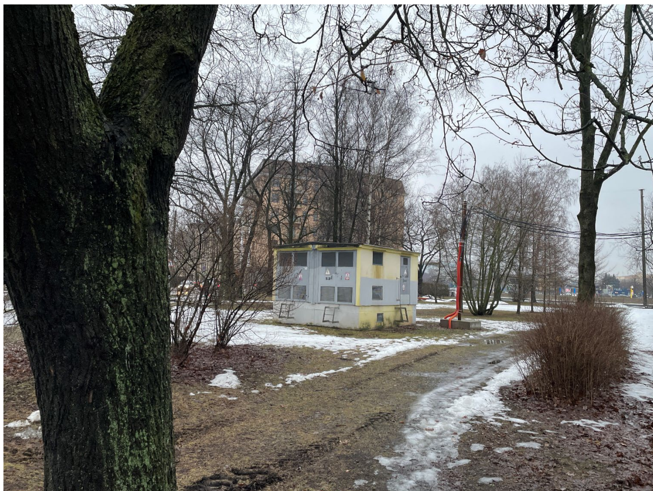
7. Вид на ТП и зону производства работ к северу от границ территории объекта культурного наследия регионального значения «Здание Санкт-Петербургского Гребного общества (с садом). Сад», расположенного по адресу: г. Санкт-Петербург, ул. Вязовая, д. 4, лит. А. 08.02.2025
