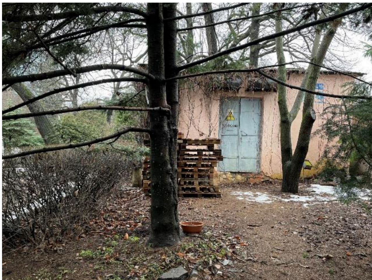
4. Вид на западный фасад ТП и зону производства работ в границах территории объекта культурного наследия регионального значения «Иоанновский монастырь с часовней, садом и оградой», расположенного по адресу: г. Санкт-Петербург, Карповки р. наб., д. 45, литеры А, Д. 08.02.2025
