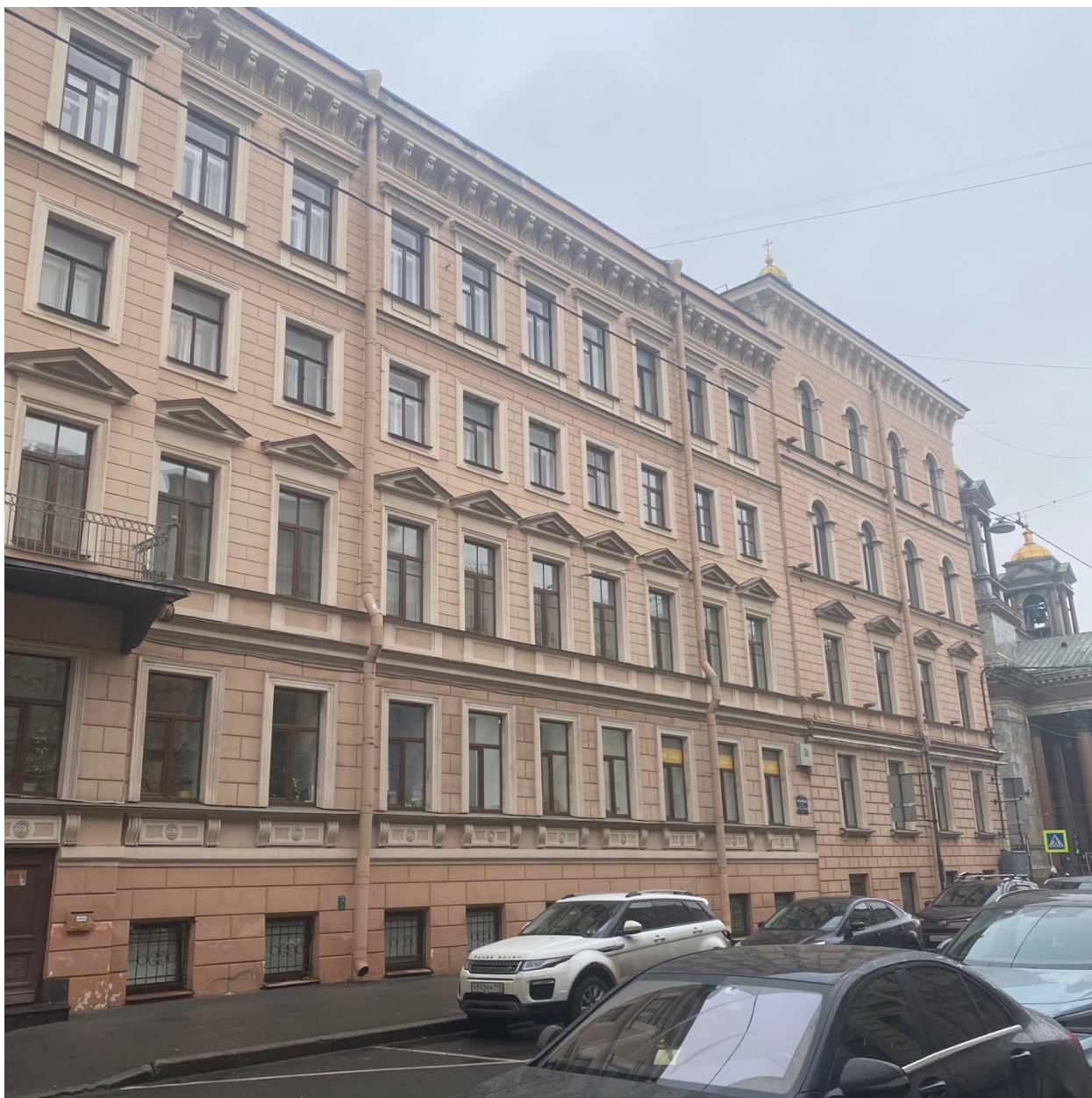
Фото 3. Общий вид на лицевой фасад объекта.
