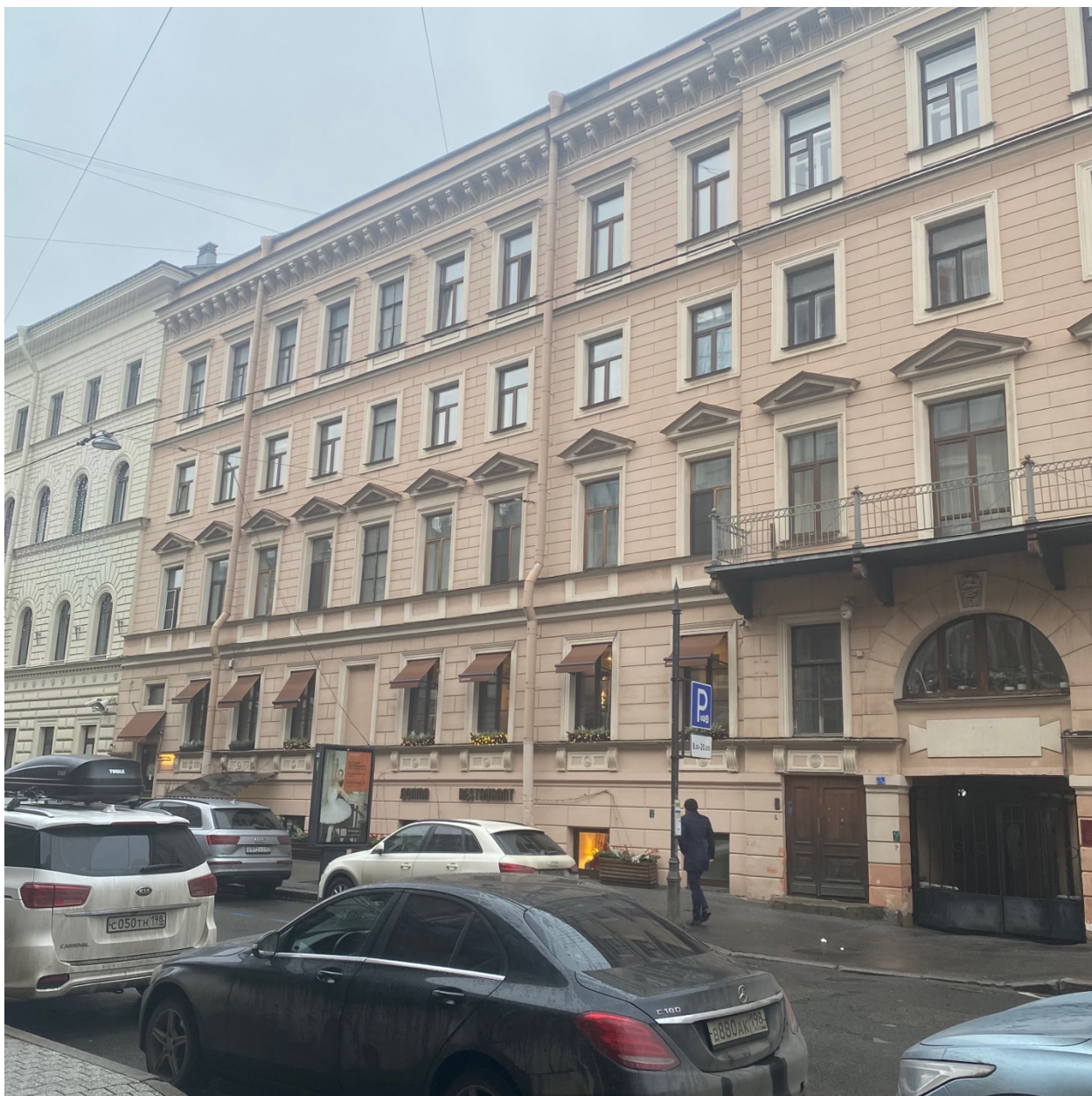
Фото 5. Общий вид на лицевой фасад объекта.
