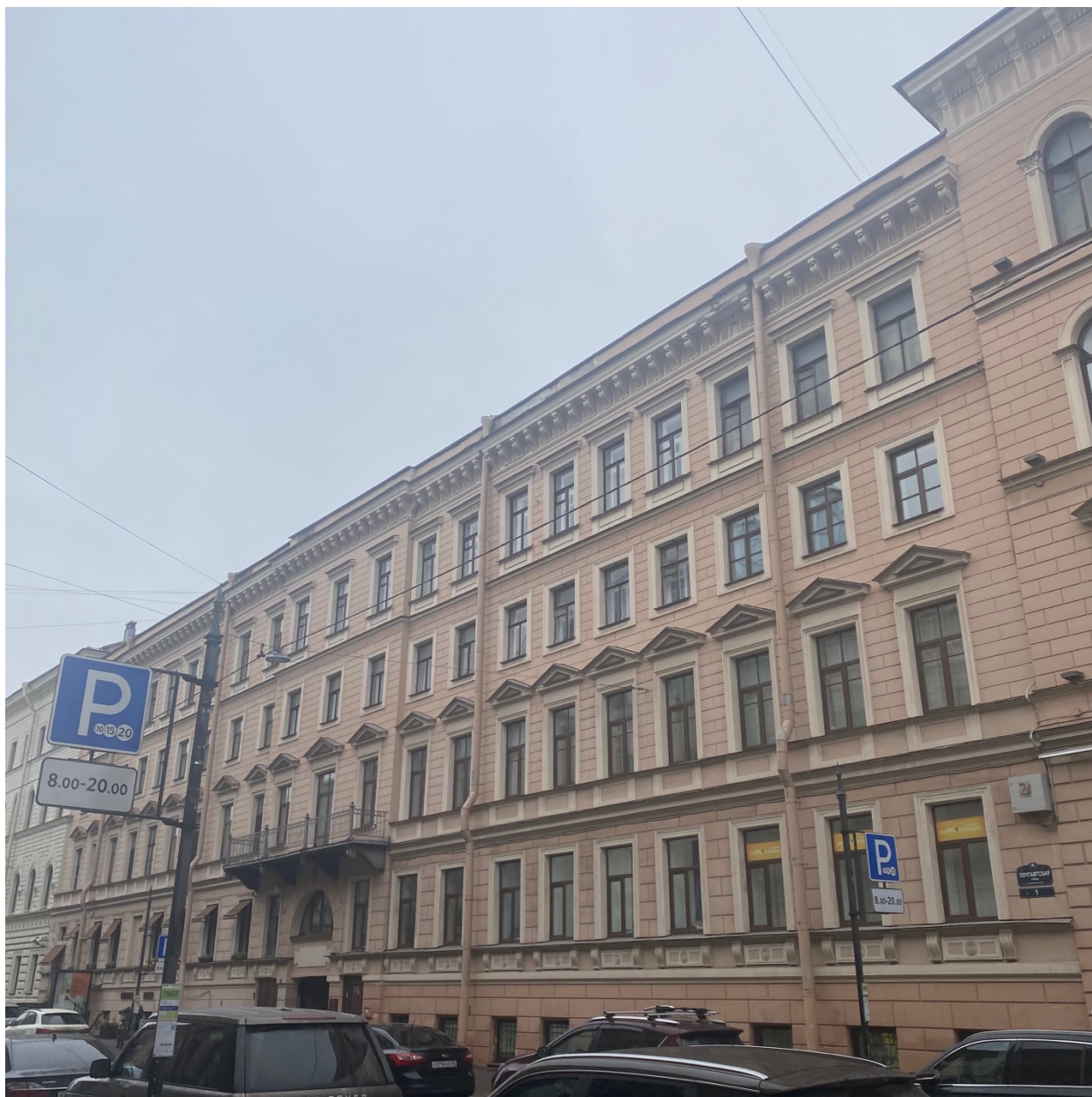
Фото 2. Общий вид на лицевой фасад объекта.
