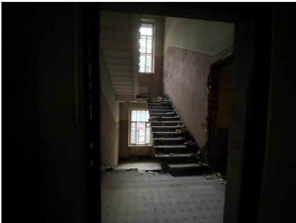
Фото 17. Лестница Л-2. 2 этаж.
