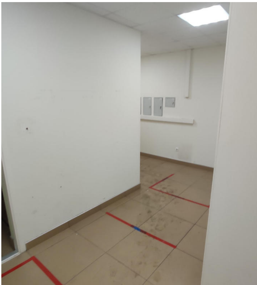
Фото 11. Фрагмент помещения 6-Н.
