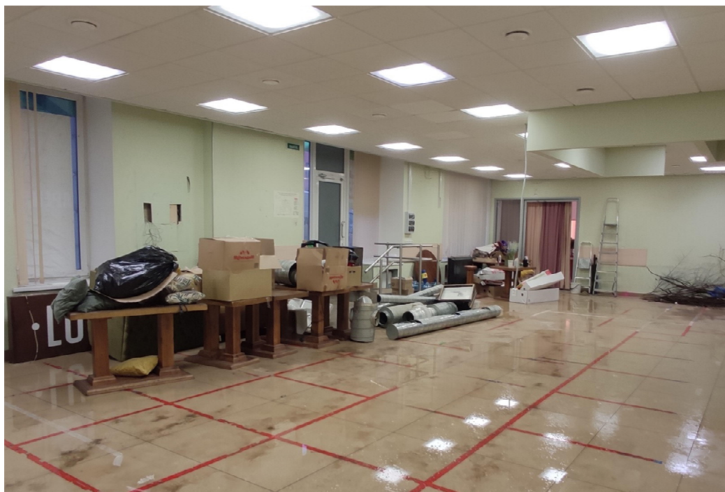
Фото 6. Фрагмент помещения 6-Н.
