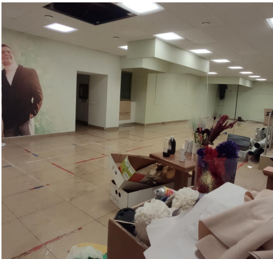
Фото 1. Фрагмент помещения 6-Н.
