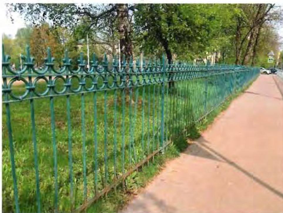
9. Общий вид на ограду с северной стороны.
