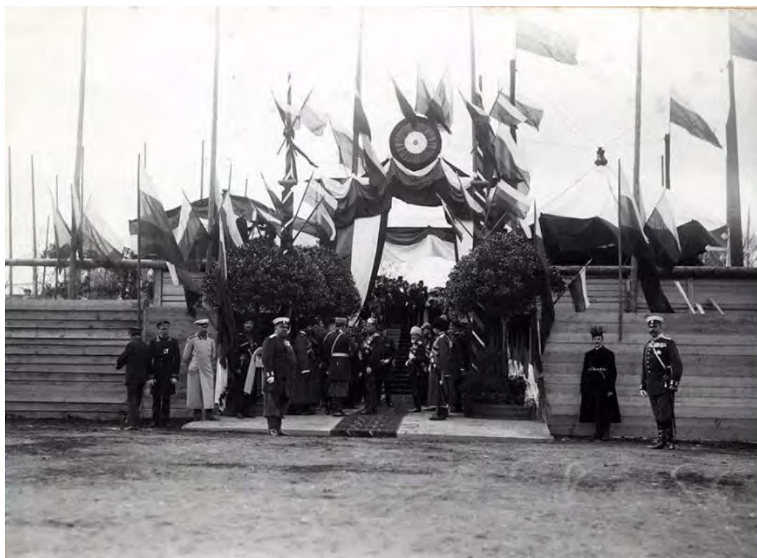
6. Царское Село. Закладка здания городского Реального училища. 1901г. Источник: www.pastvu.com
