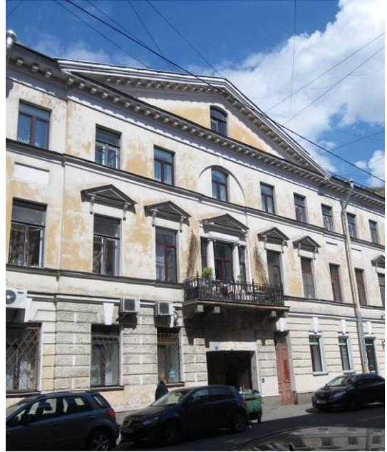
воротный проезд – местоположение (по 8-й световой оси), габариты, конфигурация (прямоугольный), оформление (прямоугольная горизонтальная ниша до верхней отметки оконных и дверного проемов, трехчастный замковый камень);
