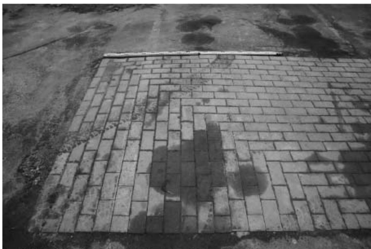
Рис. 36. СПб-2024. Центральный район, Малая Морская 5а. Шурф 2. До начала работ. Вид с востока
