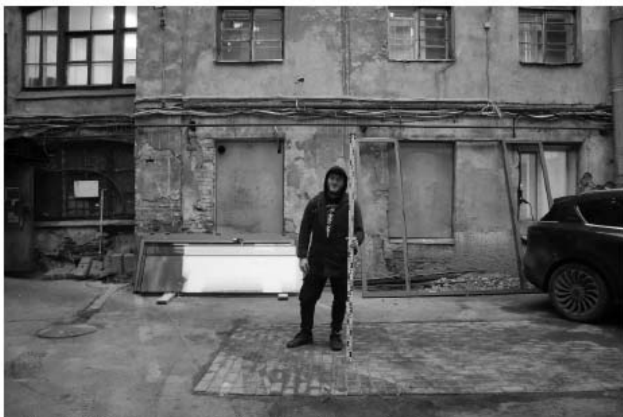
Рис. 20. СПб-2024. Центральный район, Малая Морская 5а. Общий вид участка обследования. Шурф 1. До начала работ. Вид с запада
