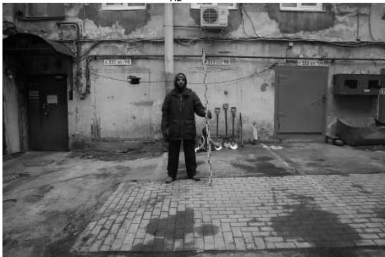
Рис. 35. СПб-2024. Центральный район, Малая Морская 5а. Общий вид участка обследования. Шурф 2. До начала работ. Вид с востока
