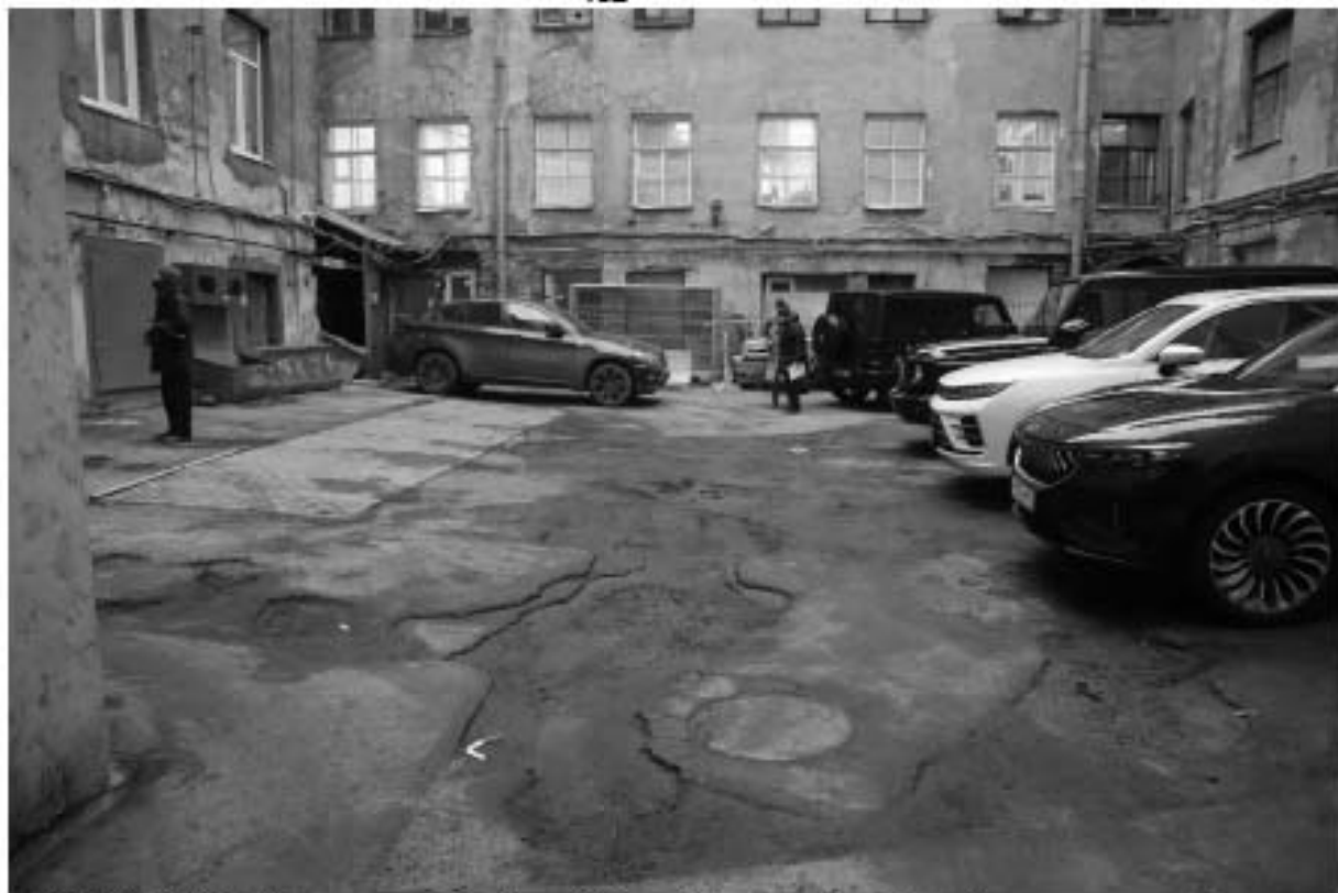
Рис. 17. СПб-2024. Центральный район, Малая Морская 5а. Общий вид участка обследования. Точка фотофиксации 1. Вид с юга
