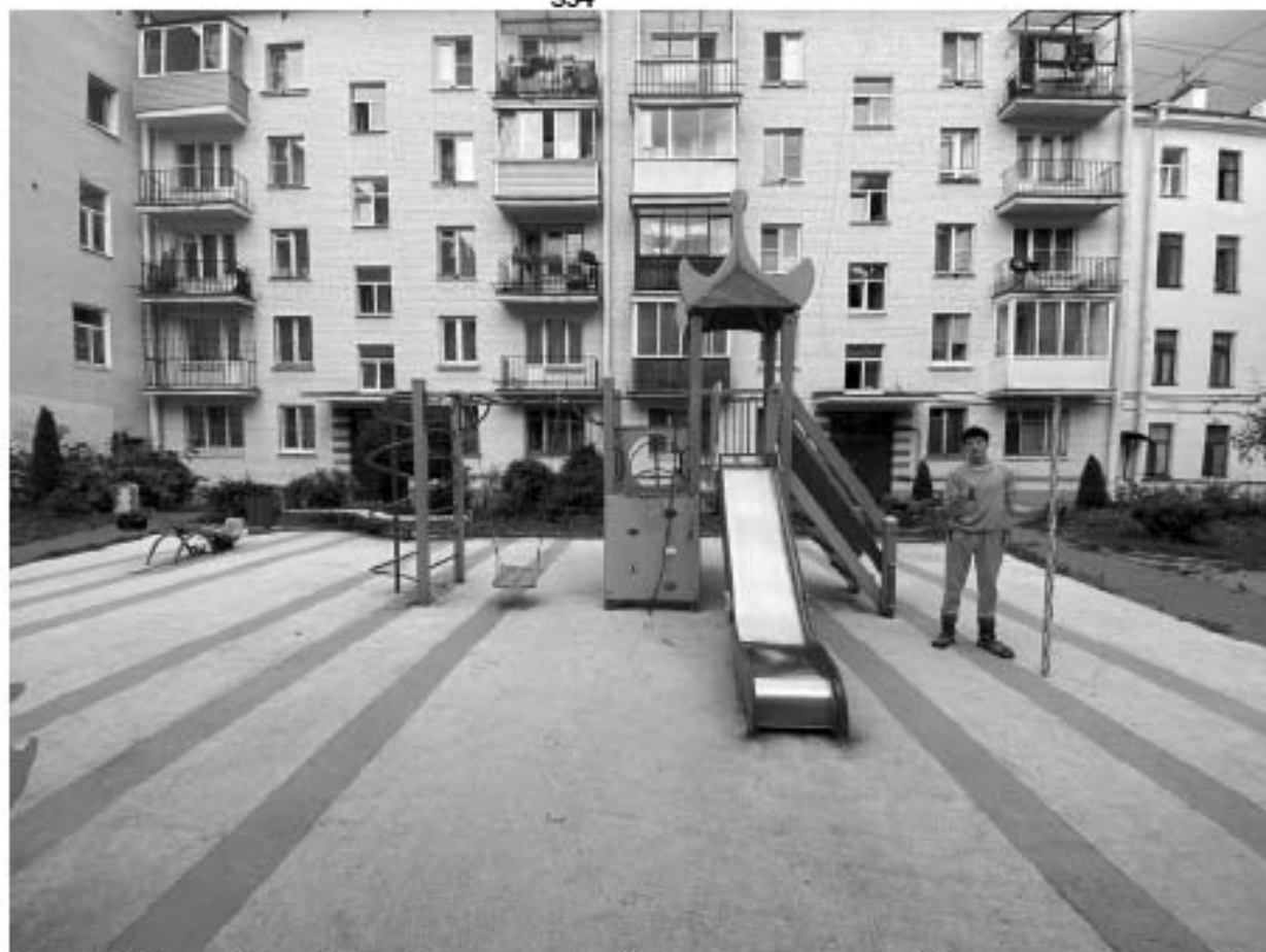
Рис. 243 Санкт-Петербург, Адмиралтейский р-н, по адресу: 7-я Красноармейская ул. 15. Общий вид участка обследования. Вид на север.
