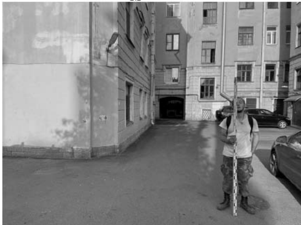
Рис. 56 Санкт-Петербург, Адмиралтейский р-н., Старопетергофский пр. 15. Общий вид на трассу обследования. Вид на восток.
