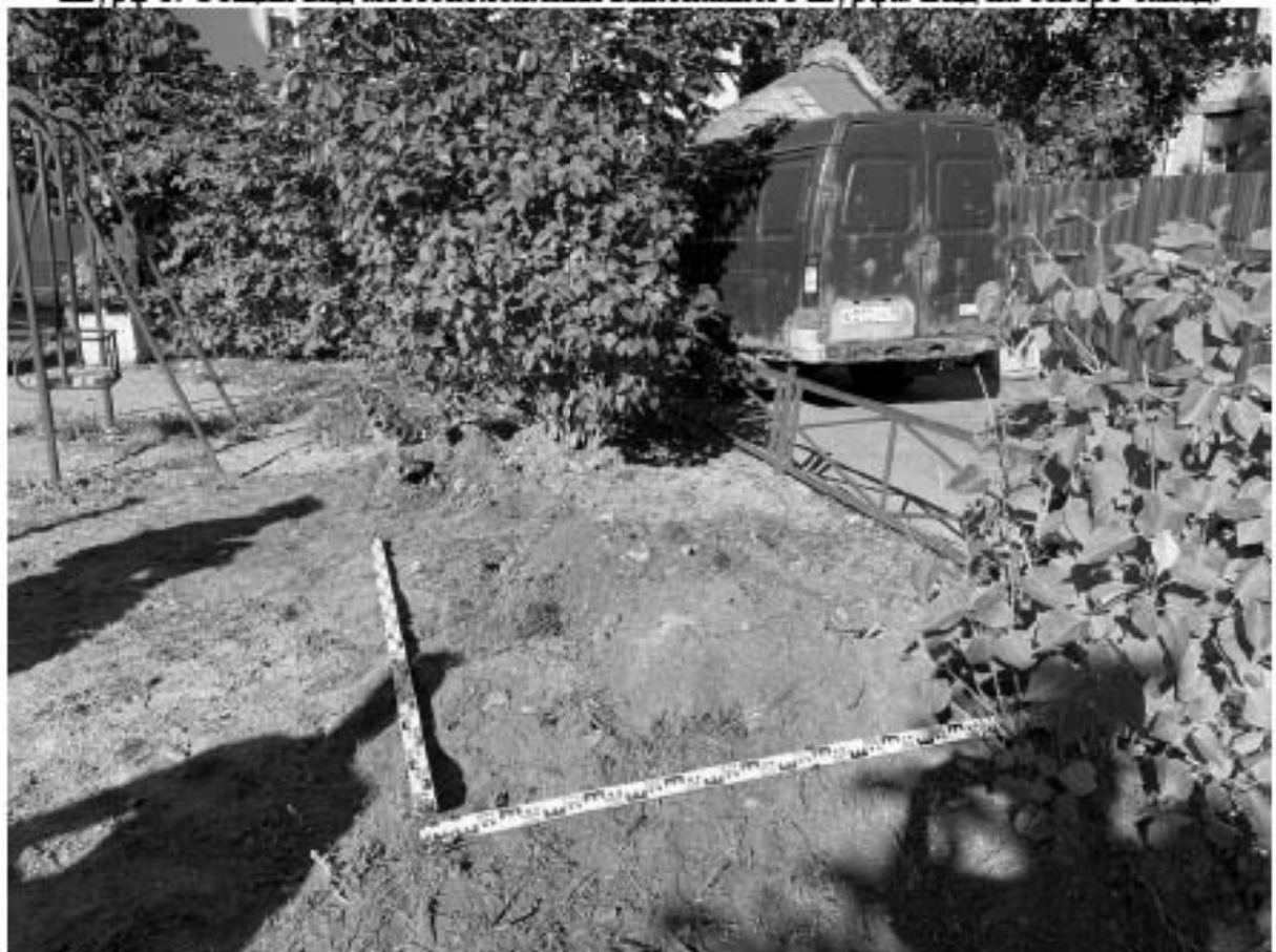
Рис. 34 Санкт-Петербург, Адмиралтейский р-н., трасса по адресу Старопетергофский пр. 52. Шурф 1. Общий вид шурфа после рекультивации. Вид на север.
