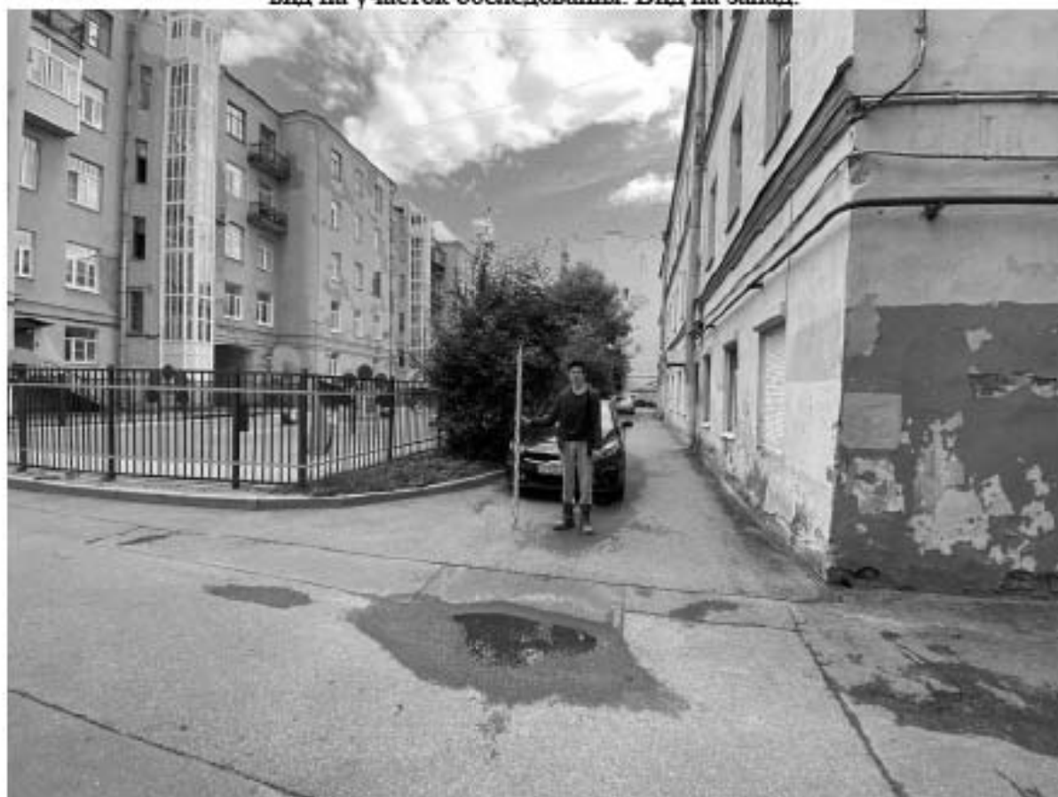
Рис. 292 Санкт-Петербург, Адмиралтейский р-н, трасса по адресу Можайская ул. 3-5. Общий вид на участок обследования. Вид на восток.
