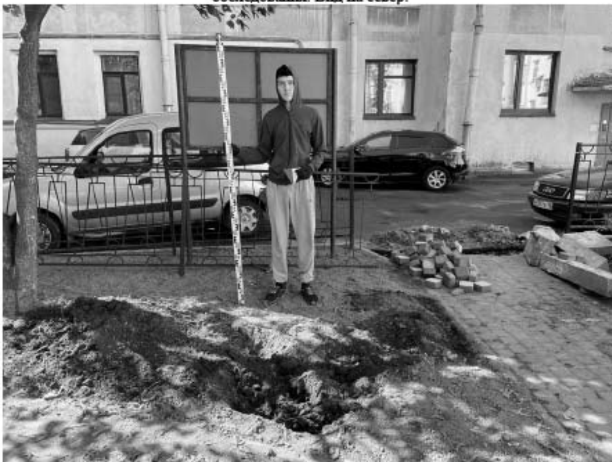
Рис. 100 Санкт-Петербург, Адмиралтейский р-н., Троицкий пр. 18. Шурф 7. Общий вид местоположения до начала работ. Вид на юг.
