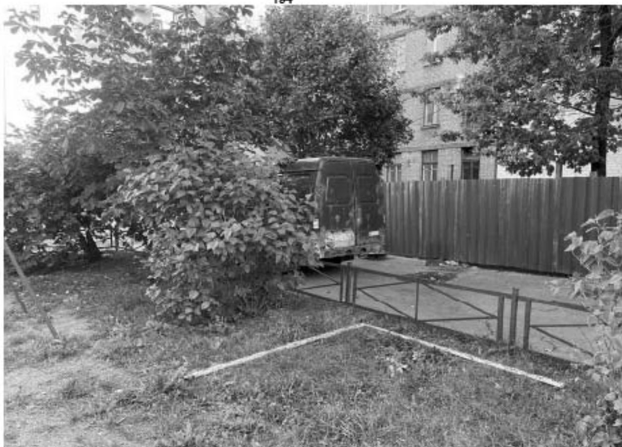
Рис. 27 Санкт-Петербург, Адмиралтейский р-н., трасса по адресу Старопетергофский пр. 52. Шурф 1. Общий вид до начала работ. Вид на север.
