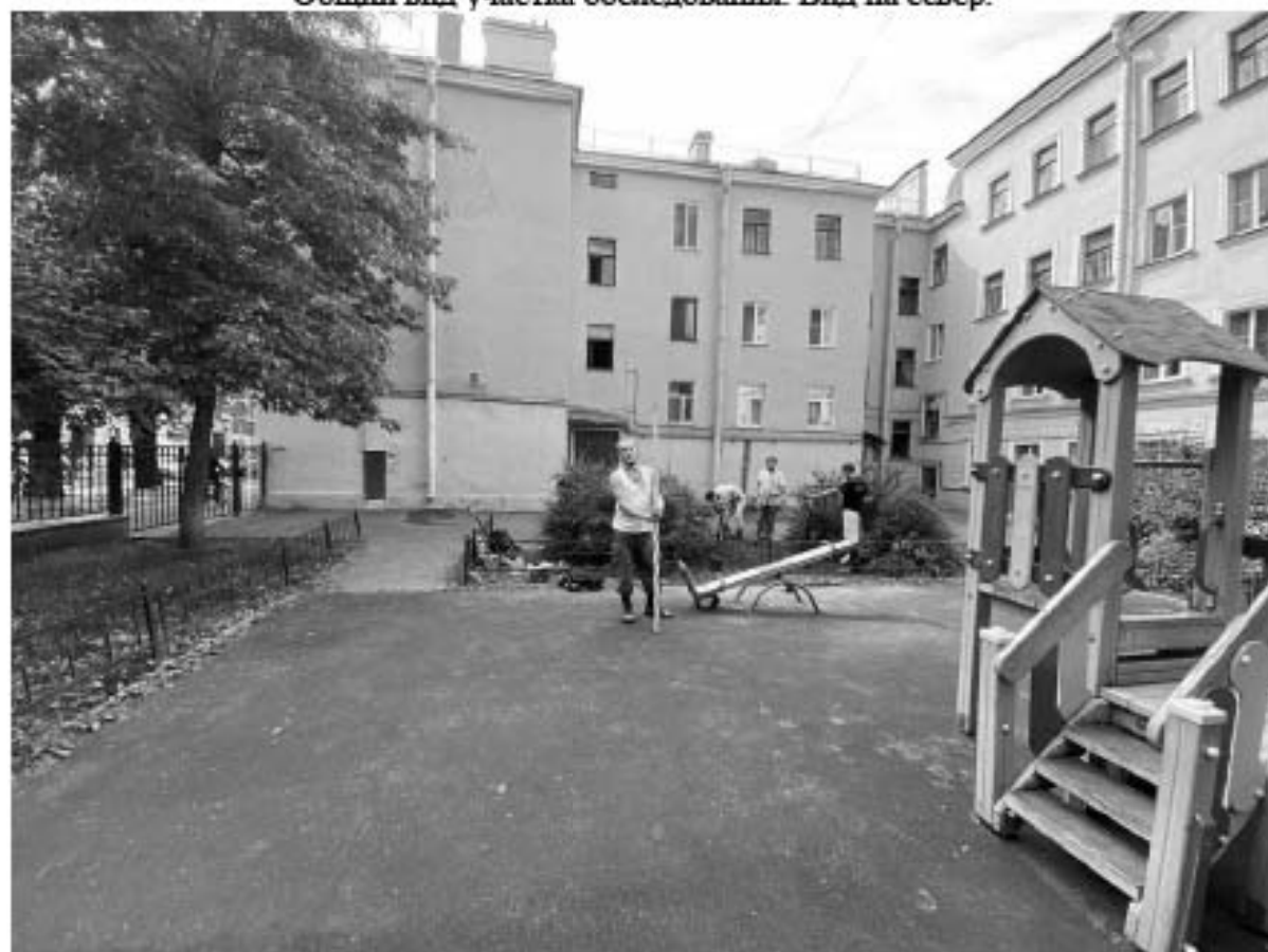
Рис. 255 Санкт-Петербург, Адмиралтейский р-н., трасса по адресу 7-я Красноармейская ул. 21. Общий вид участка обследования. Вид на запад.
