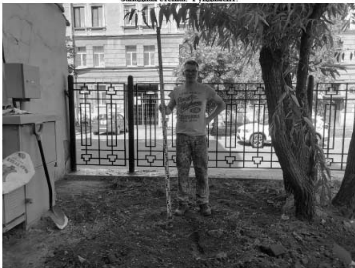
Рис. 241 Трасса обследования по адресу: 6-я Красноармейская ул. 20. Шурф 15. Общий вид после рекультивации. Вид на север.
