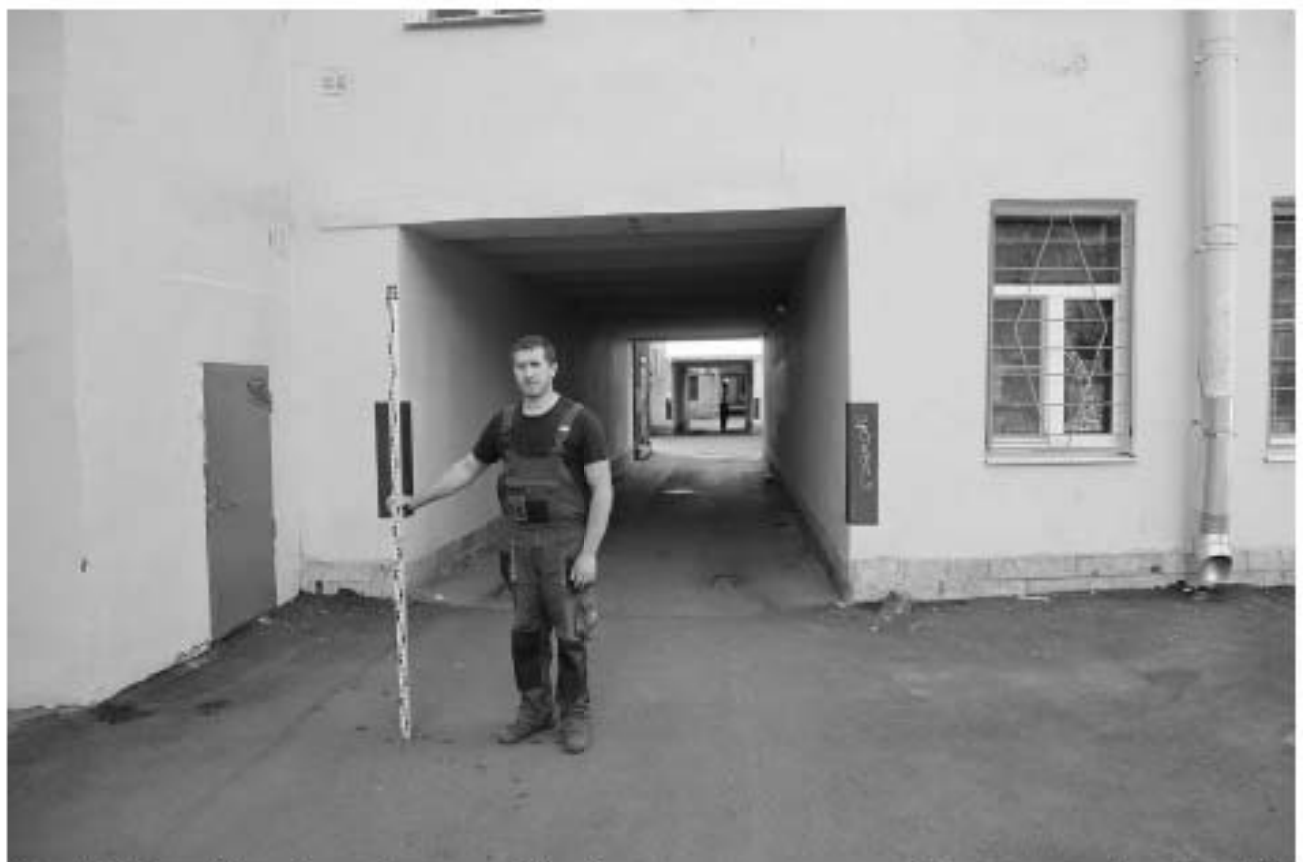
Рис. 26 Санкт-Петербург, Адмиралтейский р-н., трасса по адресу Старопетергофский пр. 52. Общий вид участка до начала работ. Вид на северо-запад.
