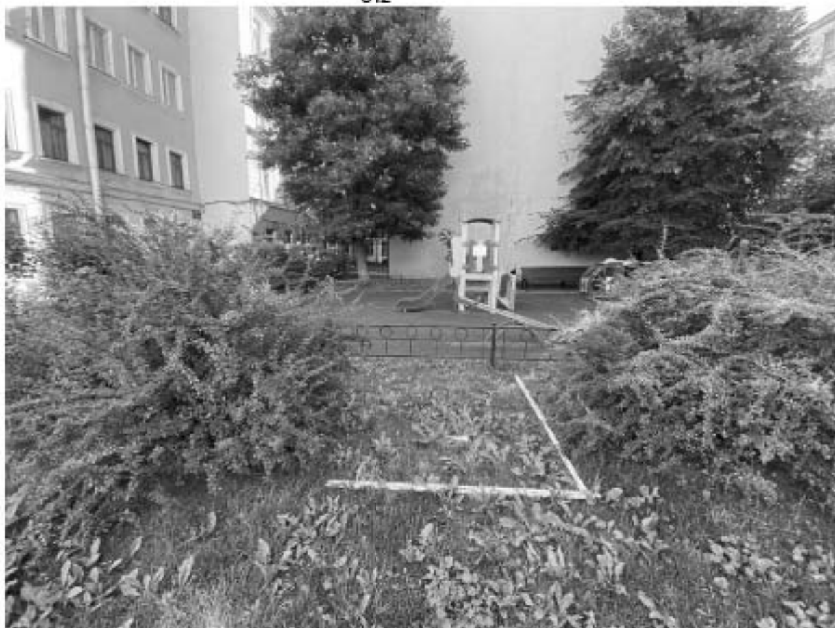
Рис. 258 Санкт-Петербург, Адмиралтейский р-н., трасса по адресу 7-я Красноармейская ул. 21. Шурф 17. Общий вид шурфа до начала работ. Вид на восток.
