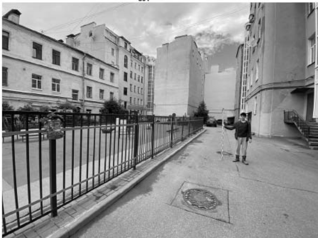
Рис. 291 Санкт-Петербург, Адмиралтейский р-н, трасса по адресу Можайская ул. 3-5. Общий вид на участок обследования. Вид на запад.
