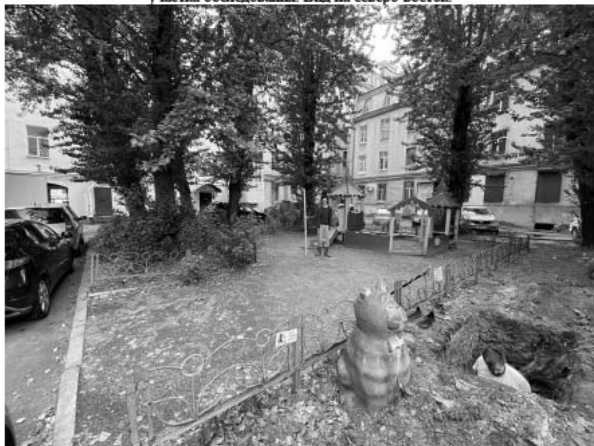
Рис. 311 Санкт-Петербург, Адмиралтейский р-н, трасса по адресу Рузовская ул. 5. Общий вид участка обследования. Вид на восток.
