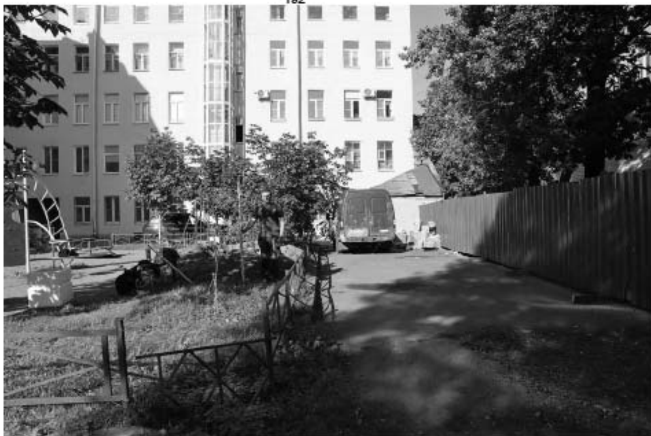
Рис. 23 Санкт-Петербург, Адмиралтейский р-н., трасса по адресу Старопетергофский пр. 52. Общий вид участка до начала работ. Вид на северо-запад.
