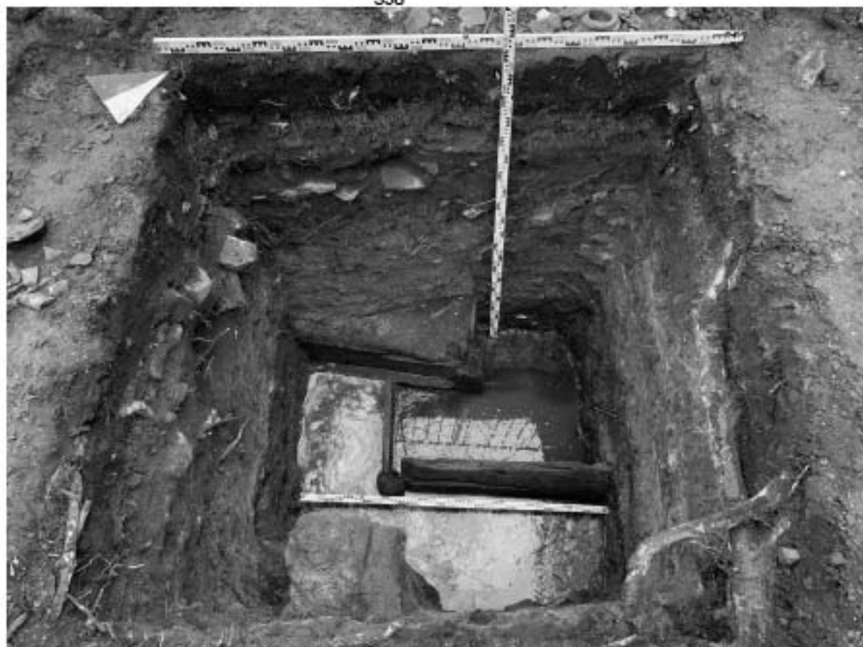
Рис. 280 Санкт-Петербург, Адмиралтейский р-н., трасса по адресу Московский пр. 18. Шурф 18. Фиксация канализационных коллекторов после выборки заполнения. Вид на северо-запад
