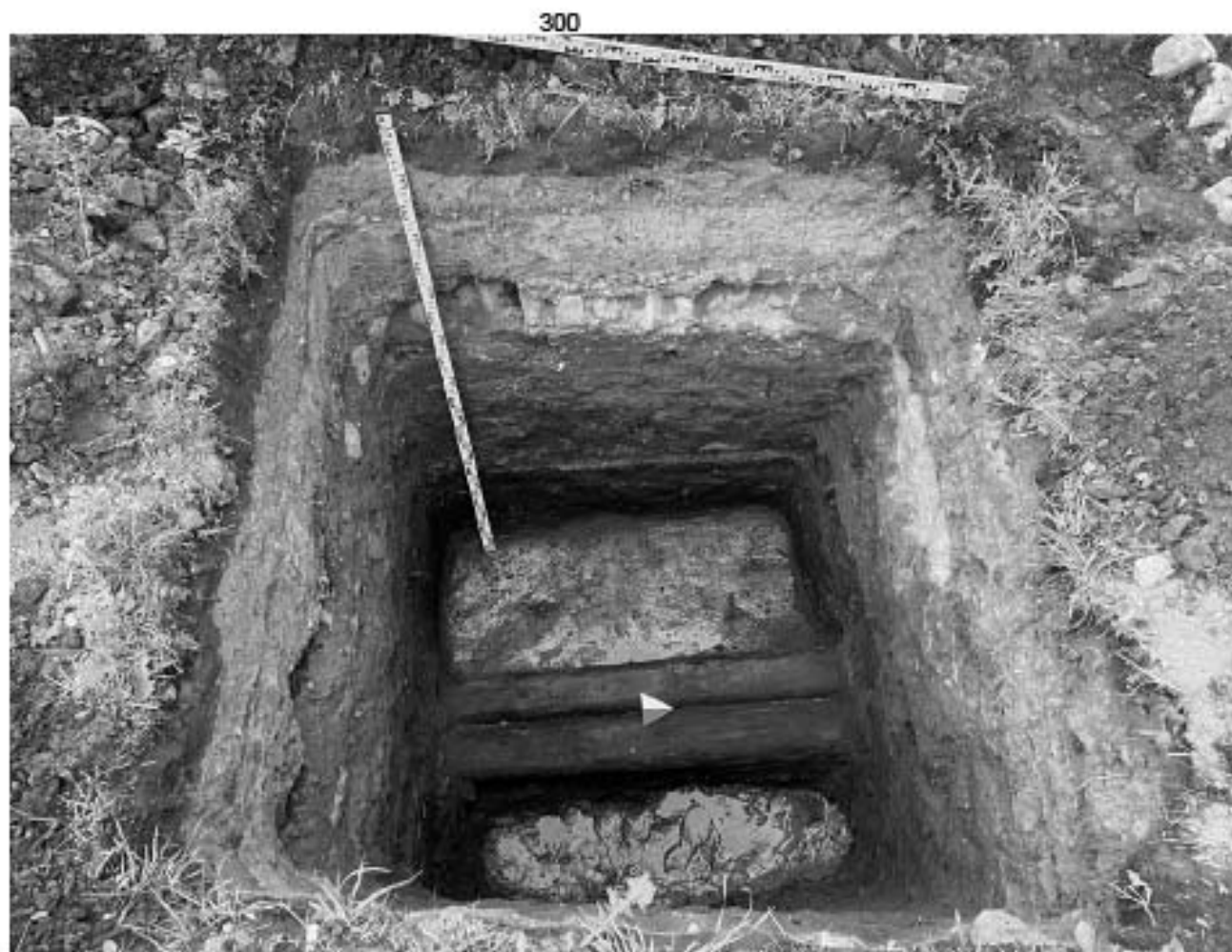
Рис. 198 Трасса обследования по адресу 3-я Красноармейская ул. 10. Шурф 13. Стратиграфия. Западная стенка.
