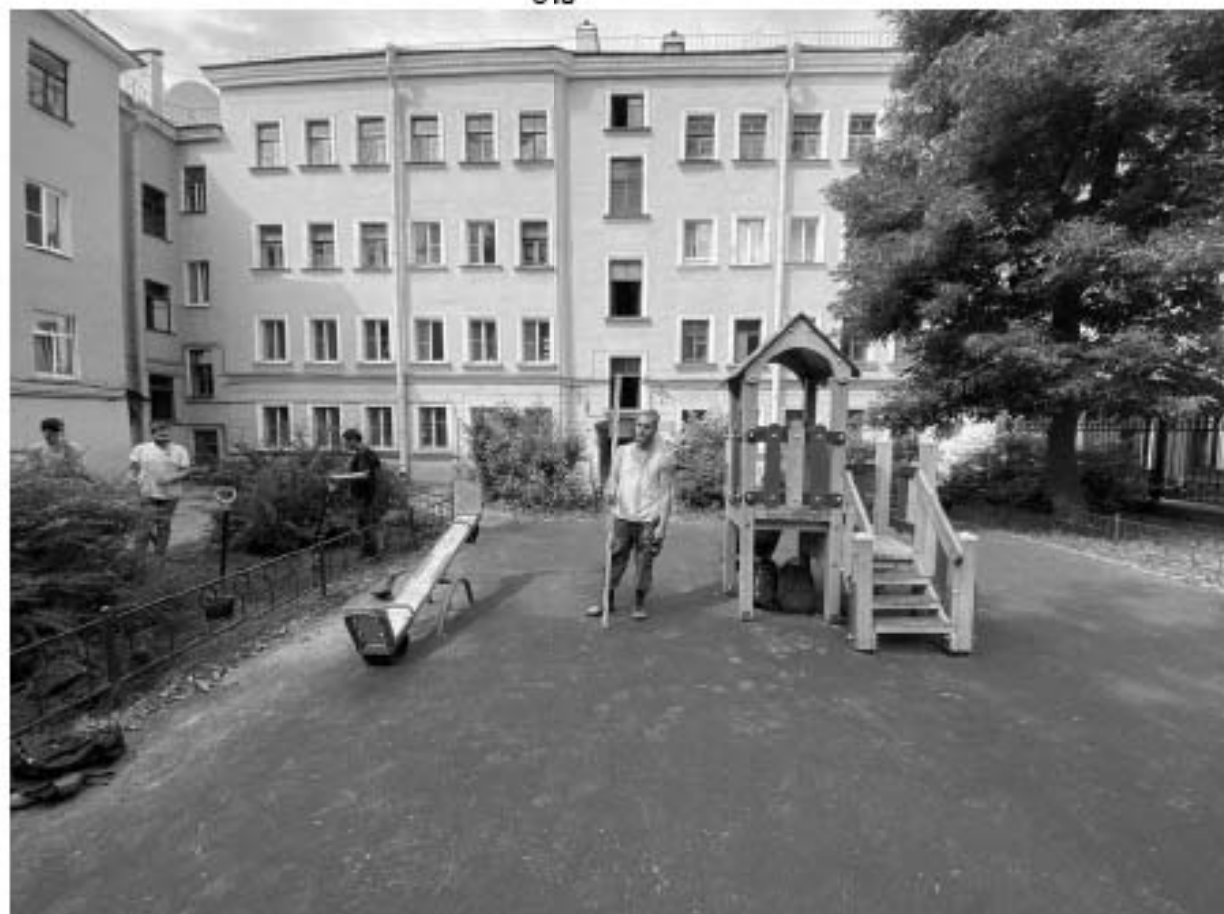
Рис. 254 Санкт-Петербург, Адмиралтейский р-н., трасса по адресу 7-я Красноармейская ул. 21. Общий вид участка обследования. Вид на север.
