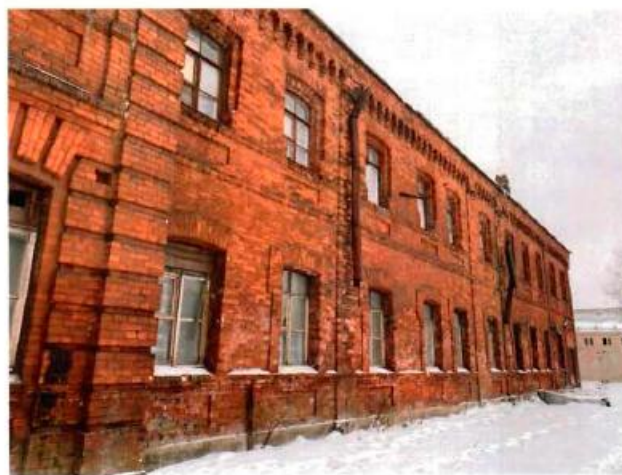
2. Общий вид на объект культурного наследия.
