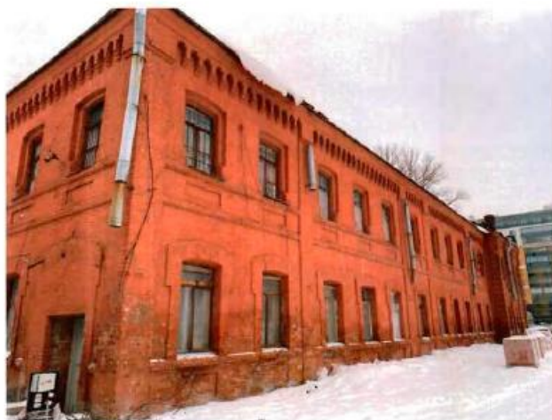
1. Общий вид на объект культурного наследия.
