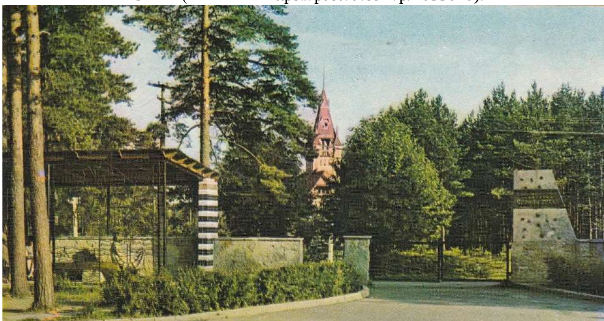
Илл. 56. Центральный въезд в санаторий «Черная речка». 1971 г. (источник: https://pastvu.com/p/1033015 ).
