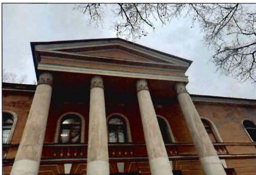
2. Фрагмент портика лицевого фасада объекта культурного наследия.
