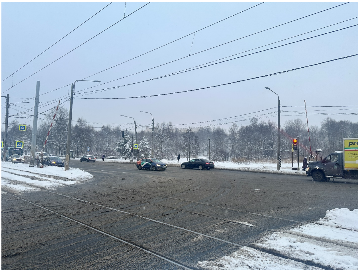
Фото 1. Общий вид на светофорный объект. Дата фотофиксации: 15.12.2024г.
