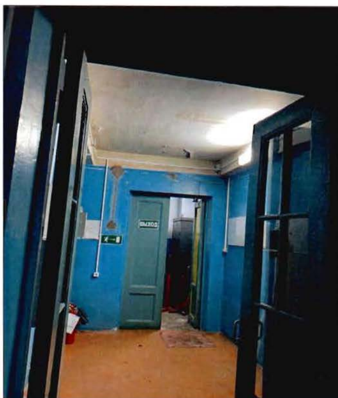
8. Помещения объекта культурного наследия.
