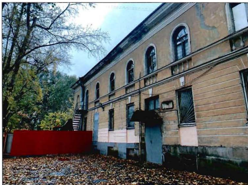
4. Южный фасад объекта культурного наследия.
