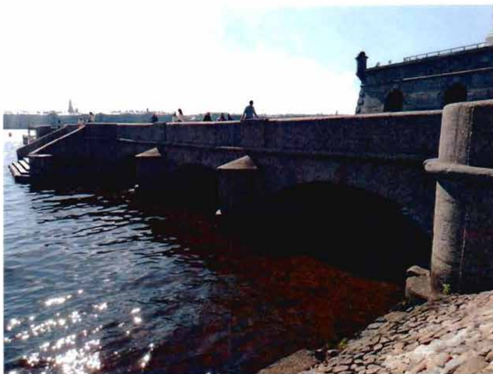
2. Трехарочный мост. Вид с севера.
