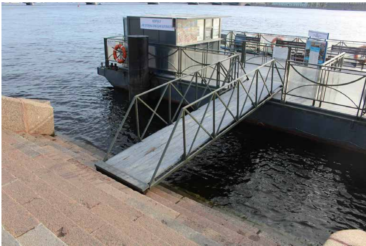
Фото 5. Вид на юго-восточный лестничный спуск объекта культурного наследия федерального значения «Пристань Невская (Комендантская)» и пришвартованный понтон.
