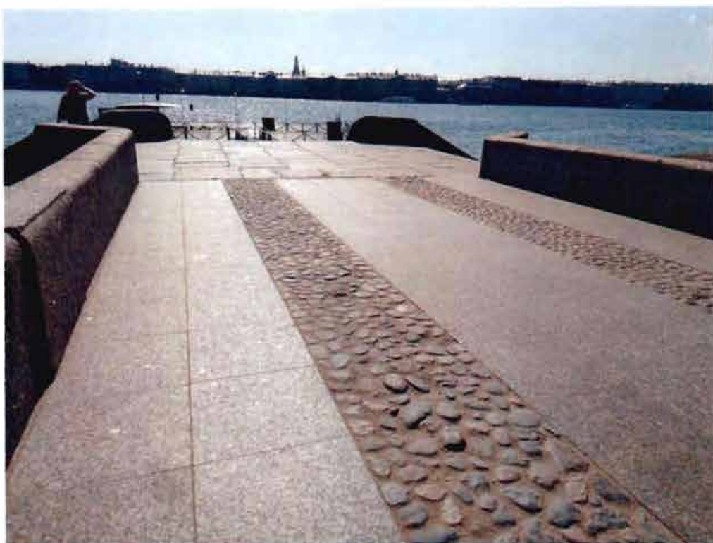
4. Мощение мостовой и площадки.
