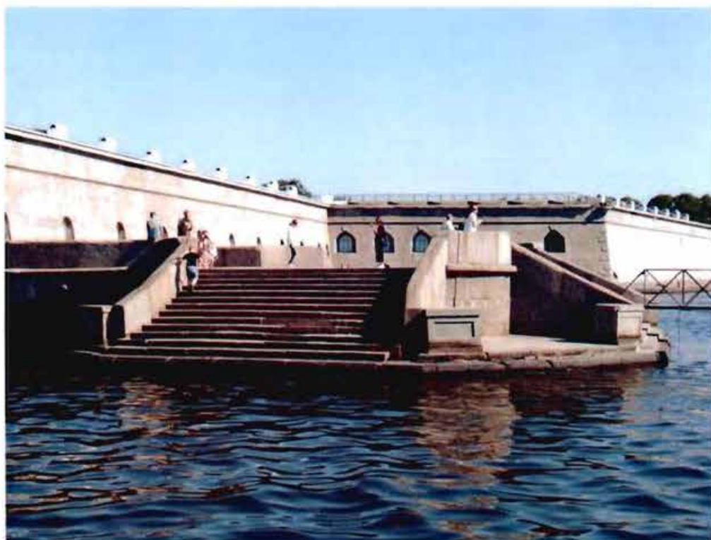
3. Площадка с лестничными спусками.
