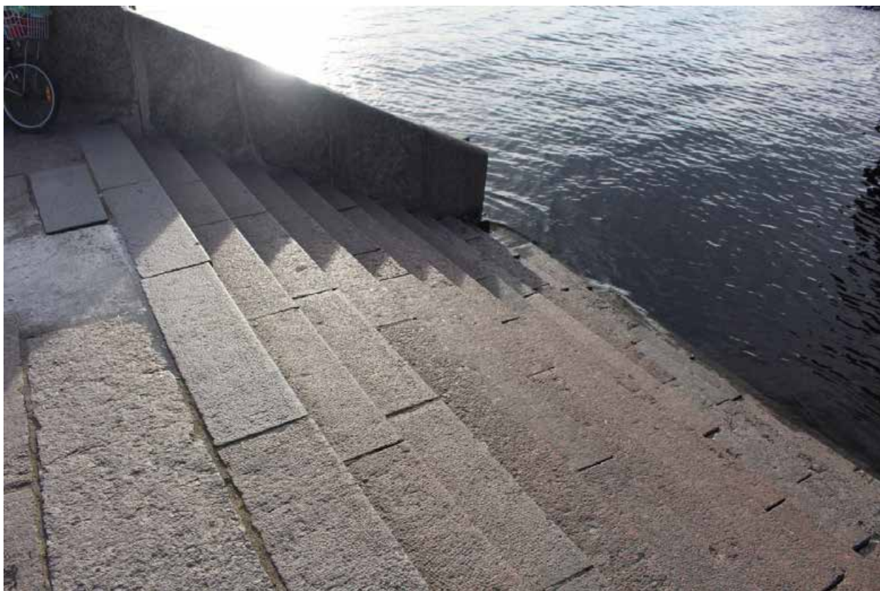
Фото 7. Вид на юго-западный лестничный спуск объекта культурного наследия федерального значения «Пристань Невская (Комендантская)».
