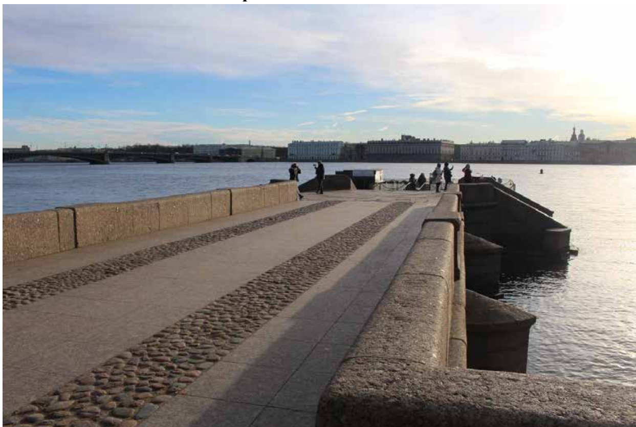
Фото 1. Вид на трехарочный мост объекта культурного наследия федерального значения «Пристань Невская (Комендантская)» с северо-запада.
