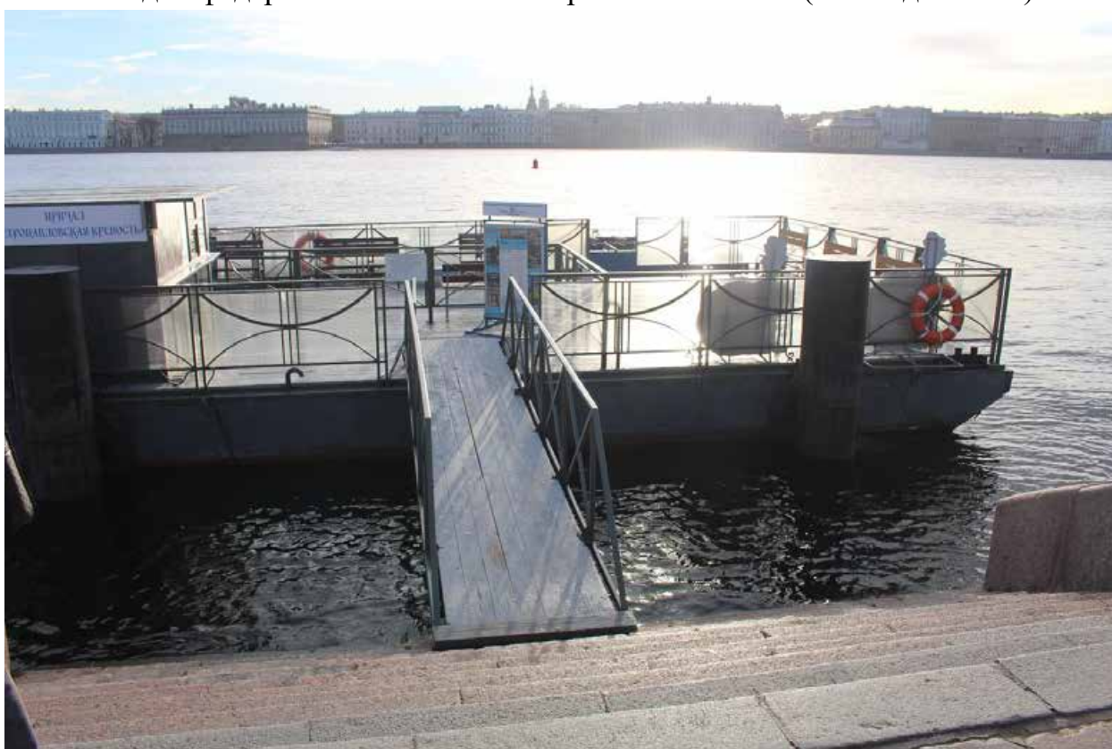
Фото 4. Вид на юго-восточный лестничный спуск объекта культурного наследия федерального значения «Пристань Невская (Комендантская)» и пришвартованный понтон.
