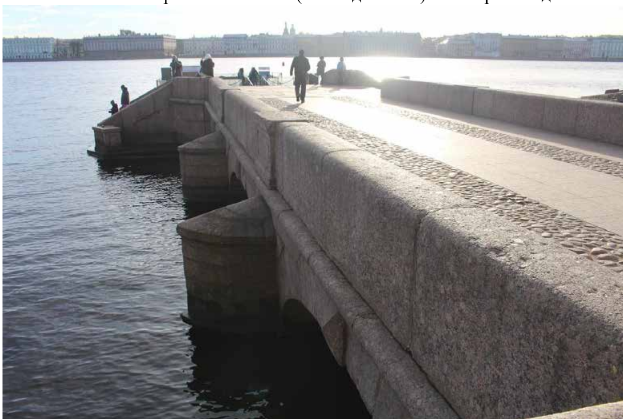
Фото 2. Вид на северо-восточный фасад трехарочного моста объекта культурного наследия федерального значения «Пристань Невская (Комендантская)».
