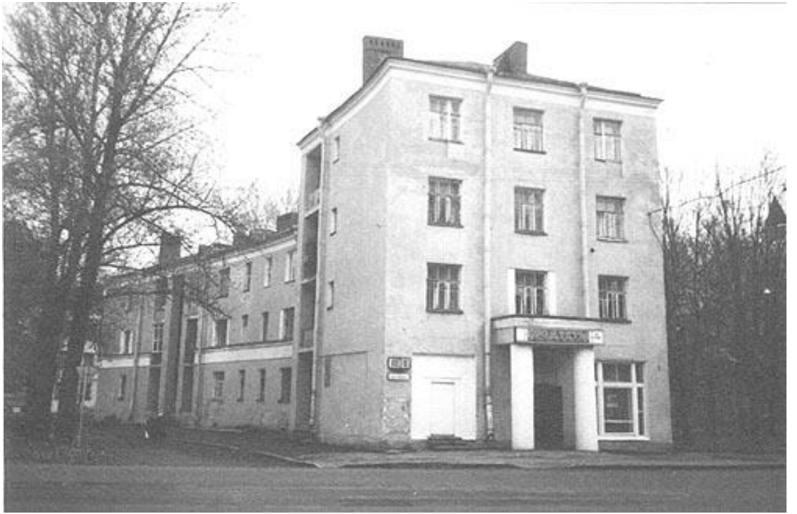
10. Здание, являющееся частью выявленного объекта культурного наследия «Жилмассив для рабочих-текстильщиков (20 домов)» (Бабушкина ул., д. 18, лит. П). Фото 1999 (11).
