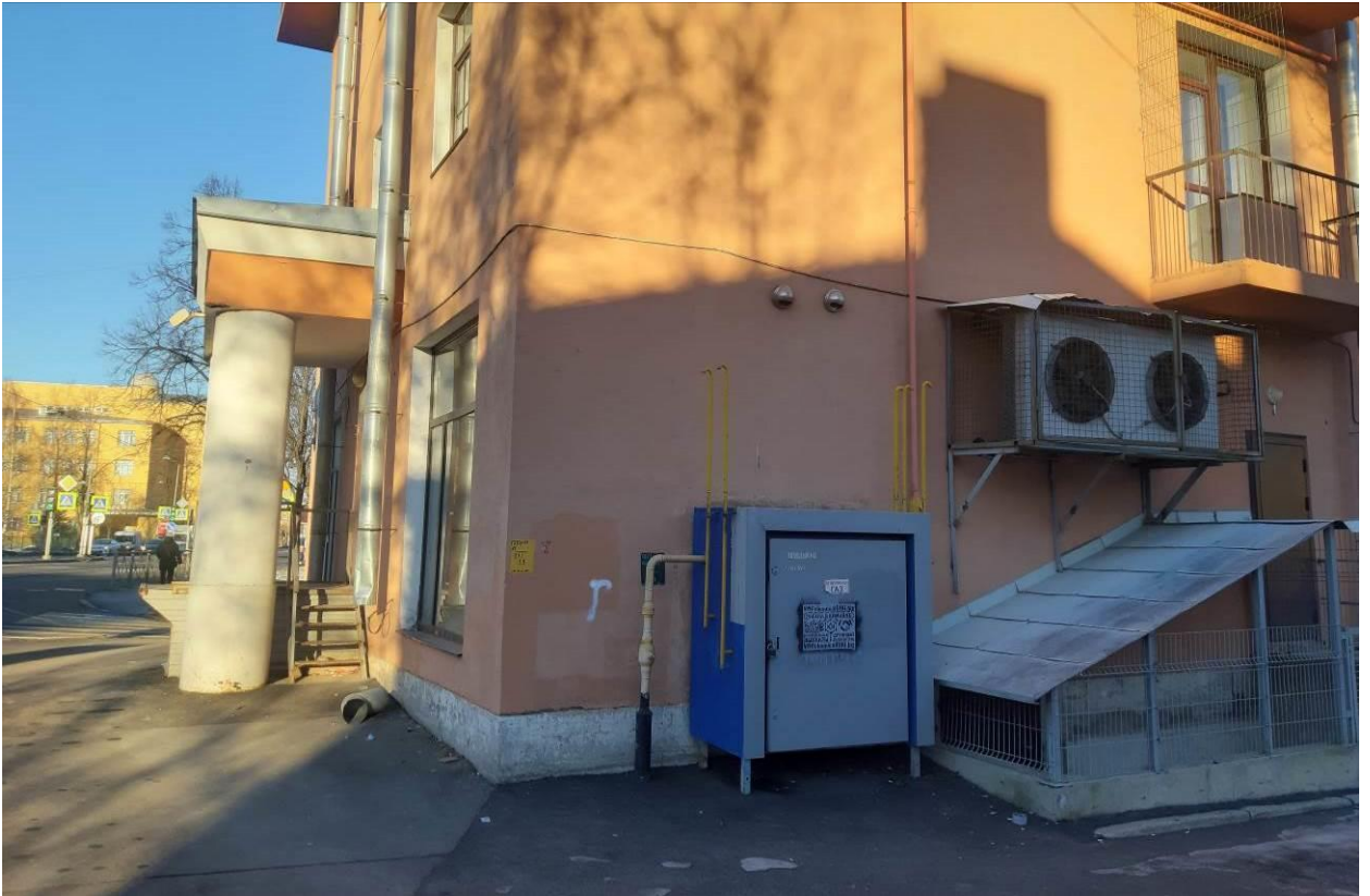
9. Здание, являющееся частью выявленного объекта культурного наследия «Жилмассив для рабочих-текстильщиков (20 домов)» (Бабушкина ул., д. 18, лит. П). Дворовый фасад (фрагмент). Фото мест установки оборудования и кабельных трасс. Штиглиц М.С. 10.01.2025.
