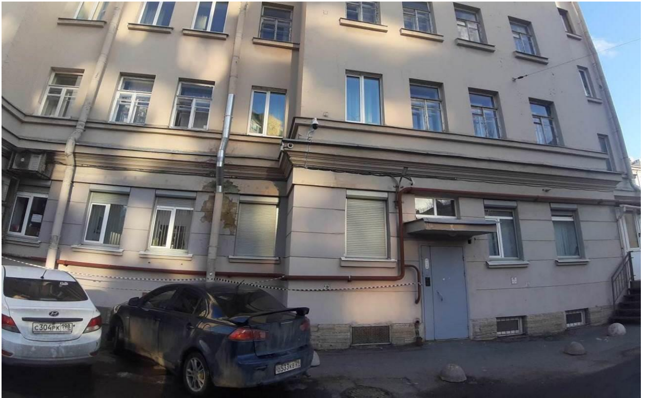
3. «Жилой дом Северо-Западного речного пароходства» (Обуховской Обороны пр., д. 19, лит. А). Дворовый фасад (фрагмент). Фото мест установки оборудования и кабельных трасс. Штиглиц М.С. 10.01.2025.
