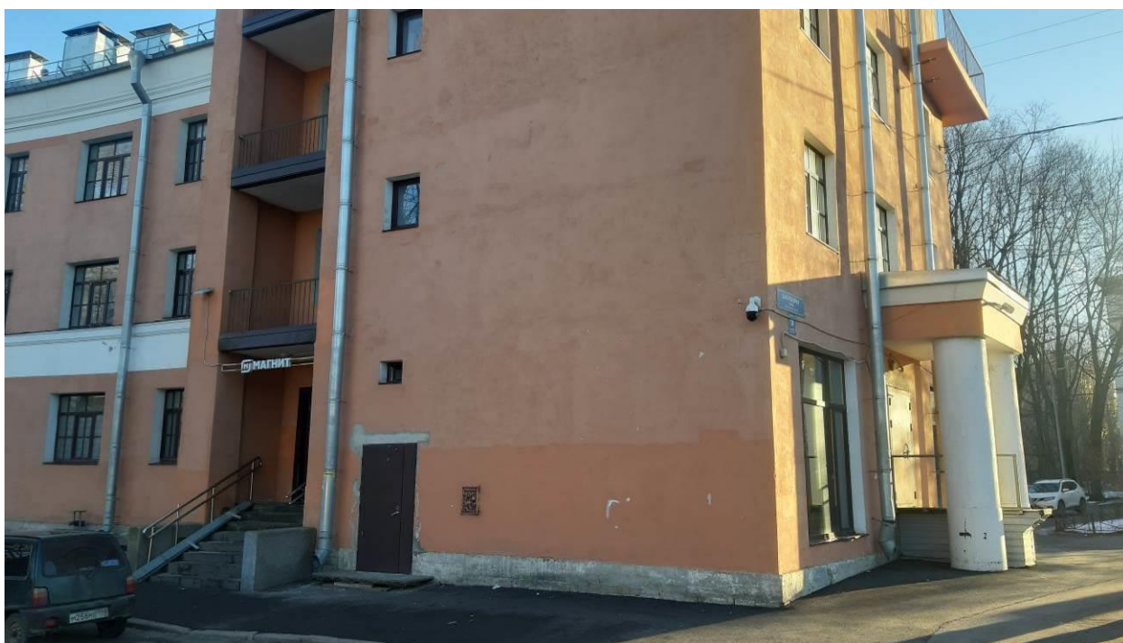
8. Здание, являющееся частью выявленного объекта культурного наследия «Жилмассив для рабочих-текстильчиков (20 домов)» (Бабушкина ул., д. 18, лит. П). Лицево фасад (фрагмент). Фото мест установки оборудования и кабельных трасс. Штиглиц М.С. 10.01.2025.
