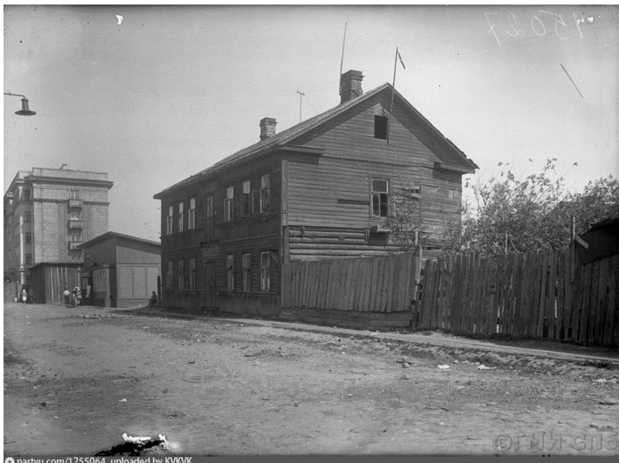
4. «Жилой дом Северо-Западного речного пароходства» (Обуховской Обороны пр., д. 19, лит. А). 1938-1939 гг. Стеклянная ул., д. № 18 (на заднем плане жилой дом Госречпароходства). (Госкаталог, «Государственный музей истории Санкт-Петербурга»).
