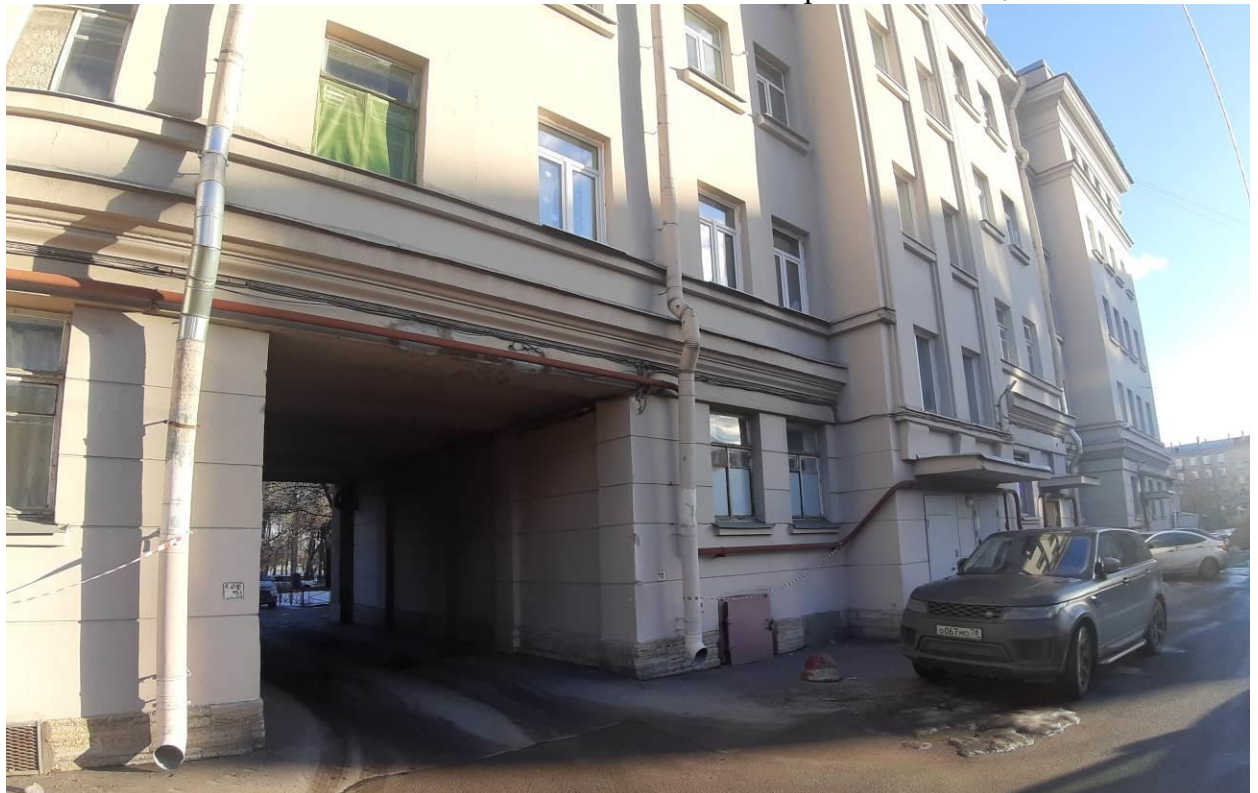
4. «Жилой дом Северо-Западного речного пароходства» (Обуховской Обороны пр., д. 19, лит. А). Арочный проезд. Фото мест установки оборудования и кабельных трасс. Штиглиц М.С. 10.01.2025.
