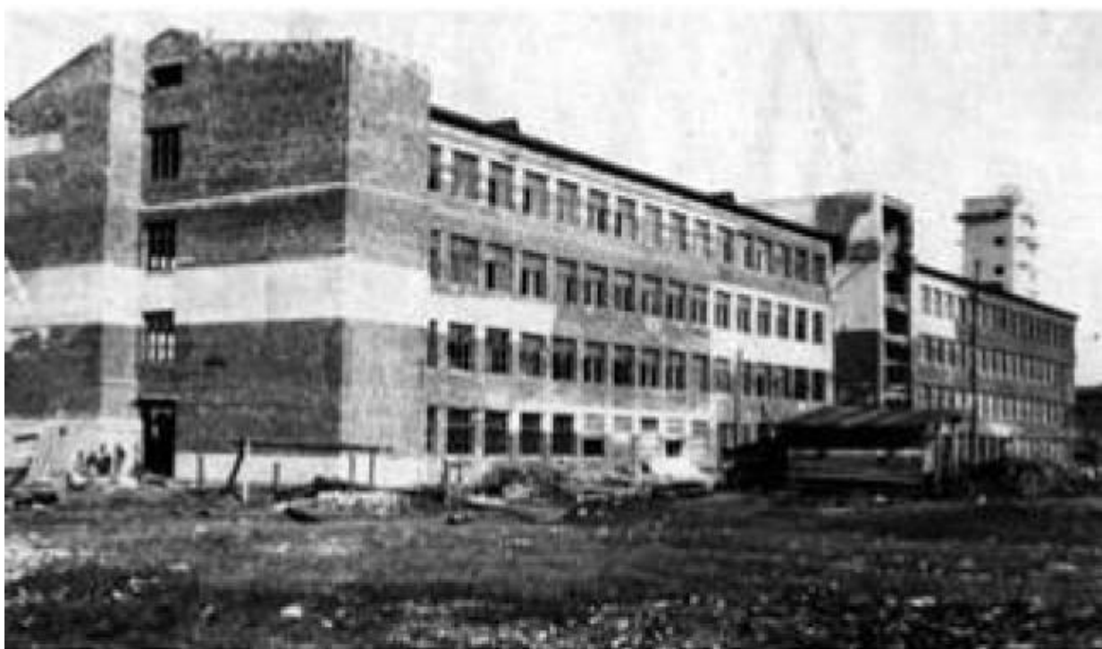
60. Учебный корпус в процессе строительства. 1934 г.
