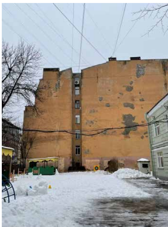
Фото 2. Фрагмент лицевого фасада объекта культурного наследия регионального значения «Доходный дом А.Г. Покровской (Я.И. Шика)»
