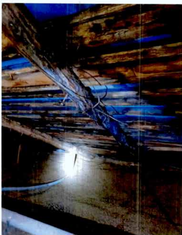
31. Чердачное пространство объекта культурного наследия (фото от 25.04.2024).
