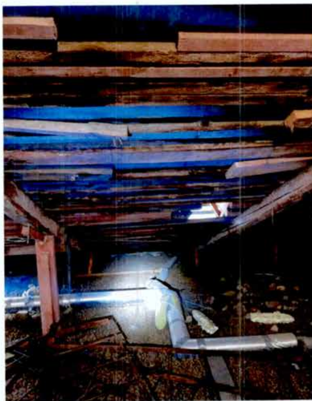
29. Чердачное пространство объекта культурного наследия (фото от 25.04.2024).
