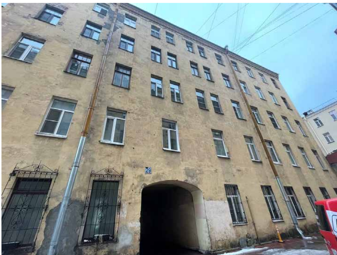
Фото 8. Фрагмент дворового фасада объекта культурного наследия регионального значения «Доходный дом А.Г. Покровской (Я.И. Шика)»
