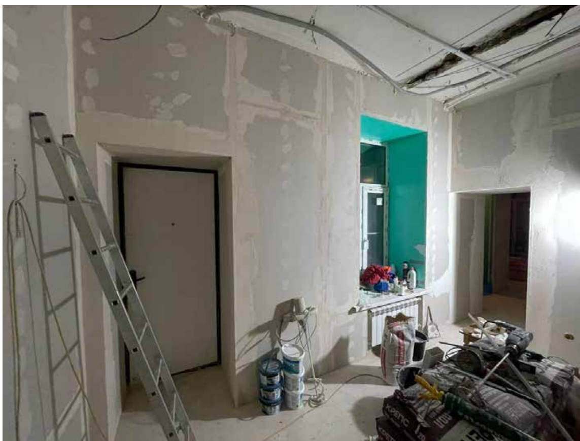
Фото 28. Интерьер квартиры № 4 объекта культурного наследия регионального значения «Доходный дом А.Г. Покровской (Я.И. Шика)»
