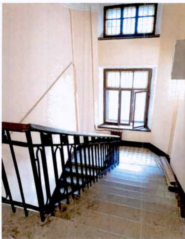
21. Интерьер объекта культурного наследия. Помещение № 3ЛК (фото от 25.04.2024).
