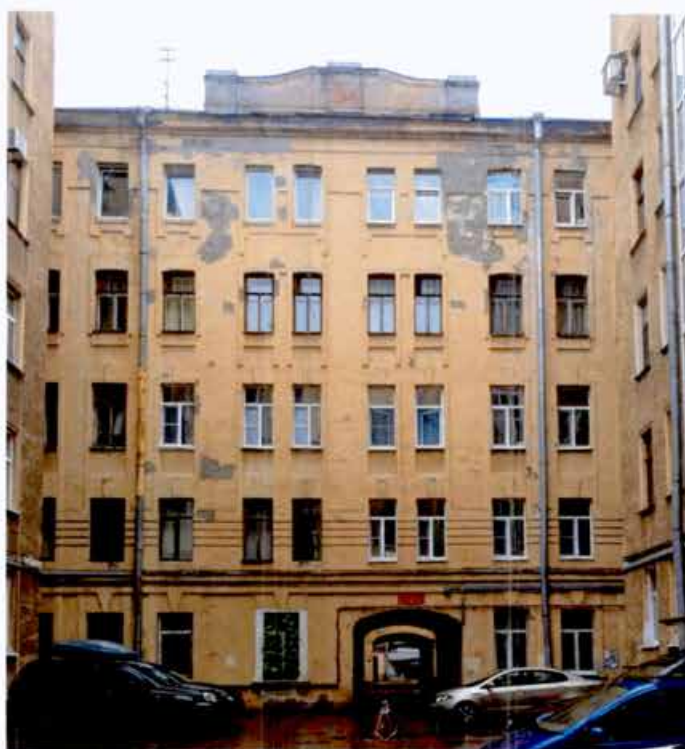
3. Общий вид юго-западного дворового фасада объекта культурного наследия (фото от 12.07.2024).
