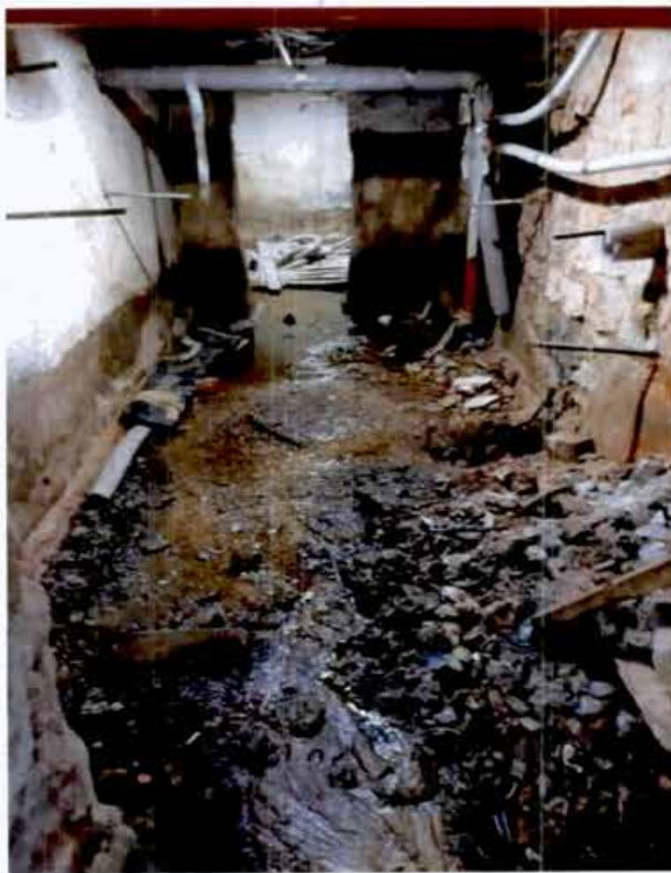
16. Интерьер объекта культурного наследия. Подвальное пространство (фото от 12.07.2024).
