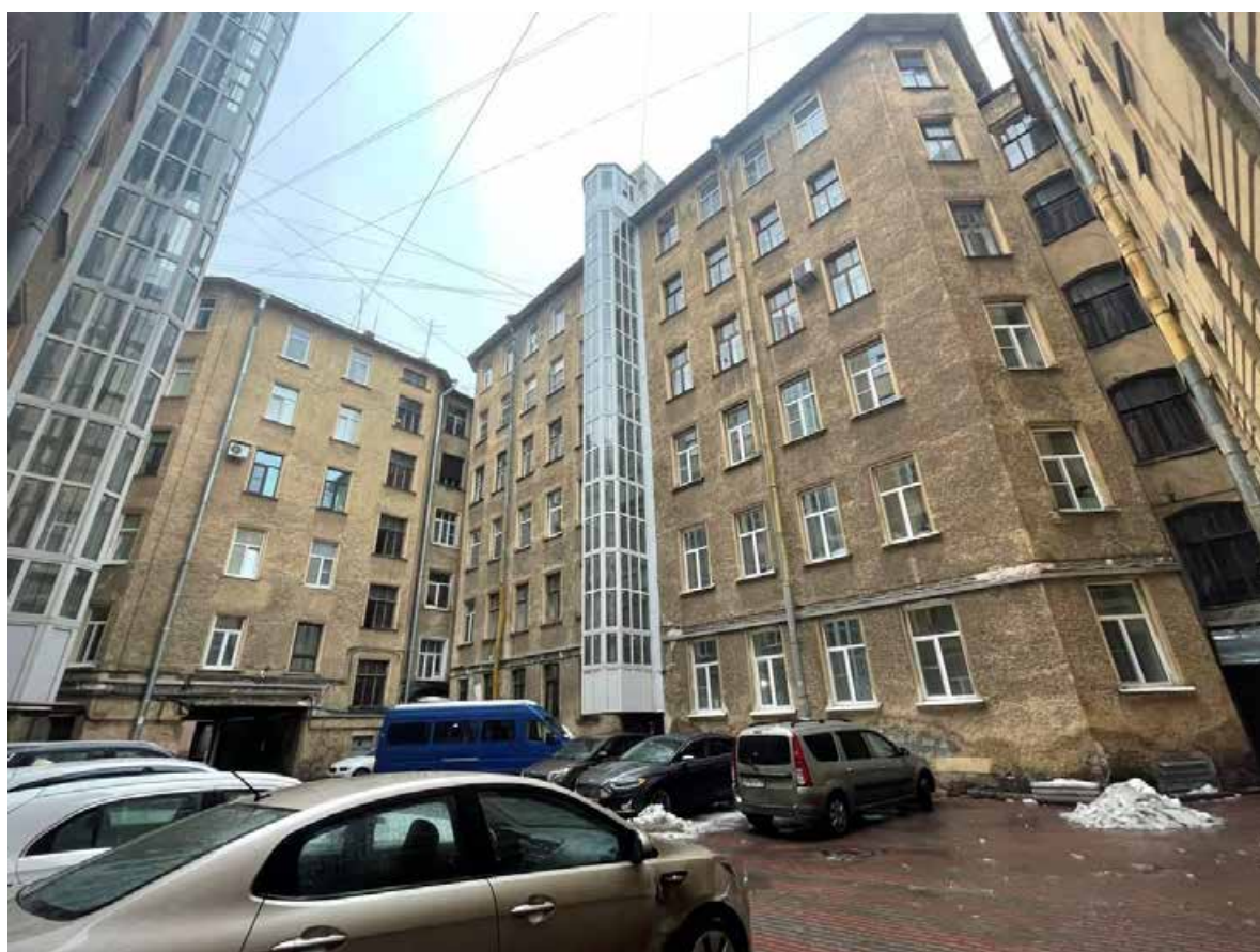
Фото 6. Фрагмент дворового фасада объекта культурного наследия регионального значения «Доходный дом А.Г. Покровской (Я.И. Шика)»
