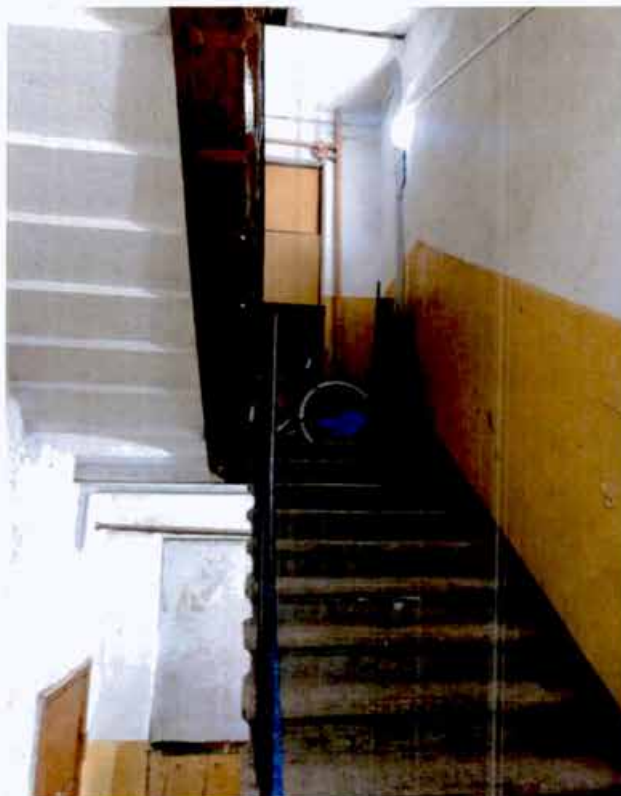
18. Интерьер объекта культурного наследия. Помещение № 5ЛК (фото от 25.04.2024).
