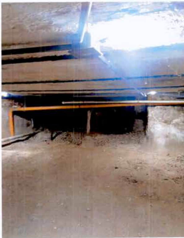
15. Интерьер объекта культурного наследия. Подвальное пространство (фото от 25.04.2024).
