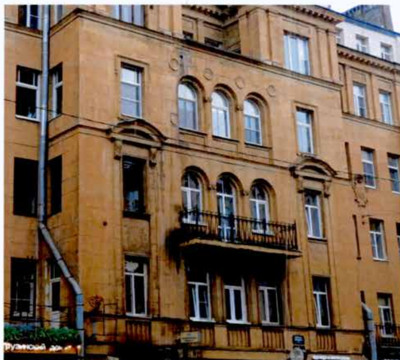
9. Фрагмент лицевого фасада объекта культурного наследия (фото от 12.07.2024).
