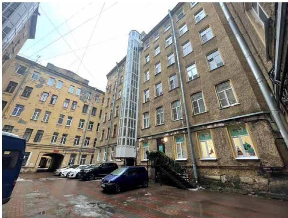
Фото 3. Фрагмент дворового фасада объекта культурного наследия регионального значения «Доходный дом А.Г. Покровской (Я.И. Шика)»
