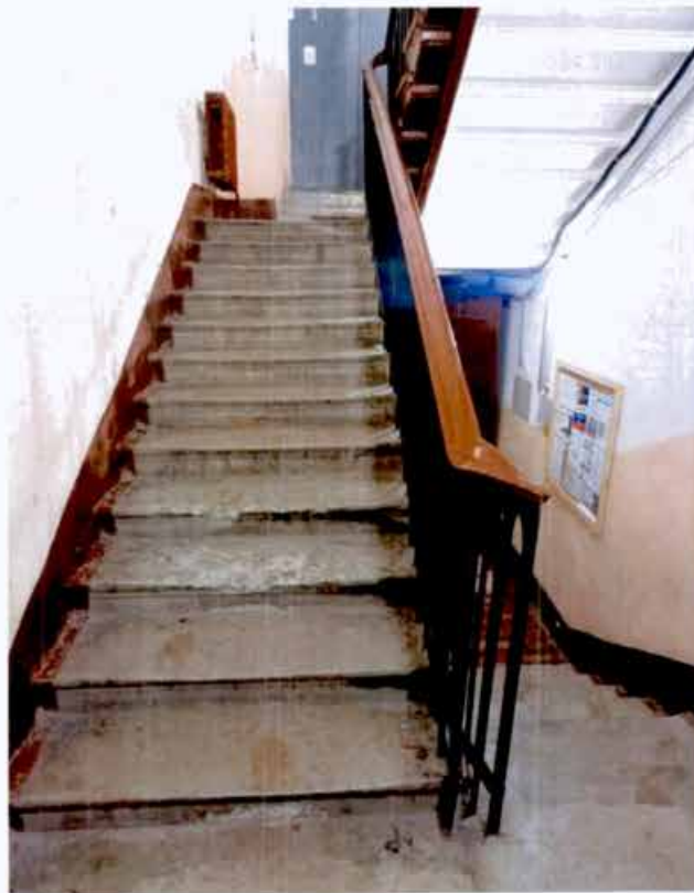
19. Интерьер объекта культурного наследия. Помещение № 4ЛК (фото от 25.04.2024).
