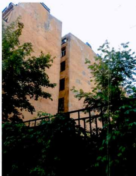
7. Общий вид юго-восточного фасада юго-восточного флигеля объекта культурного наследия (фото от 12.07.2024).
