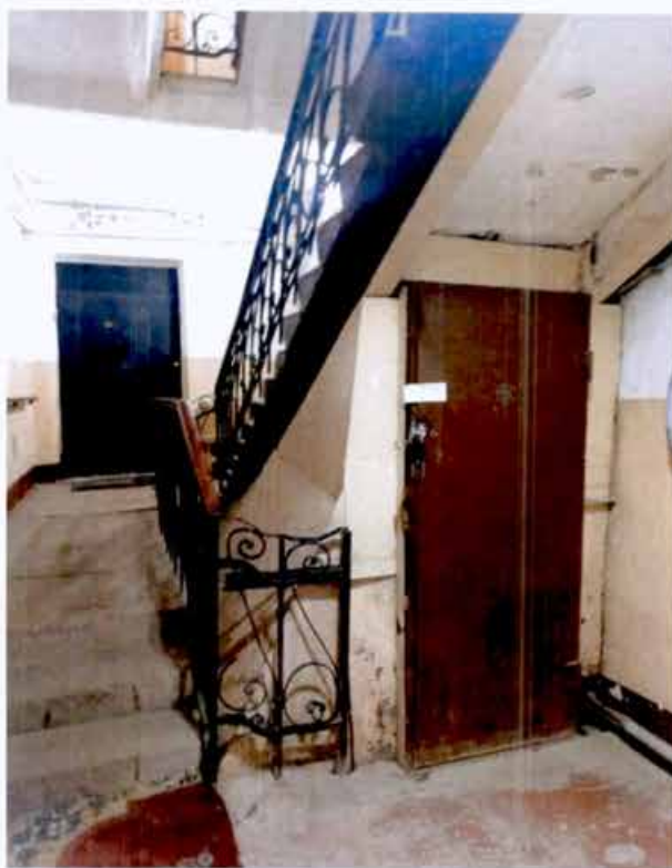
23. Интерьер объекта культурного наследия. Помещение № 6ЛК (фото от 25.04.2024).
