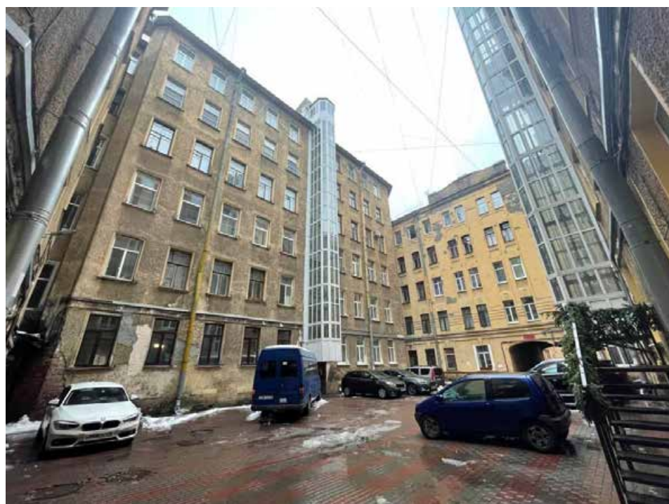
Фото 4. Фрагмент дворового фасада объекта культурного наследия регионального значения «Доходный дом А.Г. Покровской (Я.И. Шика)»
