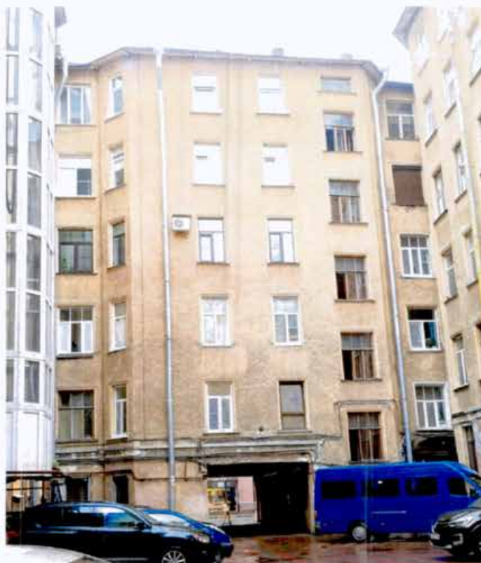
2. Общий вид северо-восточного дворового фасада объекта культурного наследия (фото от 12.07.2024).
