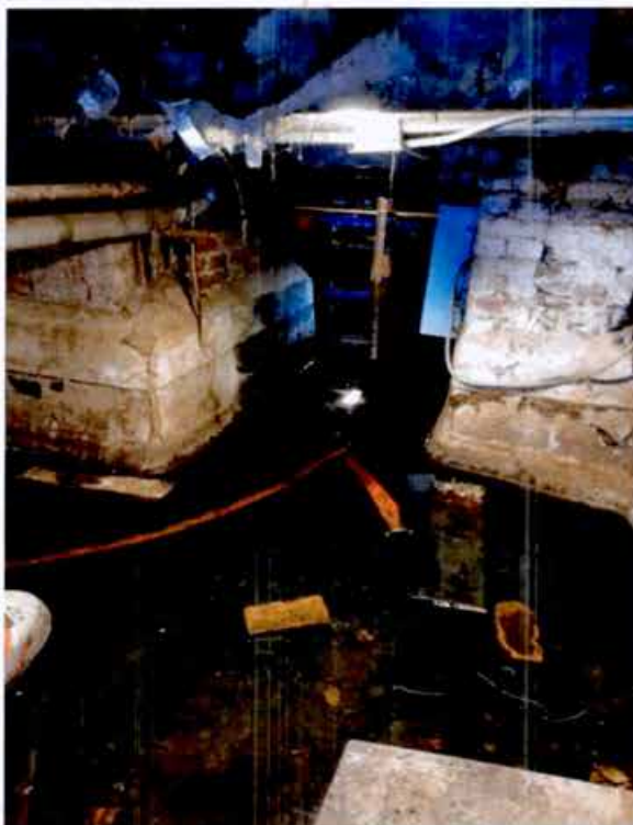
14. Интерьер объекта культурного наследия. Подвальное пространство (фото от 25.04.2024).
