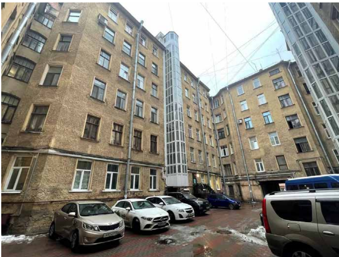
Фото 5. Фрагмент дворового фасада объекта культурного наследия регионального значения «Доходный дом А.Г. Покровской (Я.И. Шика)»
