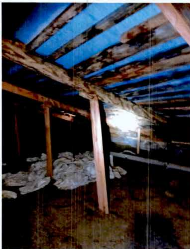
30. Чердачное пространство объекта культурного наследия (фото от 25.04.2024).
