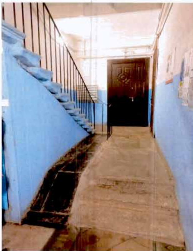
22. Интерьер объекта культурного наследия. Помещение № 7ЛК (фото от 25.04.2024).
