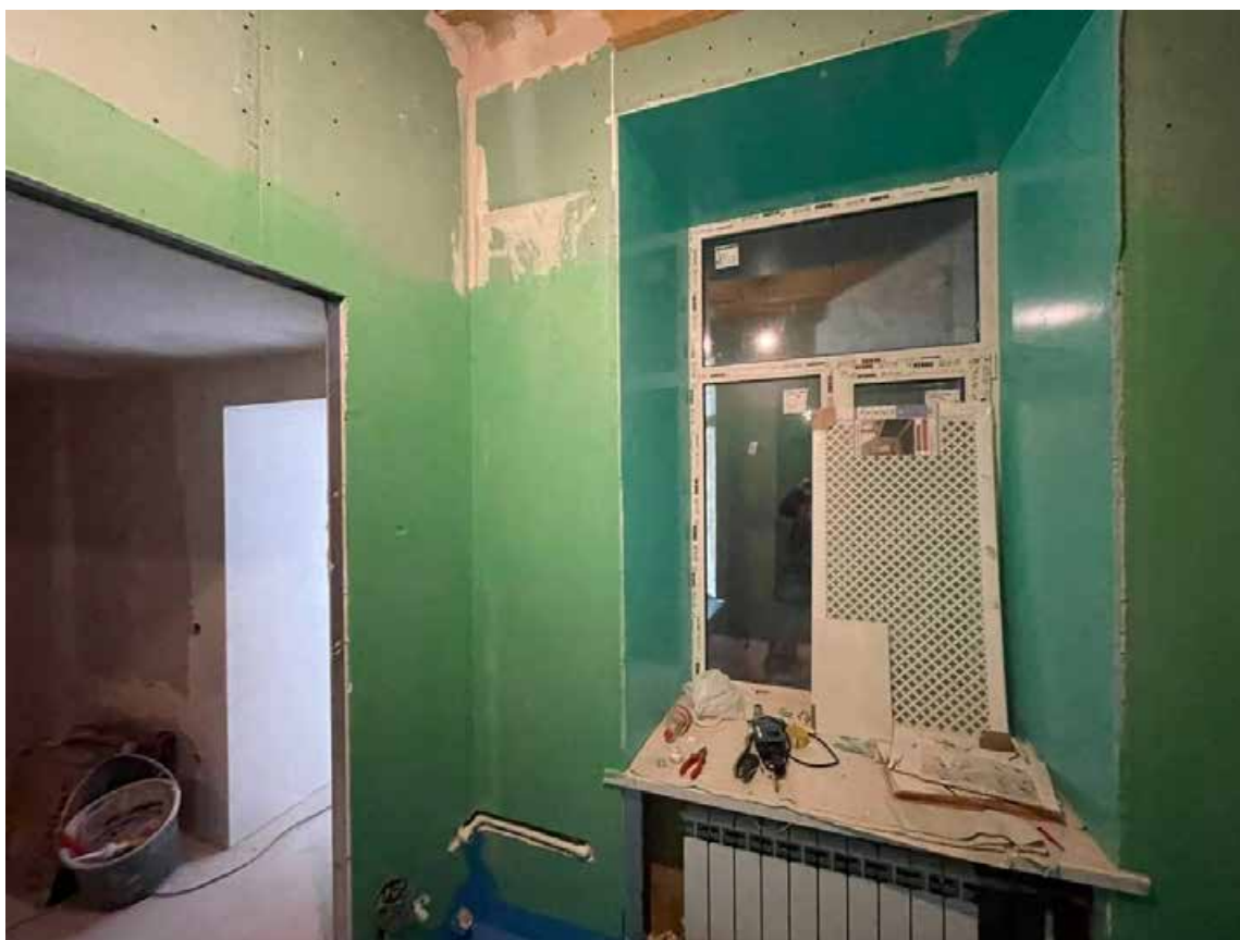
Фото 32. Интерьер квартиры № 4 объекта культурного наследия регионального значения «Доходный дом А.Г. Покровской (Я.И. Шика)»
