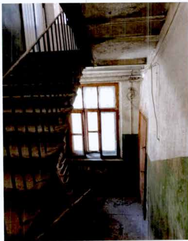
17. Интерьер объекта культурного наследия. Помещение № 4ЛК (фото от 25.04.2024).
