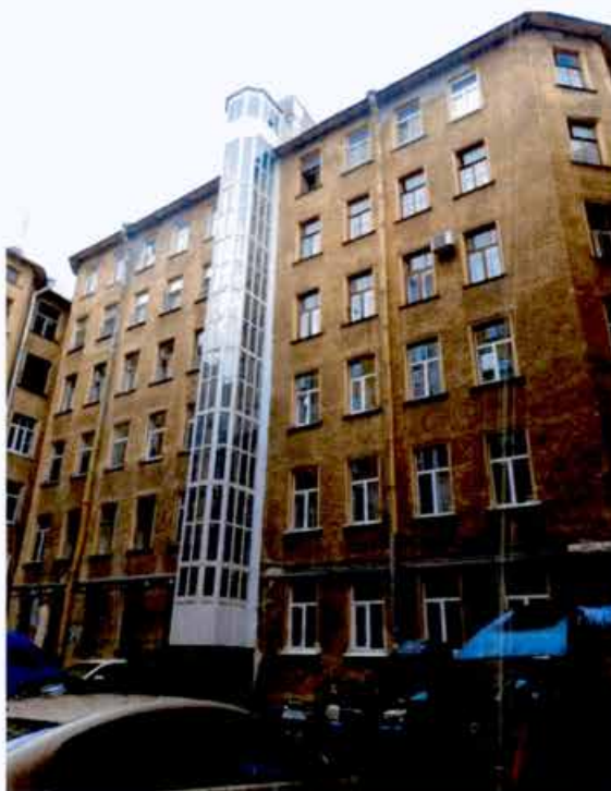
4. Общий вид юго-восточного дворового фасада объекта культурного наследия (фото от 12.07.2024).
