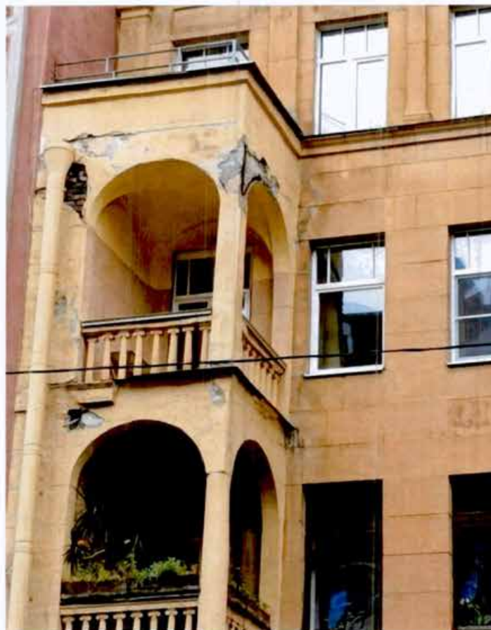
8. Фрагмент лицевого фасада объекта культурного наследия (фото от 12.07.2024).
