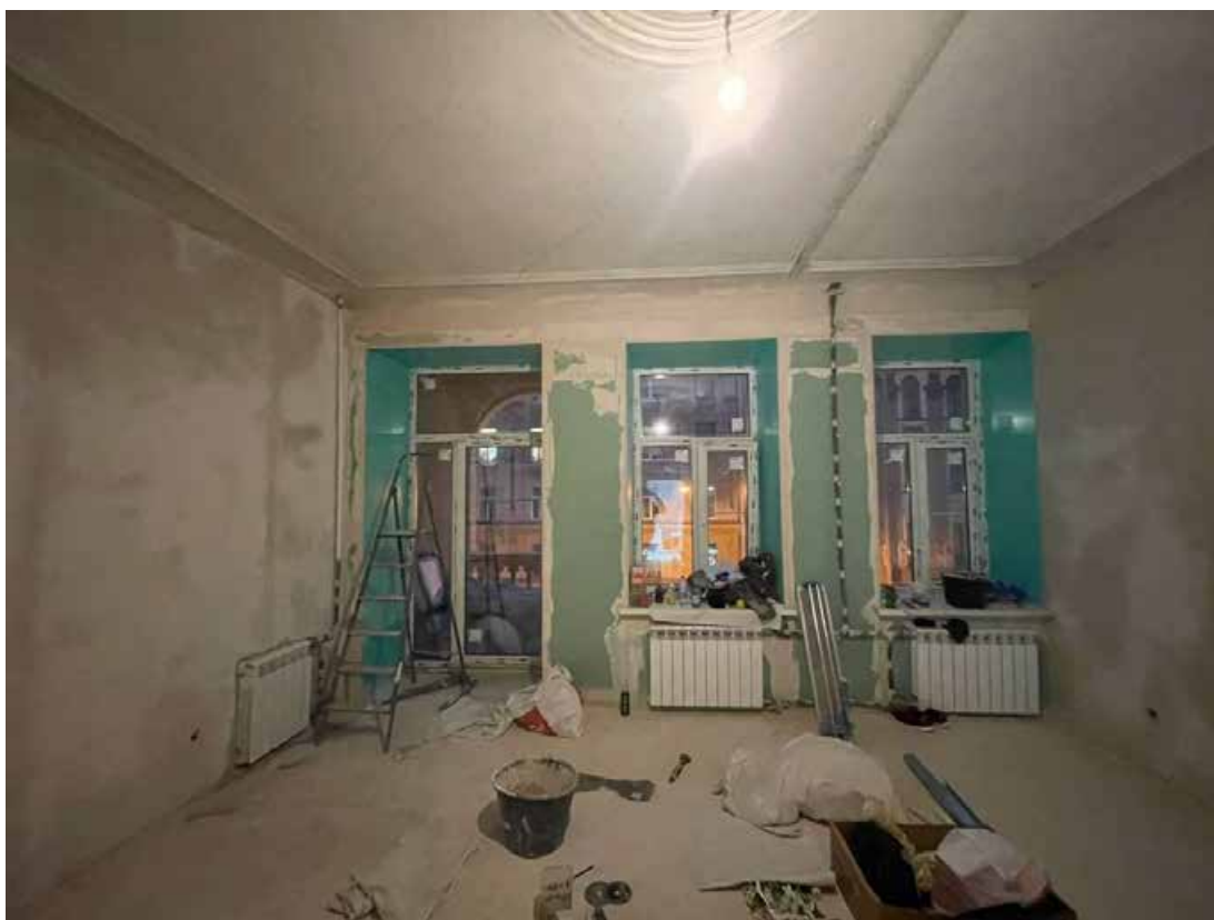
Фото 30. Интерьер квартиры № 4 объекта культурного наследия регионального значения «Доходный дом А.Г. Покровской (Я.И. Шика)»
