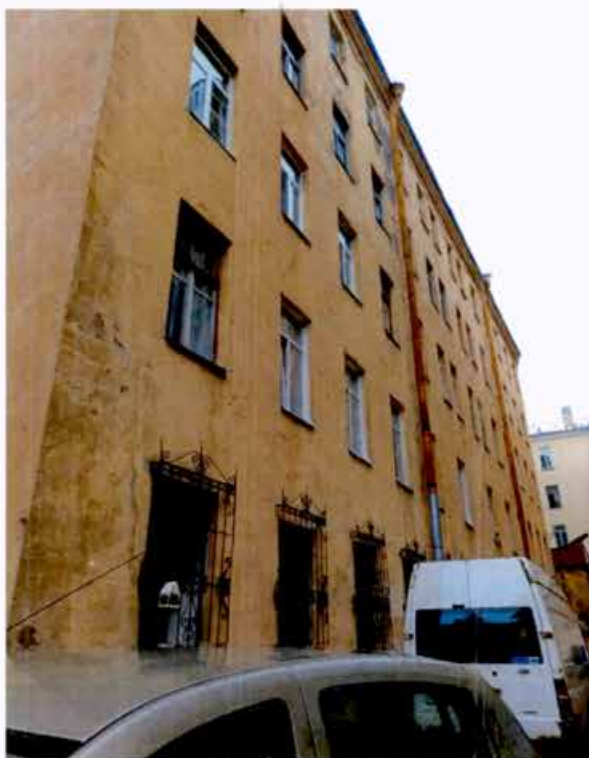
6. Общий вид северо-восточного фасада северо-восточного флигеля объекта культурного наследия (фото от 12.07.2024).
