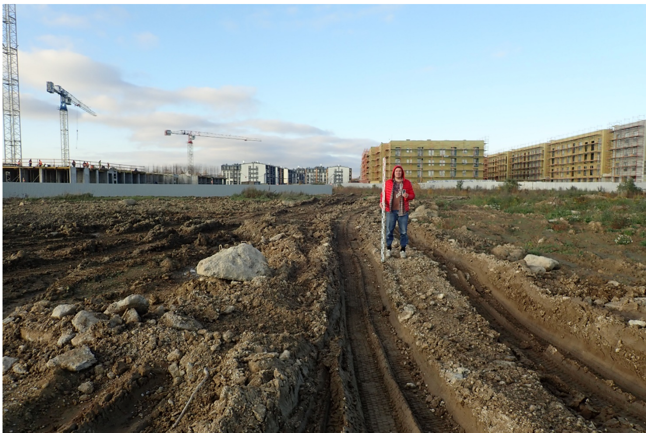
Рис. 15. Санкт-Петербург, город Пушкин, Гуммолосары, участок 91 к/н 78:42:0018222:138. Точка фотофиксации 1. Общий вид нарушений дернового покрова в центральной части участка. Вид с Ю.
