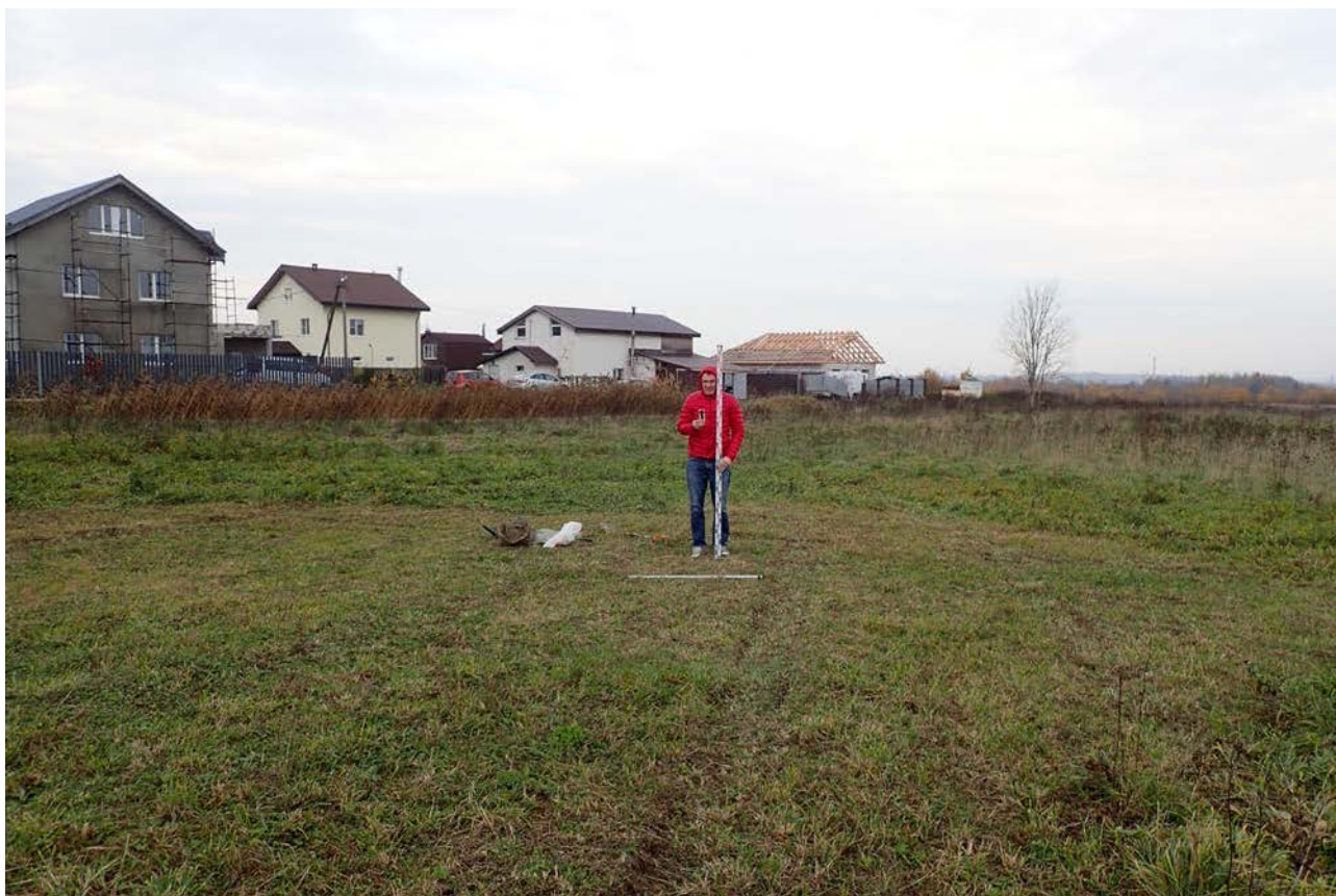
Рис. 21. Санкт-Петербург, г. Пушкин, ш. Киевское. Участок к/н 78:42:1850401:328. Шурф 1. Месторасположение. Вид с Ю.
