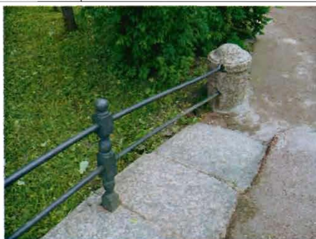
Фото 3. Перильное ограждение моста. Общий вид.
