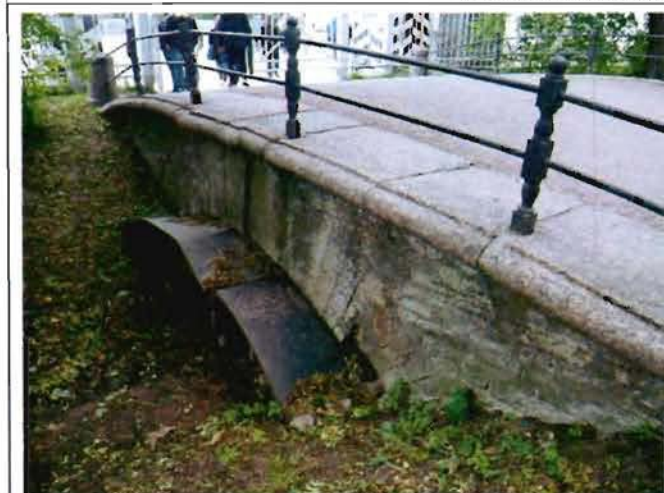
Фото 2. Западный фасад моста. Фрагмент.
