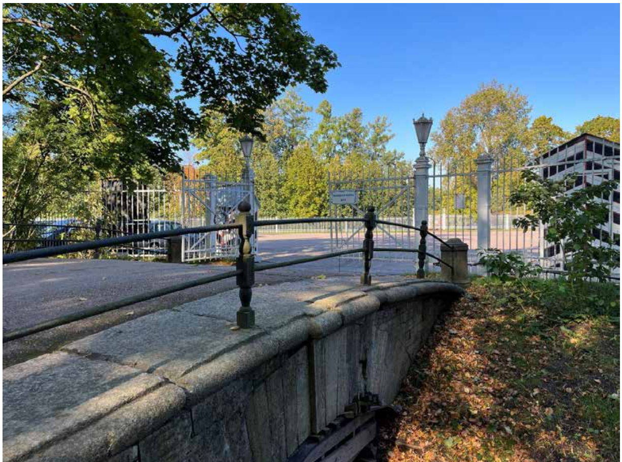
Фото 6. Металлическое перильное ограждение с фигурными вертикальными стойками и горизонтальными направляющими. Фрагмент. Вид с восточной стороны. Дата фотофиксации: 29.08.24
