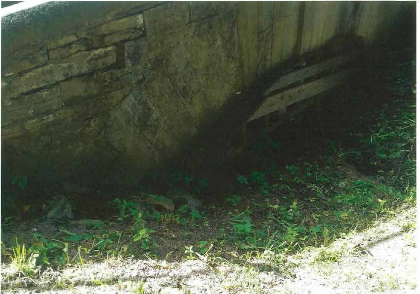
3. Фрагмент восточного фасада.
