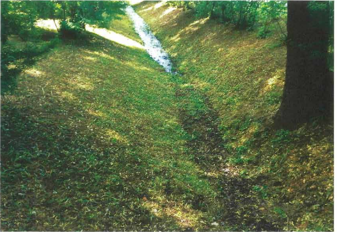
5. Вид на канаву от восточного фасада моста.
