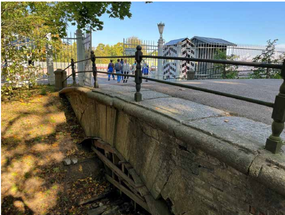
Фото 15. Металлическое перильное ограждение с фигурными вертикальными стойками и горизонтальными направляющими. Фрагмент. Вид с западной стороны. Дата фотофиксации: 29.08.24
