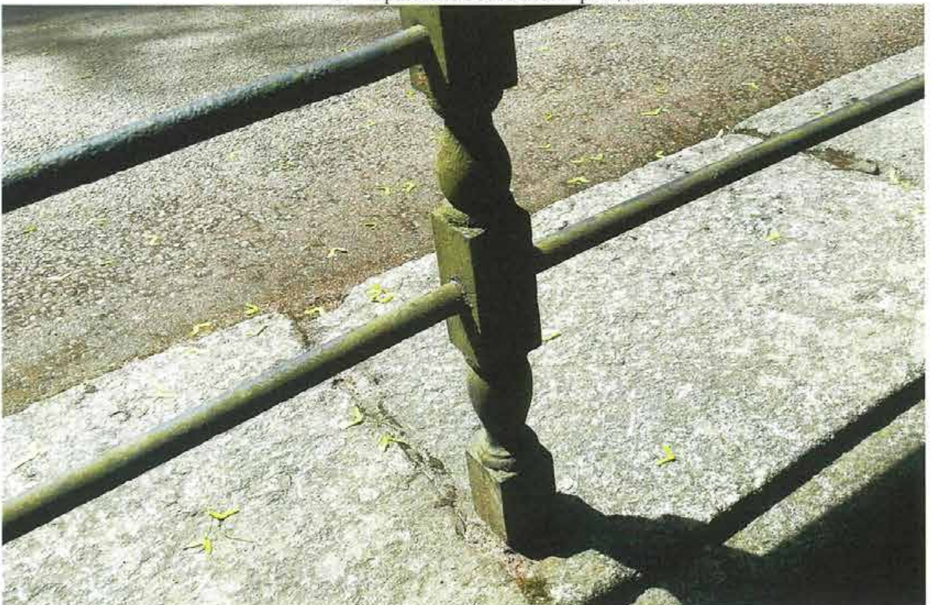
4. Фрагмент перильного ограждения.
