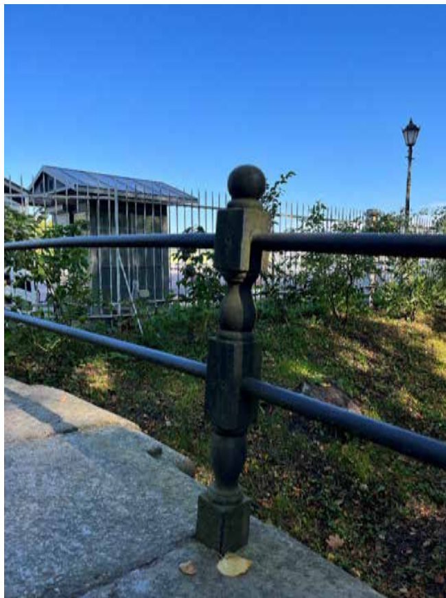
Фото 9. Фигурная вертикальная стойка. Общий вид. Восточная сторона. Дата фотофиксации: 29.08.24
