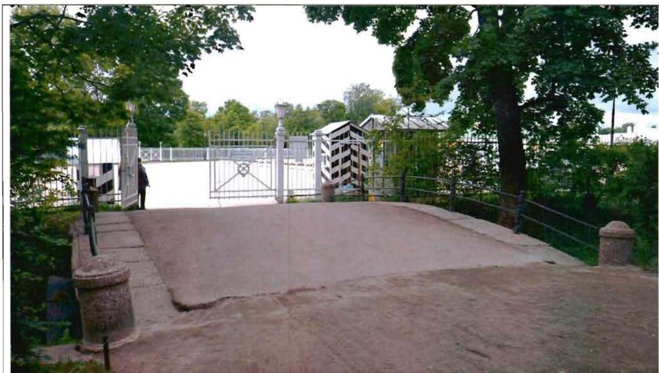
Фото 1. Общий вид моста с южной стороны.
