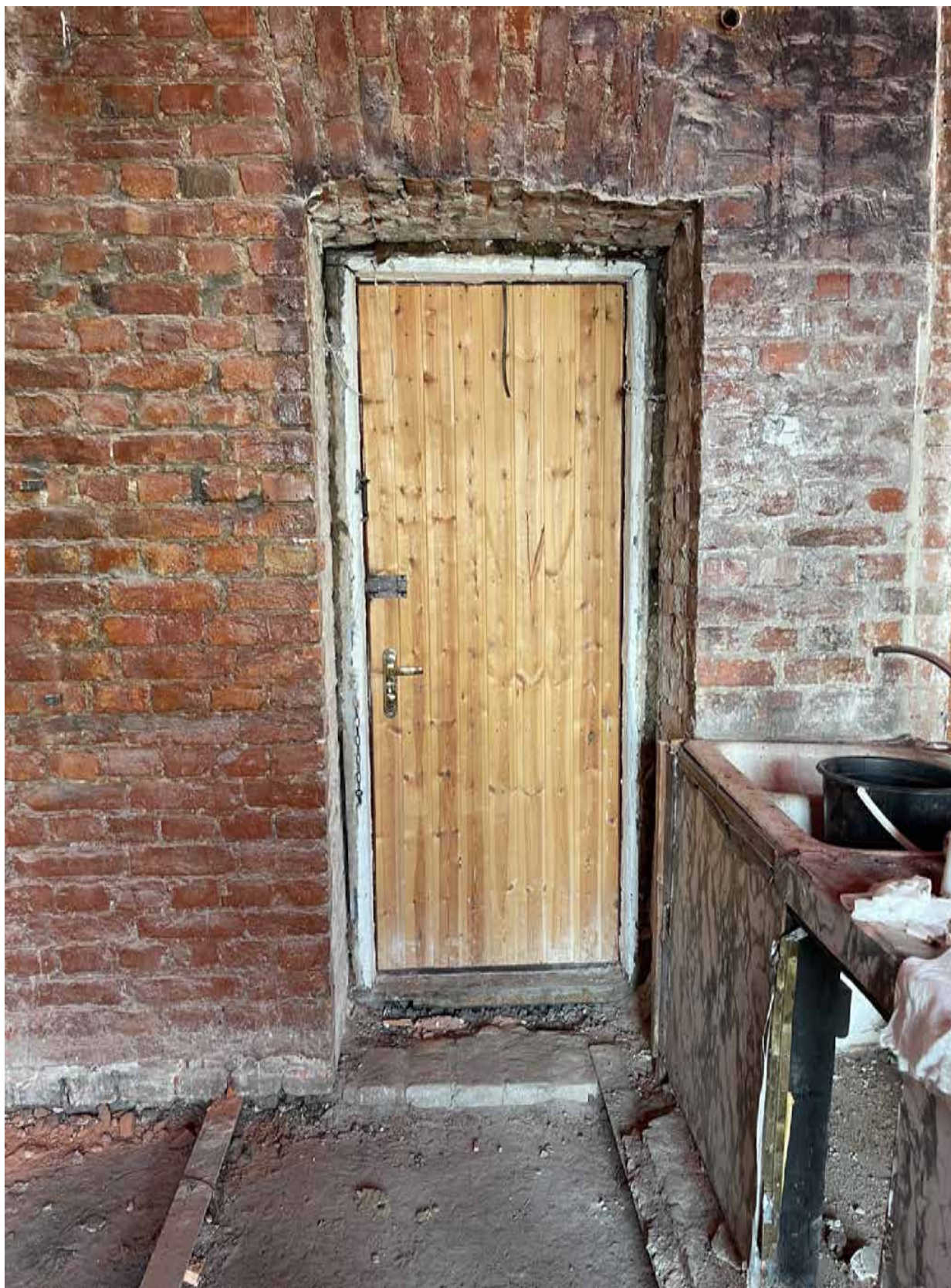
8. Вид на входную дверь в квартире.
