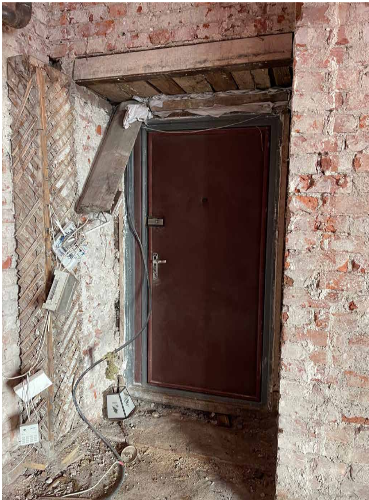
4. Вид на входную дверь в квартире;
