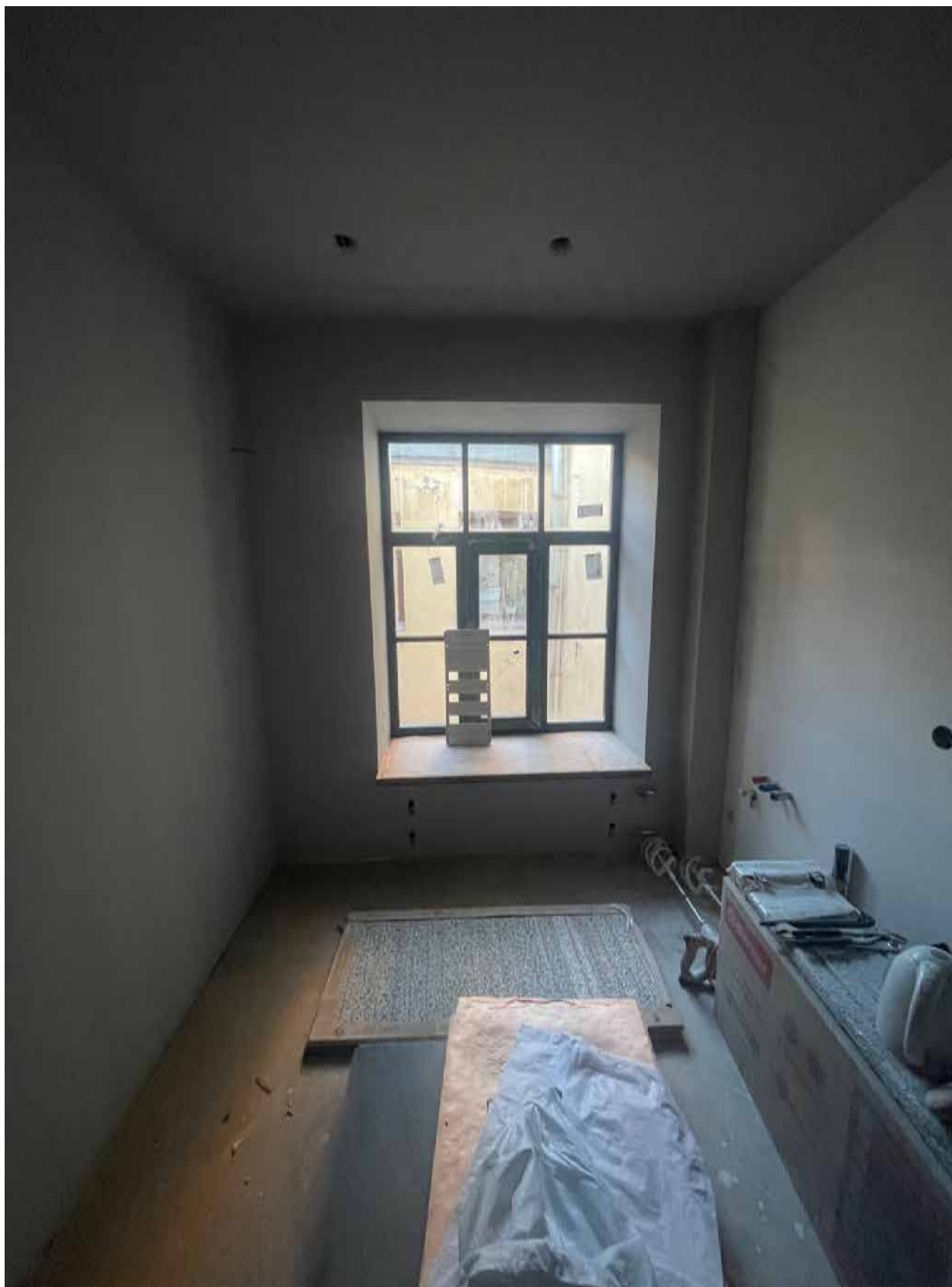
9. Фрагмент интерьера кухни (помещение 2/8.7).
