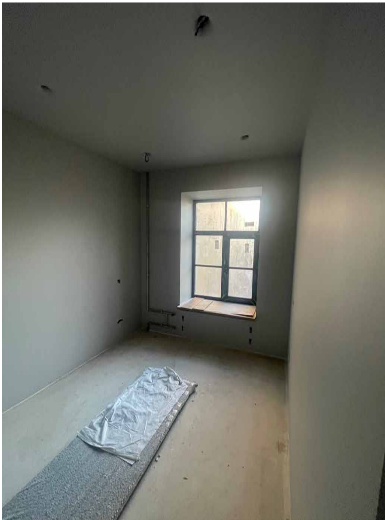
8. Фрагмент интерьера комнаты (помещение 3/10.2);
